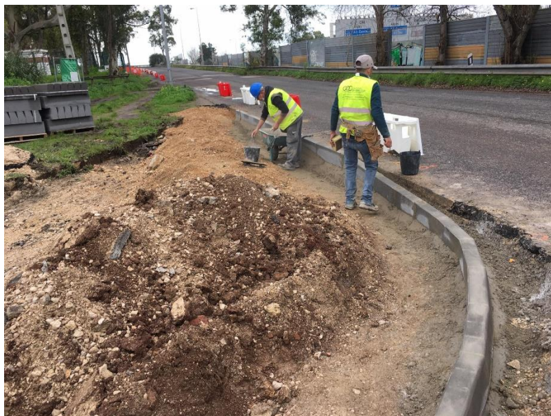
Foto 6. Execução do lancil e remoção do pavimento no Troço 5.
