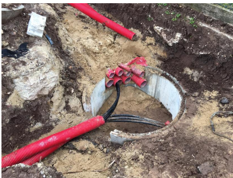
Foto 2. Aplicação dos cabos de eletricidade no Troço 2.
