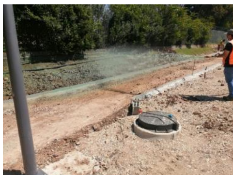
Figura 4-56 – Execução de prado de sequeiro (troço 2)
