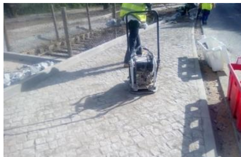
Figura 4-13 – Compactação de cubo de granito (troço 6)
