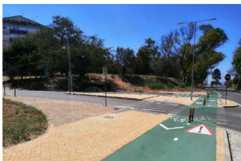
Figura 4-14 – Bloco de betão do tipo PAVE (troço 5)
