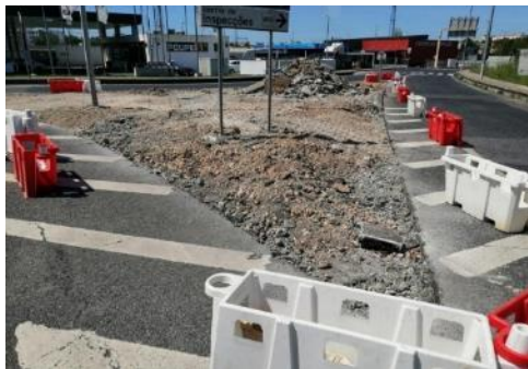
Figura 4-2 – Movimento de terras para betão betuminoso em zonas viárias (troço 8)
