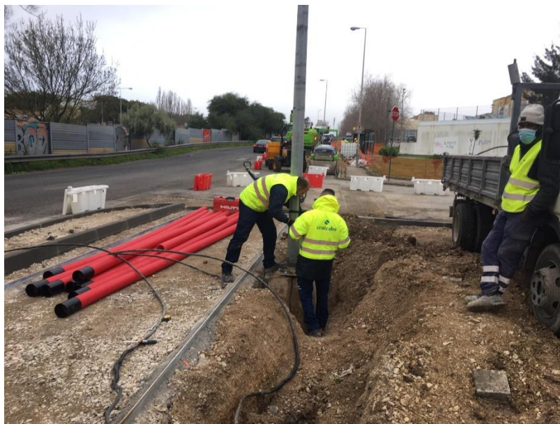
Foto 5. Reposicionamento do poste de iluminação no Troço 5.
