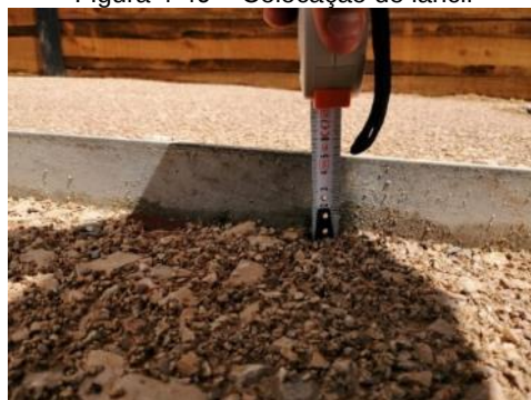
Figura 4-51 – Verificação da espessura da camada
