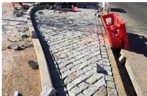
Figura 4-12 – Execução de cubo de granito (troço 6)
