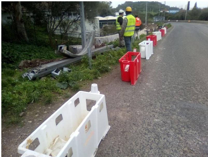
Foto 3. Remoção do rail no Troço 3.
