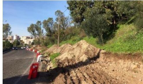
Figura 4-5 – Escavações para abertura de plataforma (troço 4)
