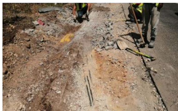
Figura 4-29 – Tritubos da concessionária Altice no troço 8
