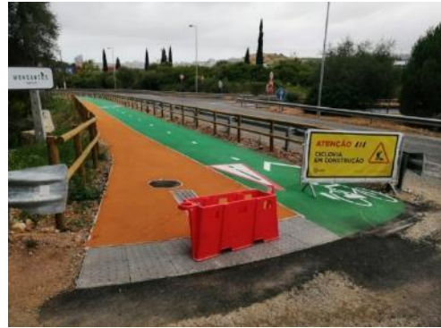
Figura 4-19 – Pinturas nas cores Verde e Ocre (troço 3)
