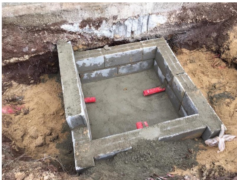
Foto 3. Execução da caixa de visita da IP no Troço 2.
