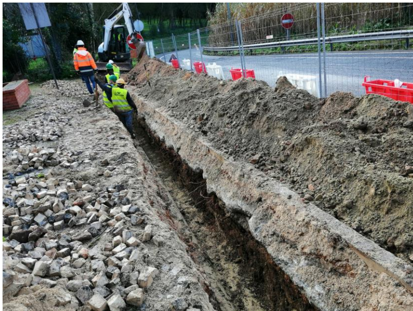
Foto 1. Execução da vala da MT no Troço 1.
