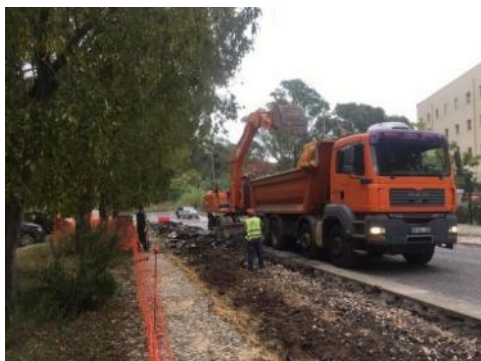
Figura 4-44 – Demolição do pavimento em betão betuminoso (troço 1)
