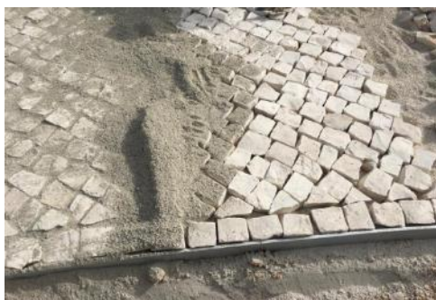
Figura 4-10 – Execução do cubo de vidro (troço 1)
