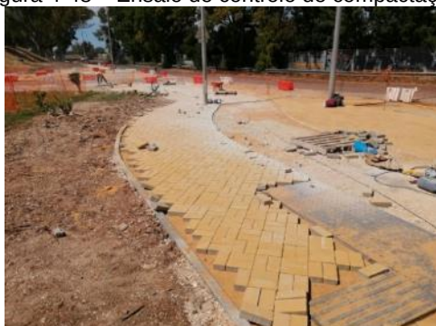
Figura 4-50 – Pavimento em bloco de betão - PAVE
