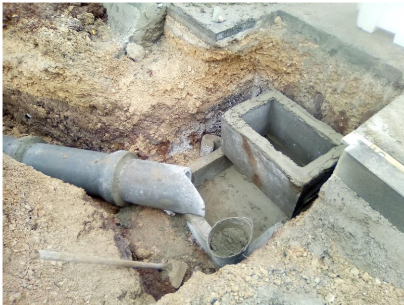
Foto 5. Execução da drenagem no Troço 5.
