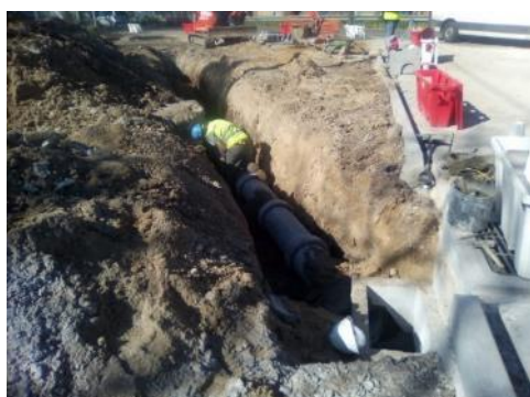
Figura 4-58 – Trabalhos de drenagem (troço 5)
