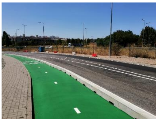
Figura 4-60 – Medição lancil perfurado no local (troço 8)
