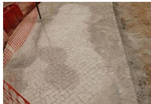
Figura 4-11 – Cubos de vidro compactados (troço 1)
