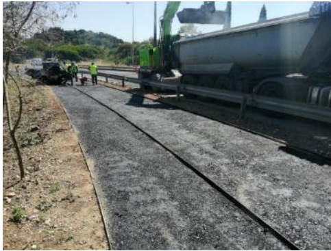
Figura 4-18 – Pavimento em betão betuminoso (troço 3)
