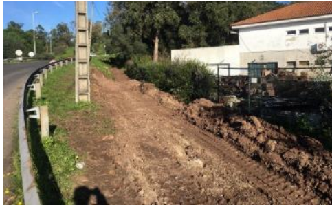
Figura 4-4 – Escavações para a execução de muro de gabião (troço 3)
