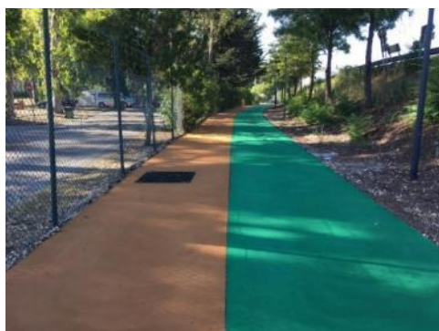
Figura 4-52 – Pintura dos pavimentos
