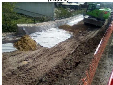
Figura 4-47 – Execução de aterro (troço 3)
