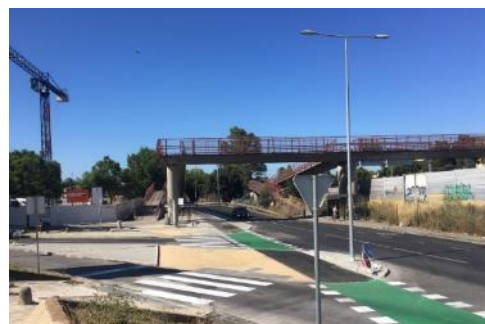
Figura 4-15 – Bloco de betão do tipo PAVE (troço 6)
