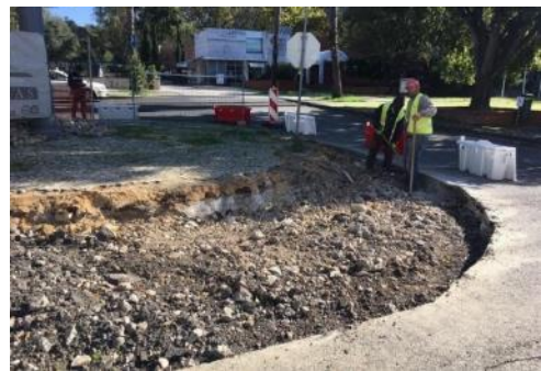
Figura 4-3 – Movimento de terras para os cubos de vidro no troço 1
