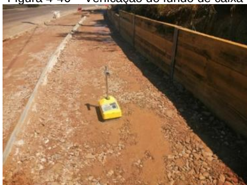
Figura 4-48 – Ensaio de controlo de compactação
