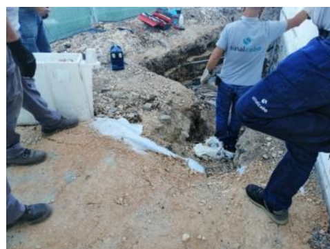
Figura 4-59 – Trabalhos de eletricidade (troço 7)
