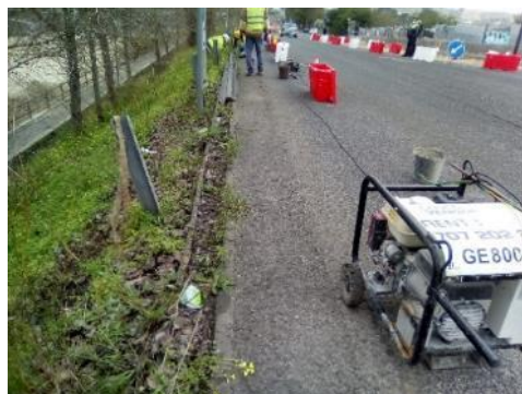
Figura 4-45 – Levantamento da barreira de segurança (troço 6)
