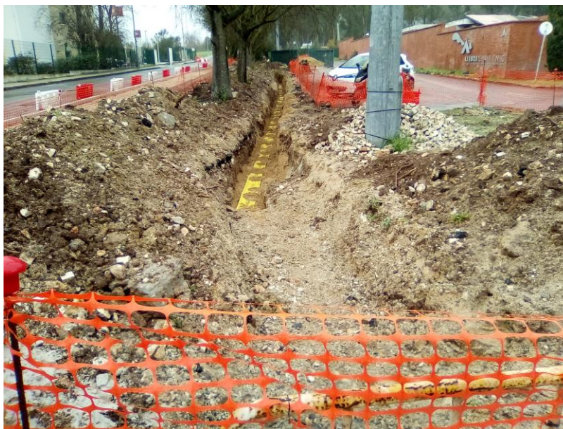
Foto 1. Vala de eletricidade com cabo aplicado no Troço 1.
