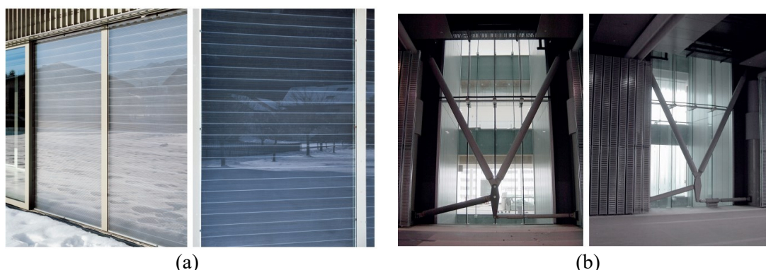
Figura 2.1.3.4 – Exemplos de aplicação de materiais inteligentes na construção civil: (a) Vidros com inclusões de material com mudança de fase para armazenamento de calor latente, instalado numa Residência Sénior em Domat/Ems, Suíça. Adaptado de [41, p. 172]; (b) Amortecedor sísmico com fluido magnetoreológico instalado no Museu Nihon-Kagaku-Miraikan em Tokyo, Japão. Adaptado de [41, p. 39].
