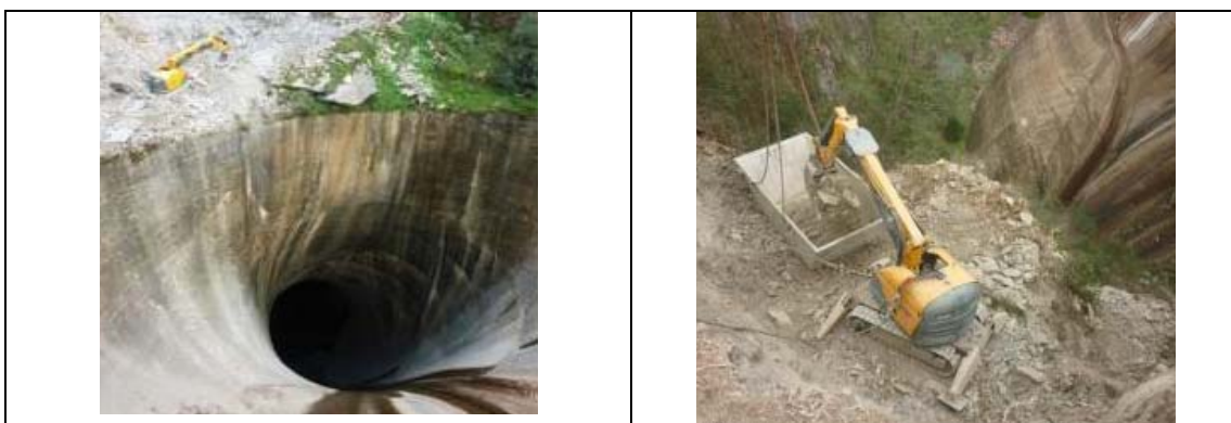
Figura 6 e 7 - Escavação com a Giratória Robotizada na base do talude (descarregador)
