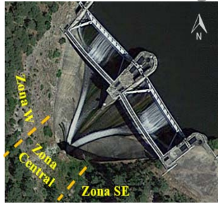
Figura 1 - Vista Aérea do Descarregador
