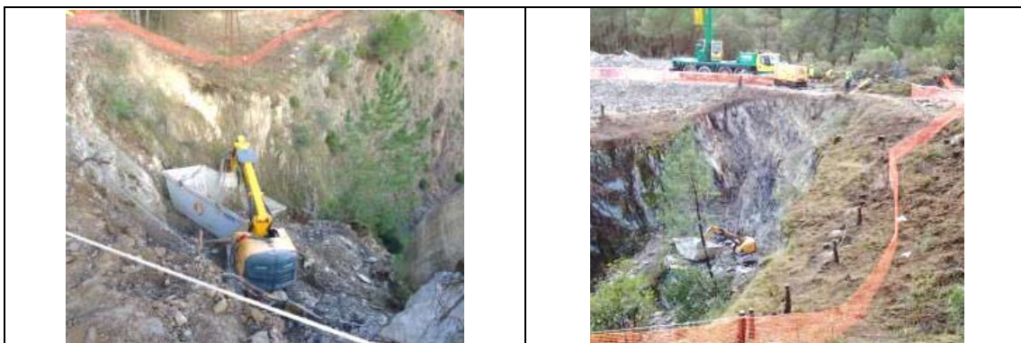
Figura 4 e 5 - Escavação na Zona Central com a Giratória Robotizada
