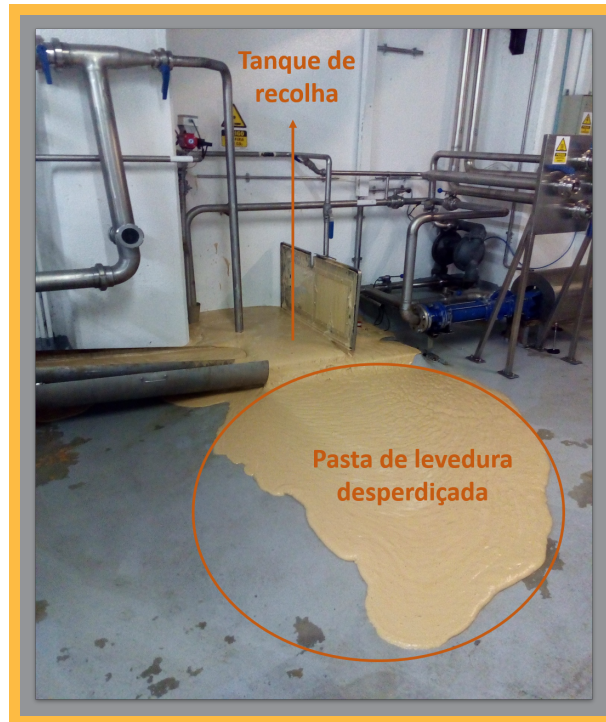
Figura 4.20 Resultado da falta de controlo do nível de pasta de levedura no tanque de recolha das descargas das centrifugadoras.
