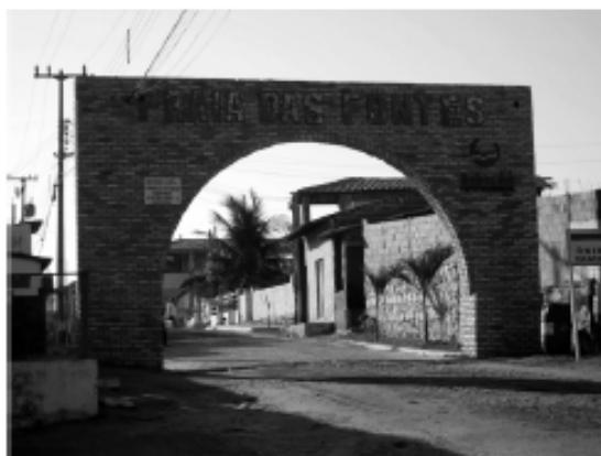
Figura 45 – Portão de entrada [2]
