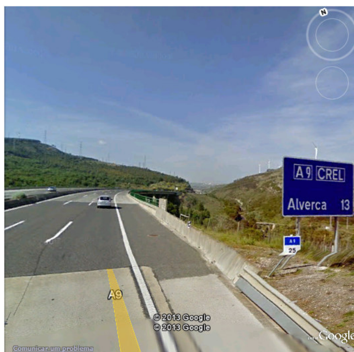
Figura 16 – Troço A9 (km 25+000) [15]
