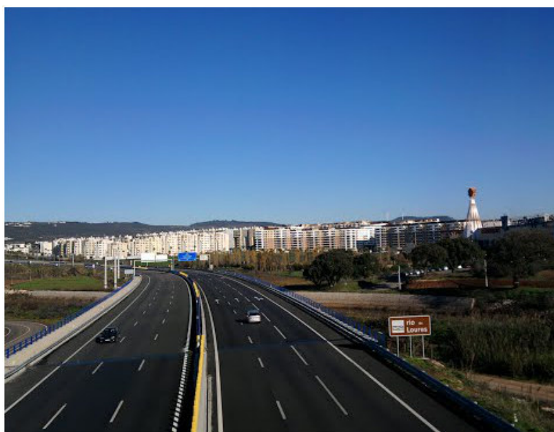
Figura 15 – Troço A8 (km 7+000) [14]
