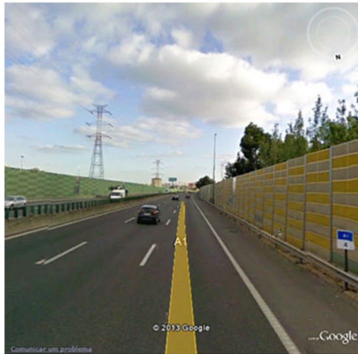
Figura 14 – Troço A1 (km 4+000) [13]
