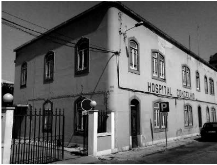
Figura 15. Hospital concelhio Fonte: http://estoriasdeoutrosvelhos.blogspot.pt/2007/05/o-hospital.html , Início Séc. XXI
