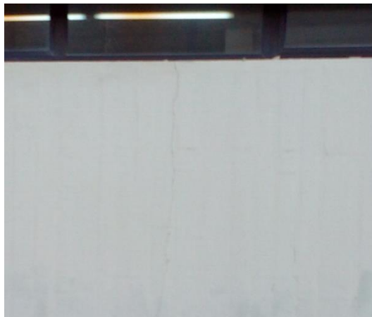
Figura 4 - Fachada sem revestimento de peças pré-fabricadas
