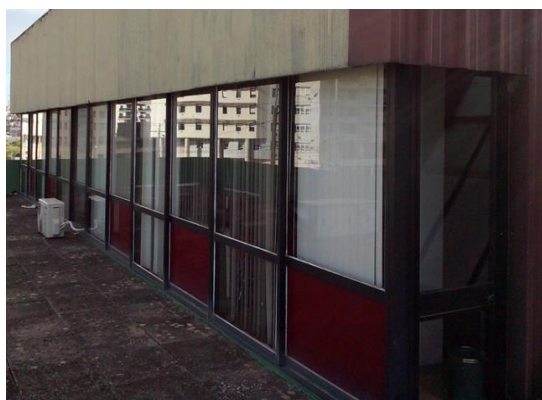
Figura 9 - Vãos envidraçados com 2,5 metros de altura
