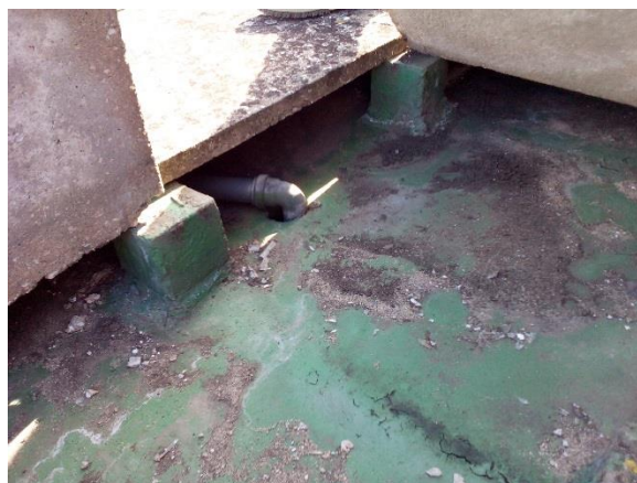
Figura 3 Sistema de cobertura existente (impermeabilização, apoios e lajetas, tubo de queda)
