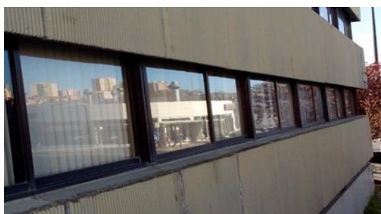
Figura 10 - Vãos envidraçados com 1,5 metros de altura
