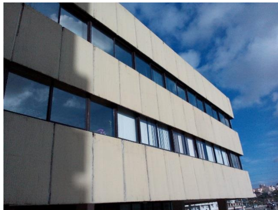
Figura 2 Fachada revestida com painéis pré-fabricados
