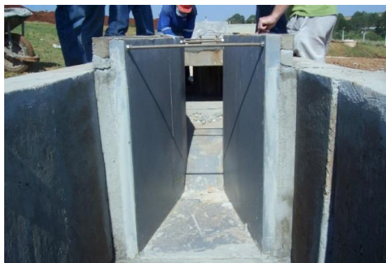
Figura 2.6 - Canal Parshall da ETAR Leste
