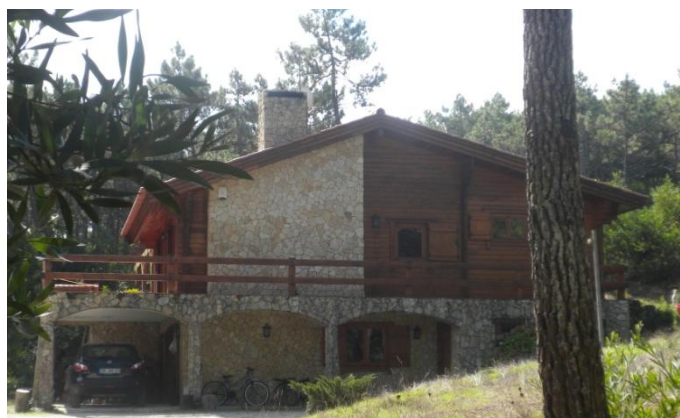
Figura 2.7 - Exemplo de um edifício em troncos maciços de madeira
