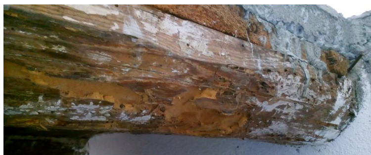
Figura 2.14 - Pormenor de uma viga infestada por caruncho
