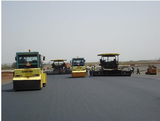
Figura 3.10 –Compactação de uma camada betuminosa.
