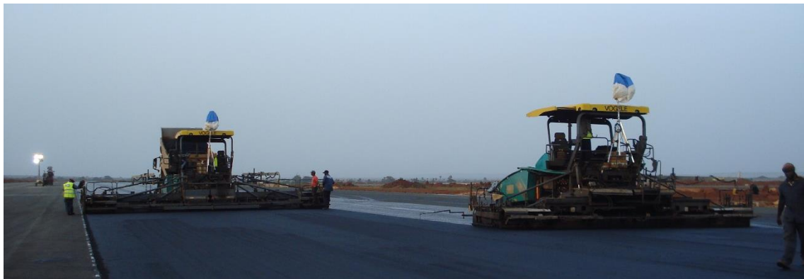
Figura 3.8 – Espalhadoras a pavimentar o “Runway” com 21 metros em junta quente
