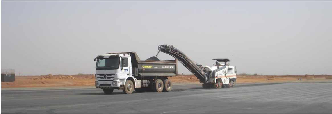
Figura 3.13 – Correção altimétrica da camada betuminosa
