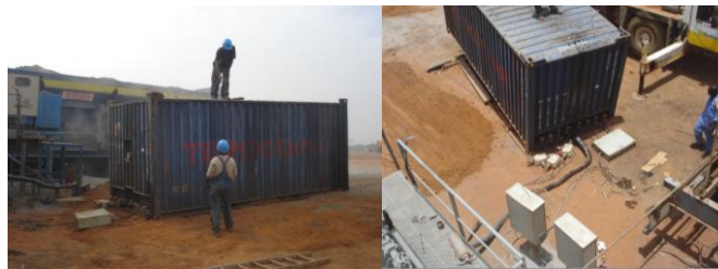
Figura 2.9 – Aquecimento dos contentores de betume
