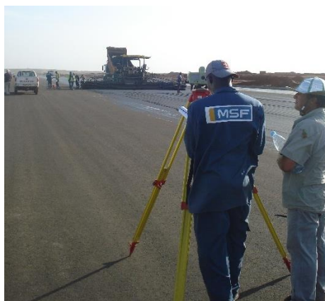
Figura 3.29 – Controlo altimétrico das camadas betuminosas durante a pavimentação
