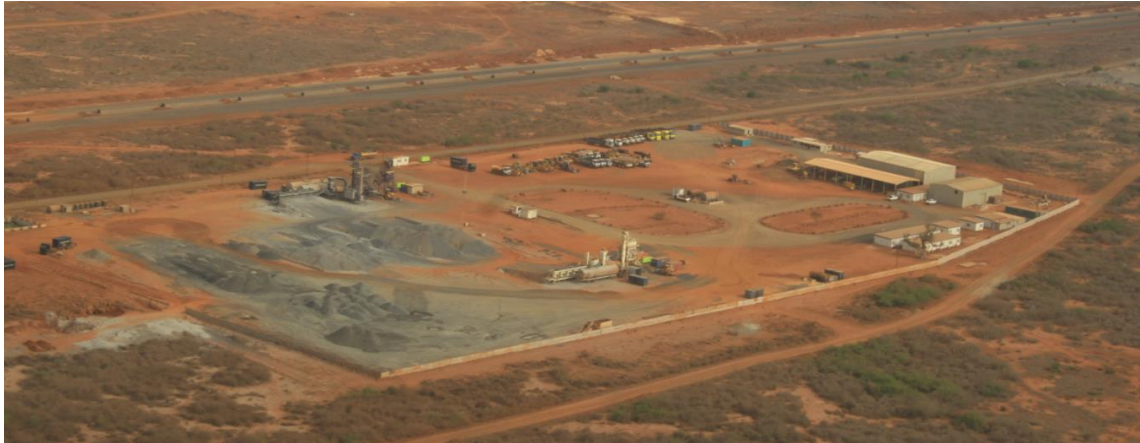
Figura 1.5 – Vista área do estaleiro da MSF Engenharia
