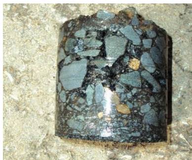
Figura 3.28 – Carote executado na camada de macadame
