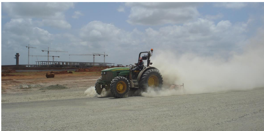
Figura 3.9 – Trator com vassoura a realizar limpeza na camada de ABGE
