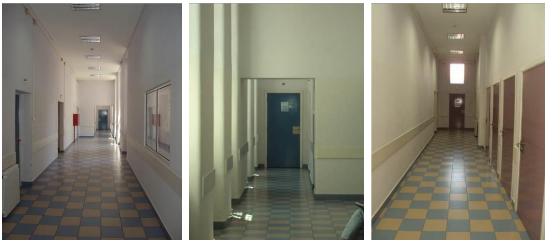
Figura 24: Corredores do interior do edifício (Fonte: Autor, 2016)
