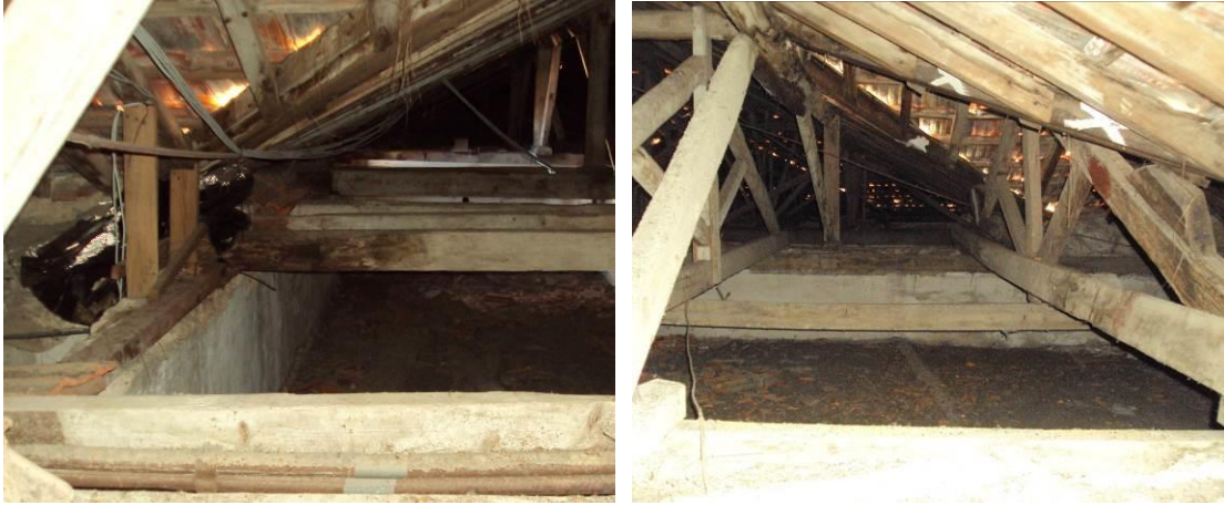
Figura 33: Estrutura de madeira da cobertura (Fonte: Autor, 2016)
