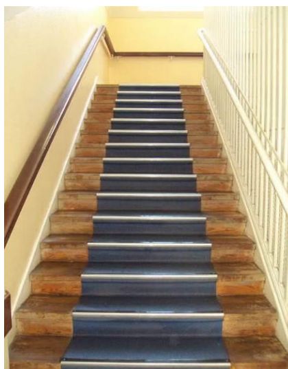
Figura 32: Escadas interiores de acesso ao piso 1 (Fonte: Autor, 2016)
