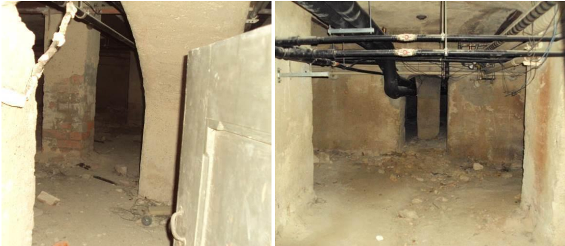
Figura 21: Vista geral da cave (Fonte: Autor, 2016)
