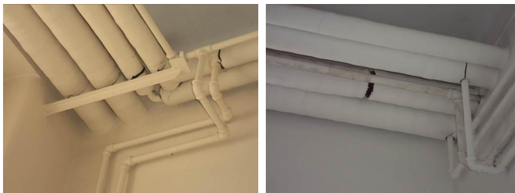
Figura 31: Canalização existente junto ao teto do piso 1 (Fonte: Autor, 2016)
