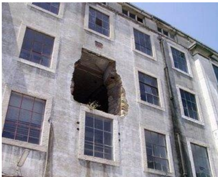
Figura 5 – Imagem de um edifício no LXF titulado como: “Um buraco na parede. Porquê tapar? Haverá sempre luz” Fonte: (Vale & Silva, s.d.)
