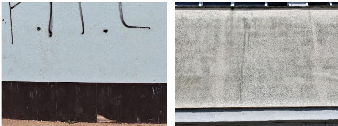
Figura 3.15 – Efeitos da presença de anomalias por vandalismo (à esquerda) e por termoforese (à direita)
