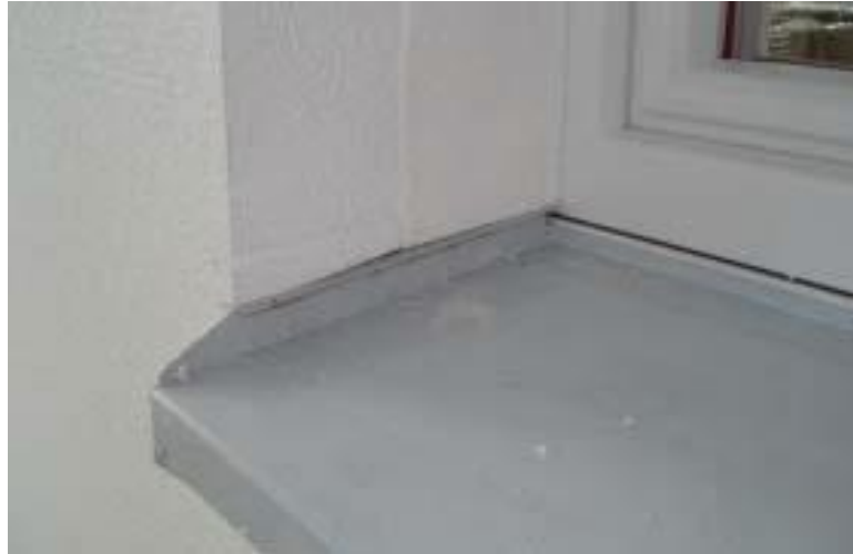
Figura 4.6 – Pormenor nos parapeitos para evitar escorrimentos laterais (Weber, 2018)
