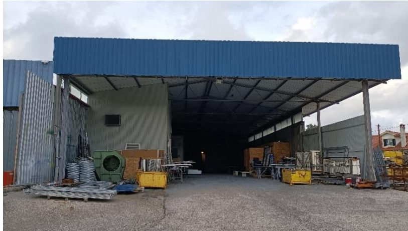
Figura 3.10 - Pavilhão de Tratamentos de Superfície.
