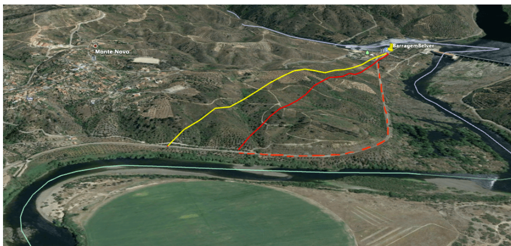
Figura 4.10: Estrutura montanhosa na zona de cobertura da estação base Barragem Belver.
