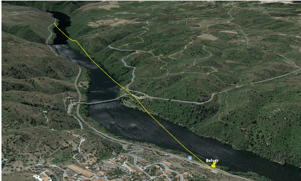
Figura 4.17: Obstruções no percurso da estação base Belver.
