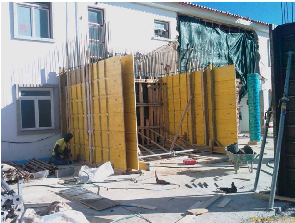
Fotografia 12 - Centro de Saúde de Mora – Caixa de elevador
