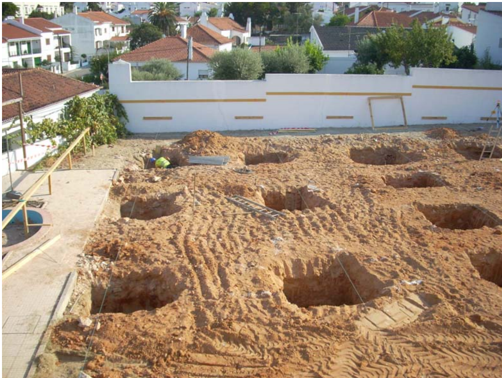
Fotografia 7 - Centro de Saúde de Mora – Abertura de fundações
