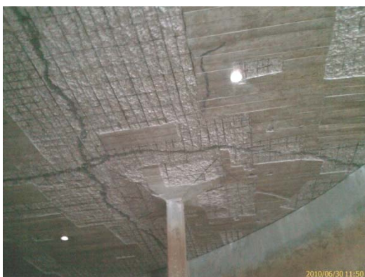
Fotografia 64 – Brandoa Média Saneamento de betão e injeção de fissuras
