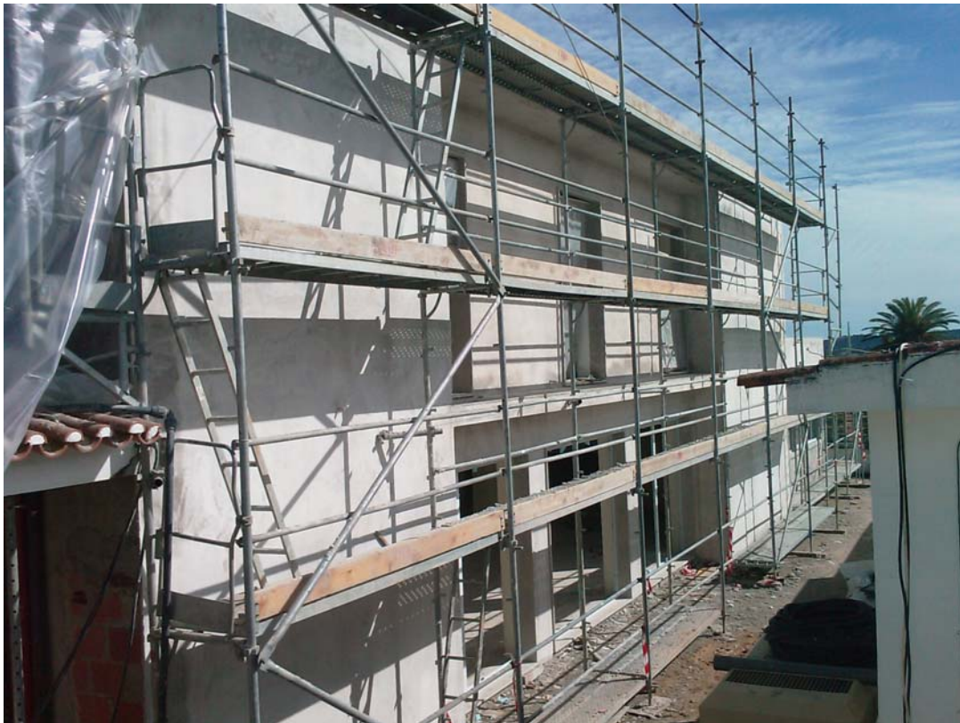
Fotografia 21 - Centro de Saúde de Mora – Fachada posterior
