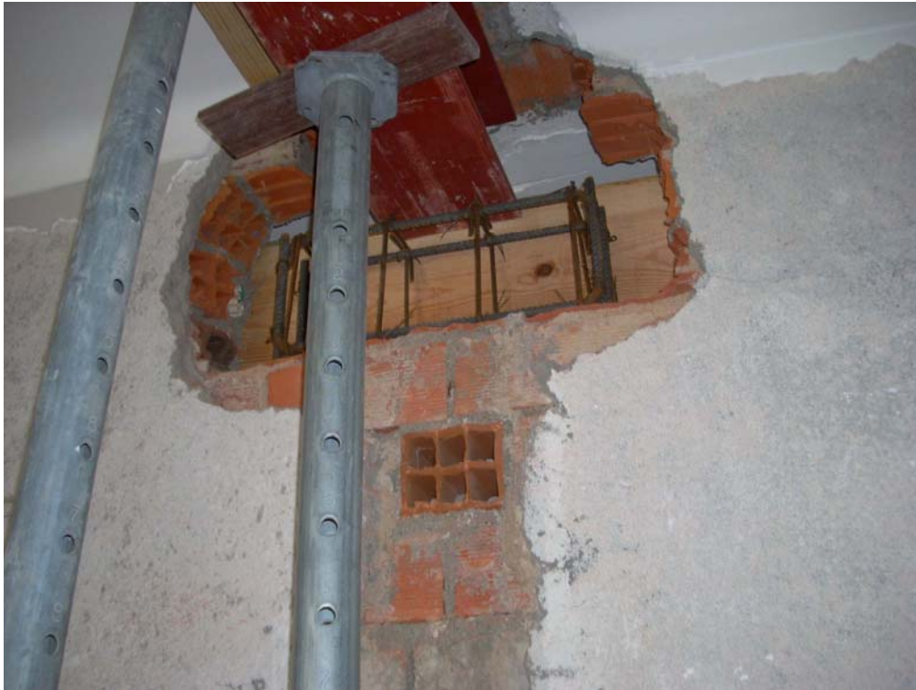
Fotografia 9 - Centro de Saúde de Mora – Lintel para apoio do perfil HEB
