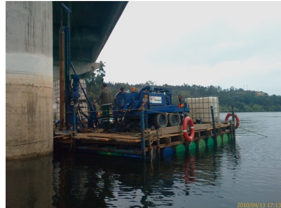
Fotografia 42 – Inspeções Agueira Plataforma flutuante na Ponte do Cunhedo
