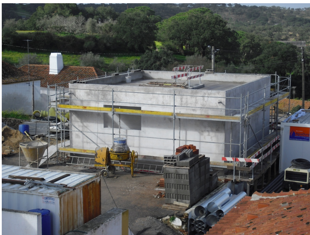
Fotografia 20 - Centro de Saúde de Mora – Edifício Técnico
