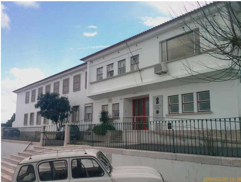
Fotografia 1 - Centro de Saúde de Mora - Fachada Principal
