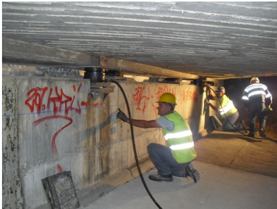
Fotografia 60 – Viaduto sobre o IC12 Levantamento do tabuleiro
