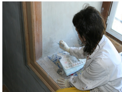
Fotografia 56 – Igreja de Barcarena Restauro da pintura das paredes
