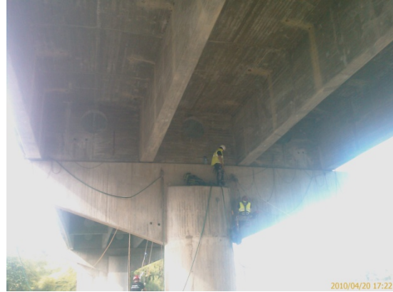
Fotografia 46 – Inspeções Aguieira - Equipa de alpinistas na Ponte de Santa Comba Dão
