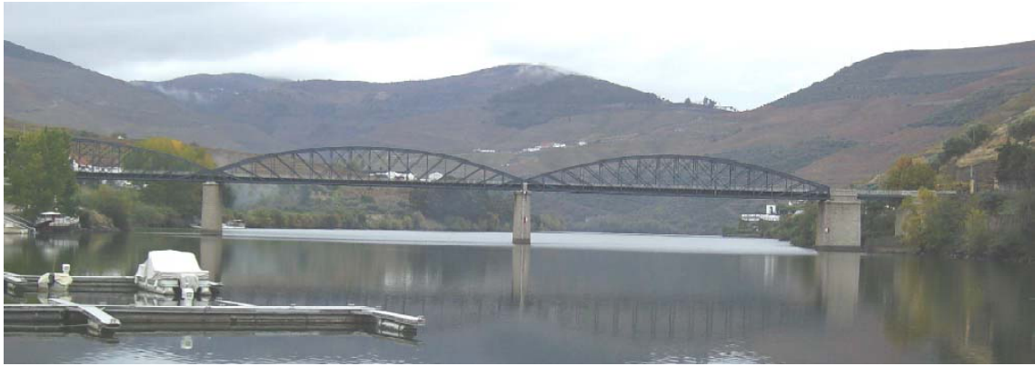
Fotografia 68 – Ponte do Pinhão
