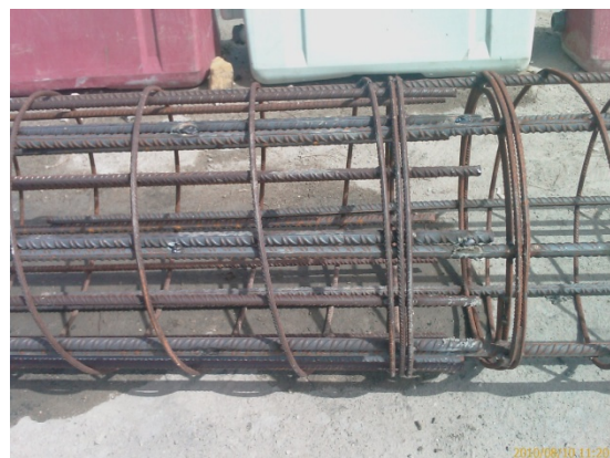
Fotografia 79 – PH Alcácer – Pormenor da armadura
