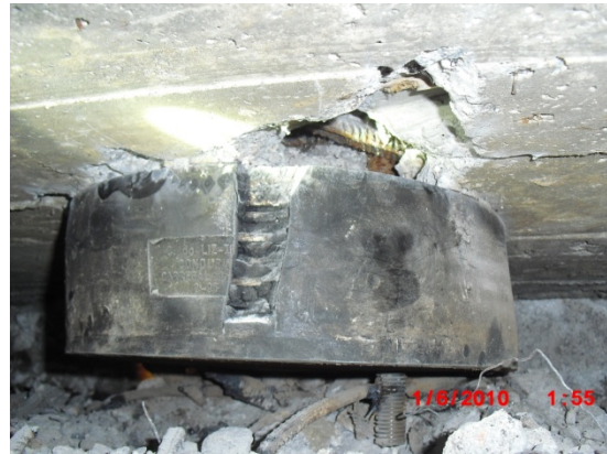
Fotografia 61 – Viaduto sobre o IC12 Aparelho de apoio
