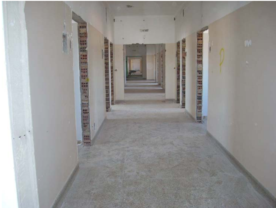
Fotografia 6 - Centro de Saúde de Mora – Piso 1 após remoção das instalações
