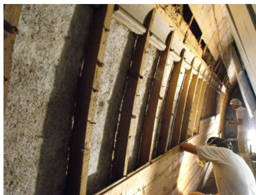
Fotografia 52 – Igreja de Barcarena Colocação de madeira nova em lacunas
