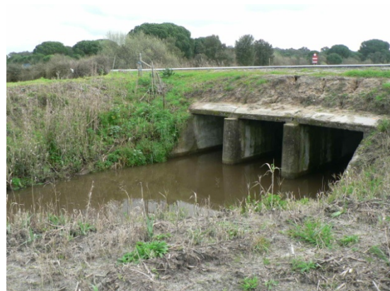
Fotografia 75 – Passagem Hidráulica Vista de jusante
