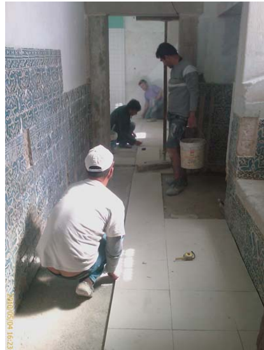
Fotografia 31 – Casa anexa à Sé Nova de Coimbra – Instalação Sanitária
