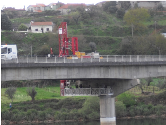
Fotografia 41 – Inspeções Agueira Viatura “By bridge”
