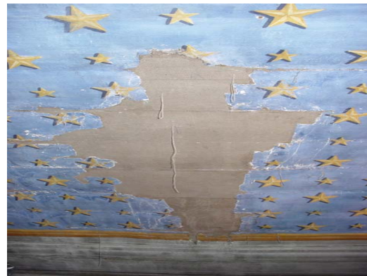
Fotografia 54 – Igreja de Barcarena Remendos e preenchimento de lacunas
