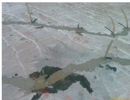
Fotografia 65 – Brandoa Média Saneamento de betão e injeção de fissuras
