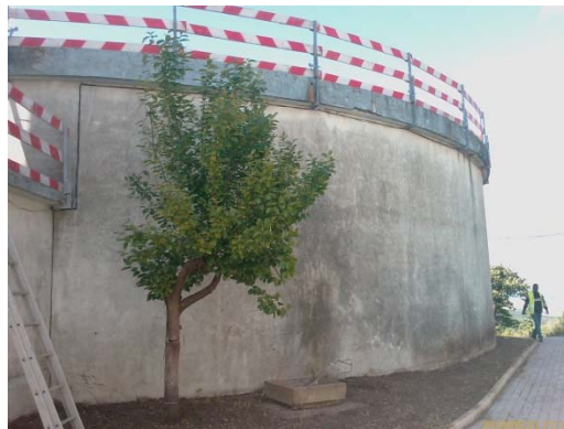
Fotografia 63 – Brandoa Média - Depósito
