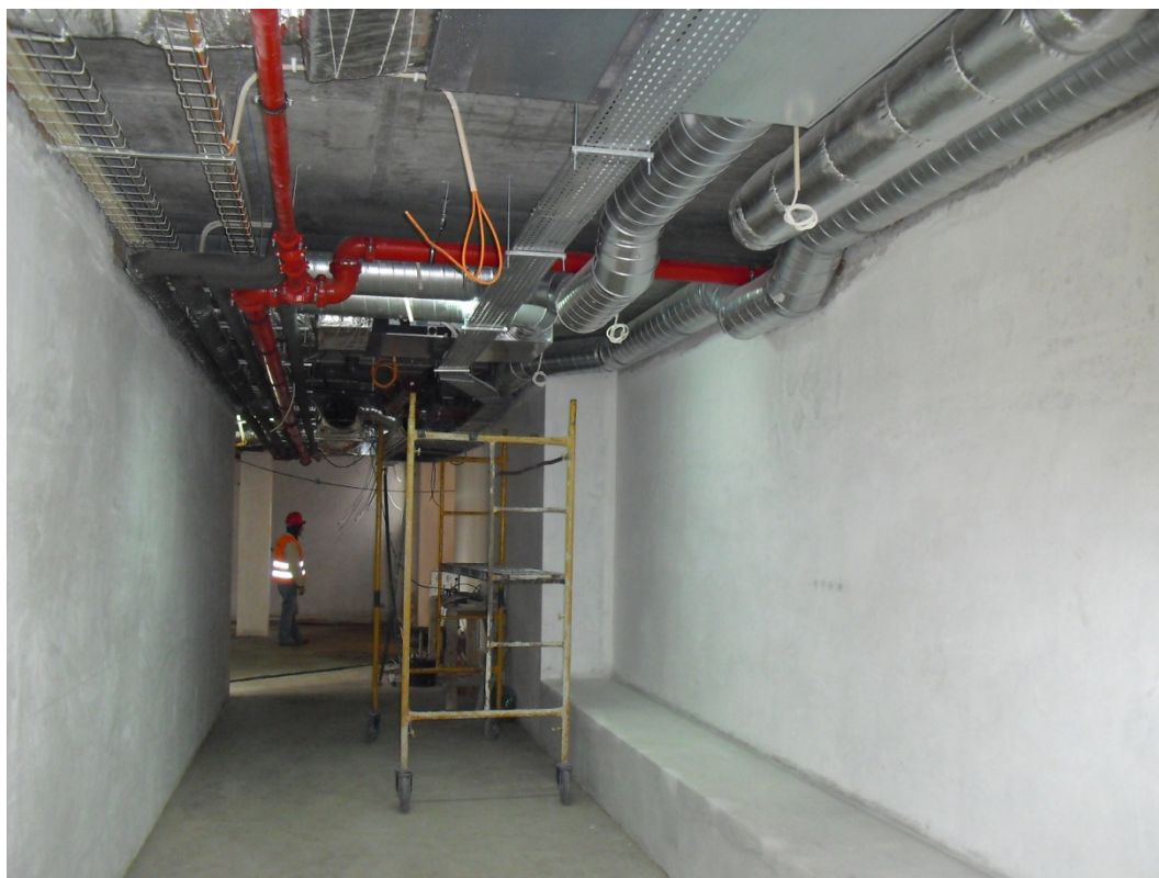
Fotografia 19 - Centro de Saúde de Mora – Infra-estruturas sobre o tecto falso
