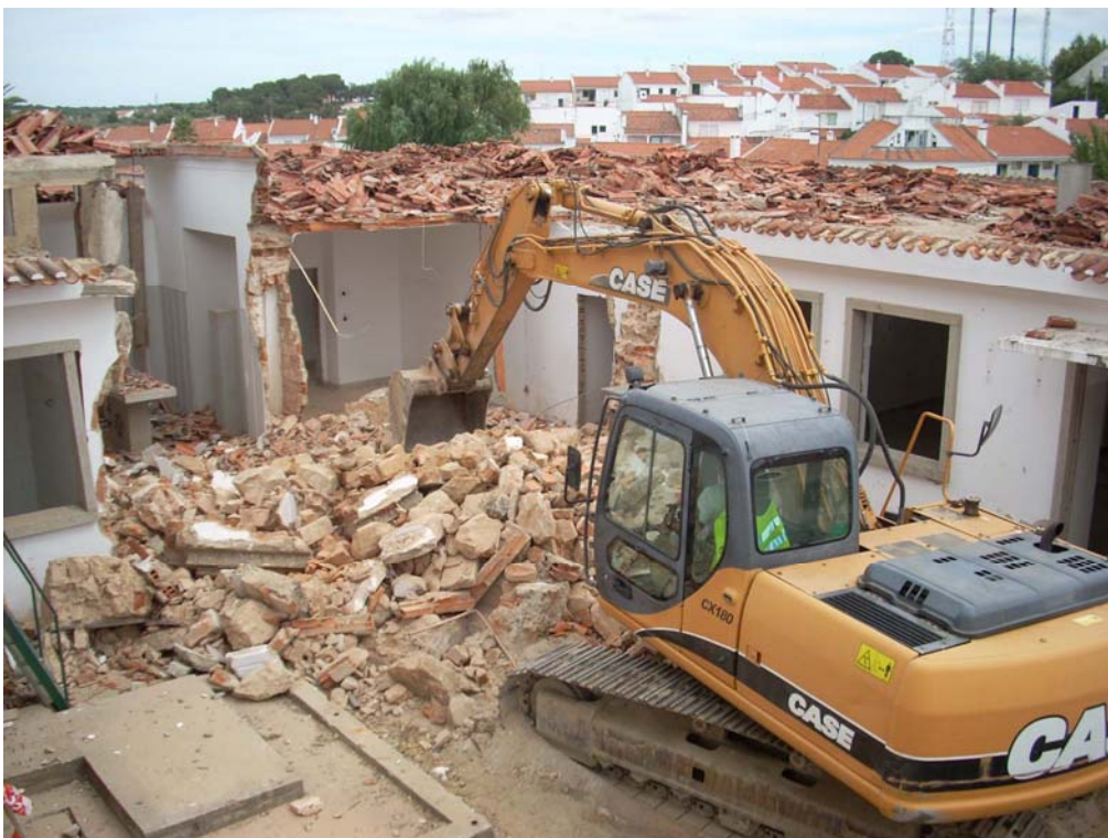
Fotografia 5 - Centro de Saúde de Mora - Demolição
