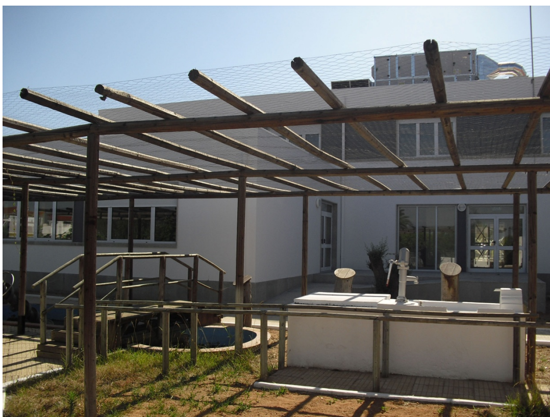
Fotografia 27 - Centro de Saúde de Mora – Alçado lateral esquerdo
