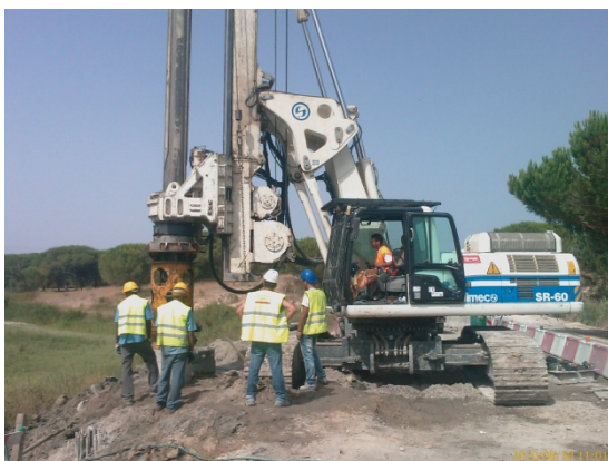
Fotografia 78 – PH Alcácer – Execução de estacas
