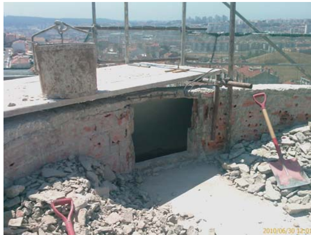
Fotografia 67 – Brandoa Alta – acesso ao interior do depósito
