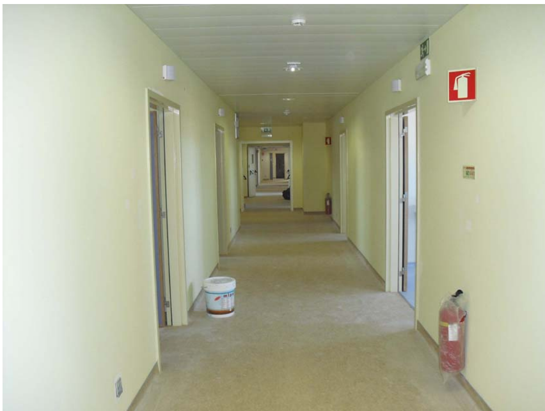
Fotografia 26 - Centro de Saúde de Mora – Corredor Piso 1 – Edifício existente
