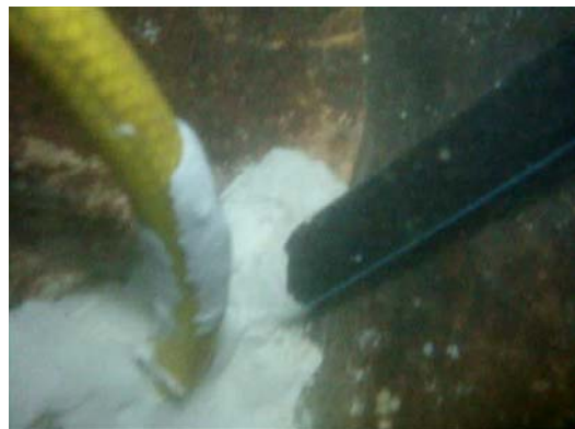
Fotografia 70 – Ponte do Pinhão – Injecção de argamassa
