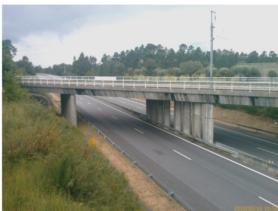
Fotografia 58 – Viaduto sobre o IC12
