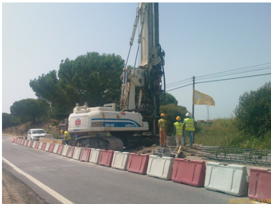
Fotografia 76 – PH Alcácer – Execução de estacas
