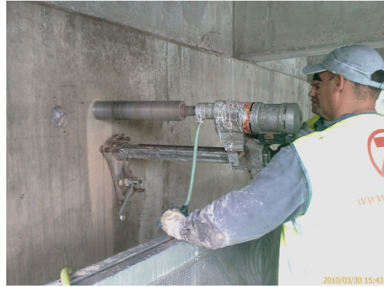
Fotografia 44 – Inspecções Agueira Abertura de carotes
