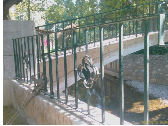
Fotografia 73 – Pontão pedonal – guarda corpos
