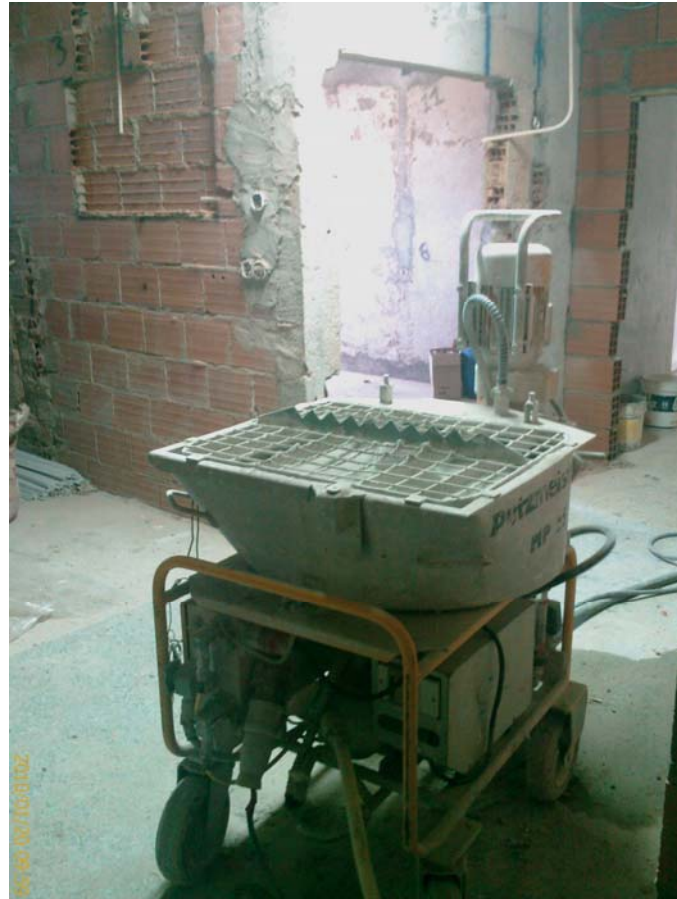
Fotografia 18 - Centro de Saúde de Mora Máquina de projectar argamassa
