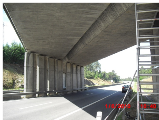
Fotografia 59 – Viaduto sobre o IC12
