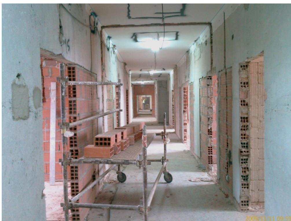
Fotografia 15 - Centro de Saúde de Mora – Piso 1 (Edifício existente)
