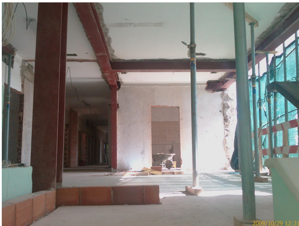
Fotografia 14 - Centro de Saúde de Mora – Reforço Piso 1
