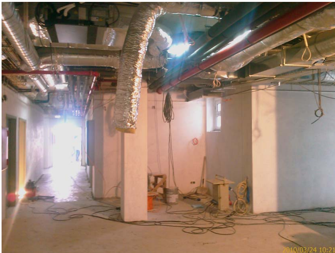
Fotografia 23 - Centro de Saúde de Mora – Infra-estruturas sobre o tecto falso
