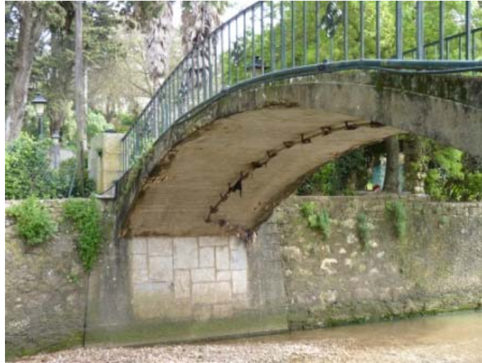
Fotografia 71 – Pontão pedonal - existente
