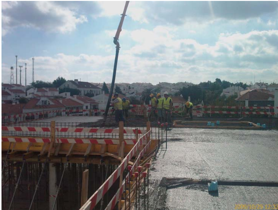
Fotografia 13 - Centro de Saúde de Mora – Betonagem da laje do Piso 1
