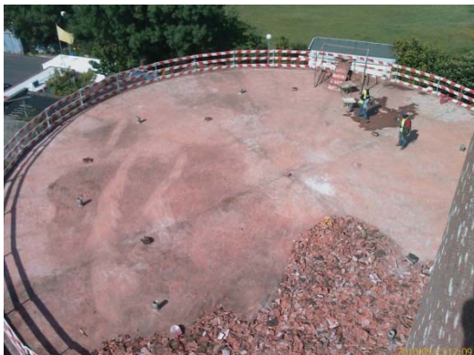
Fotografia 62 – Brandoa Média - Depósito
