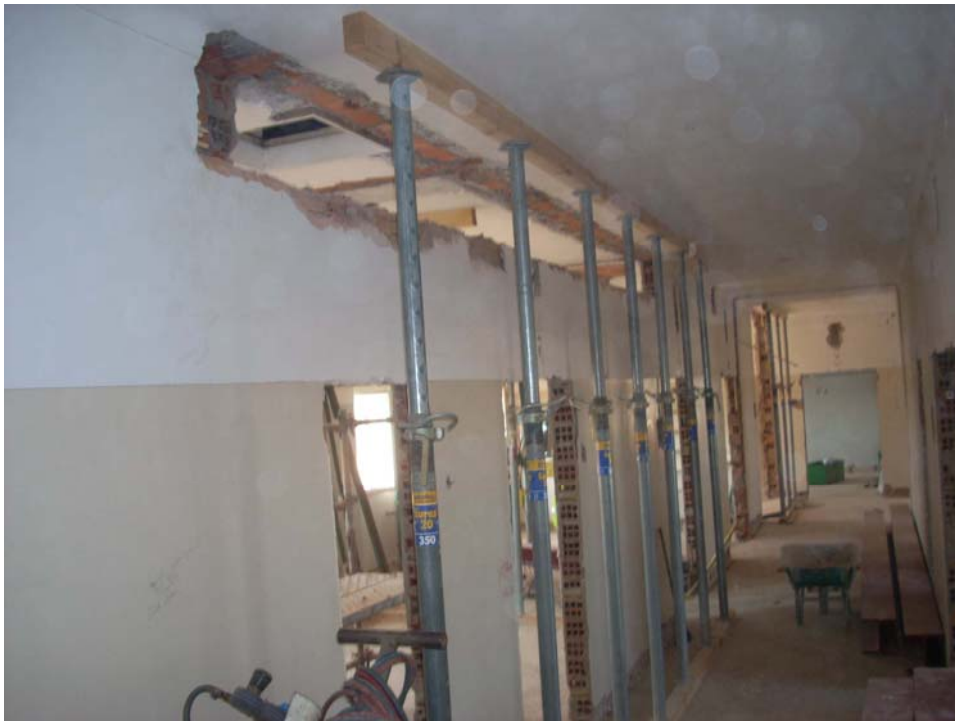
Fotografia 8 - Centro de Saúde de Mora – Escoramento da laje de esteira
