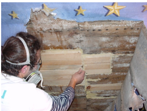
Fotografia 51 – Igreja de Barcarena Colocação de madeira nova em lacunas
