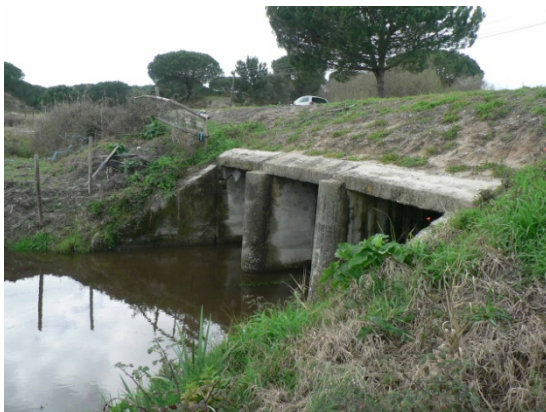
Fotografia 74 – Passagem Hidráulica Vista de montante
