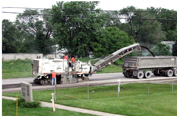
Figura 4.20 – Fresagem a frio e transporte do material fresado (ARRA, 2009)
