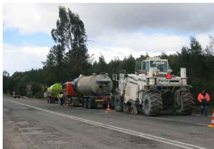
Figura 4.10 – “Comboio” composto pela máquina recicladora, cisternas para água e emulsão betuminosa (Batista & Antunes, 2009)
