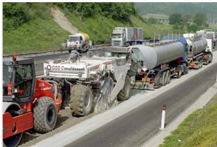
Figura 4.3 – “Comboio” de reciclagem (Wirtgen, 2009)
