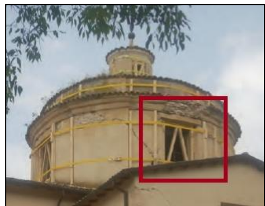
Figura 5.27- Escoramento de suporte e contenção lateral em aberturas. (Goriano Sicoli, 2009). (Grupo di Lavoro, N.C.P. S. Grmaz coord., 2010)
