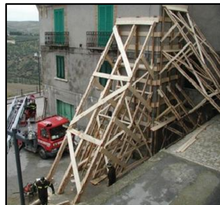
Figura 5.4- Aplicação de escoramentos de retenção (Molise 2002). Fonte: Centro Documentazione Comando VVF Alessandria .
