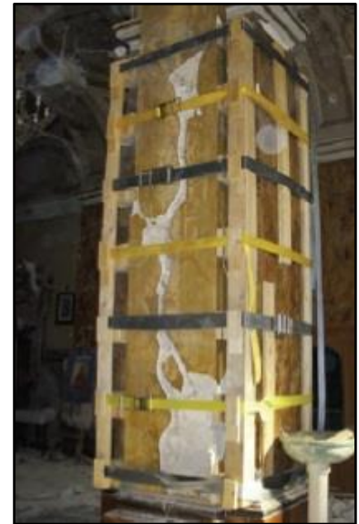
Figura 5.60- Caso de aplicação de cintagem em pilar com cintas de poliéster.
