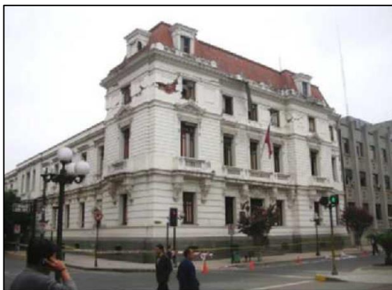
Figura 2.11- Edifícios de alvenaria não reforçada, edifício da Administração de Talca (Astroza, Ruiz, & Astroza, 2012).
