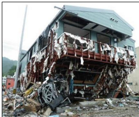
Figura 2.8- Danos em edifício com estrutura metálica, Kamaishi 2011 (Fraser, et al., 2012).
