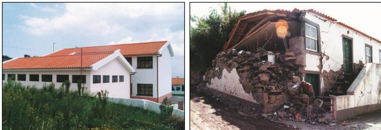
Figura 2.6- Comparação entre a construção recente e construção antiga, Sismo do Faial, 1998 (Lopes M. , 2004).
