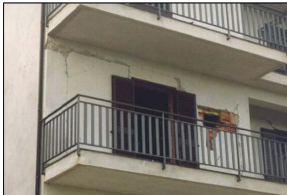
Figura 4.42- Grau de dano do enchimento: generalizado D2, localizado D4. (Castelluccio Inferiore, PZ, 1998).
