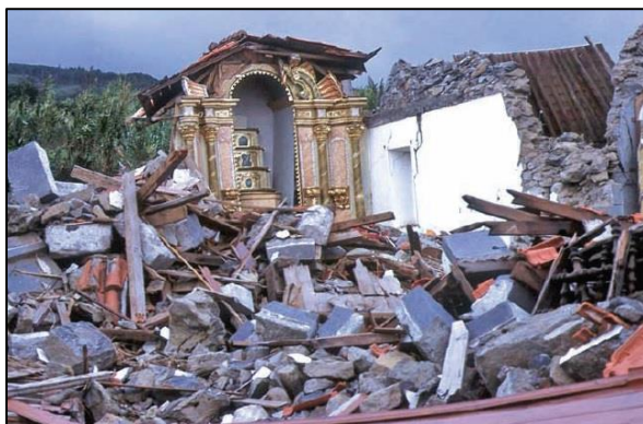
Figura 2.4- Destruição total da igreja do Salão durante o sismo de 1998 (Madeira & Silveira, 2007).
