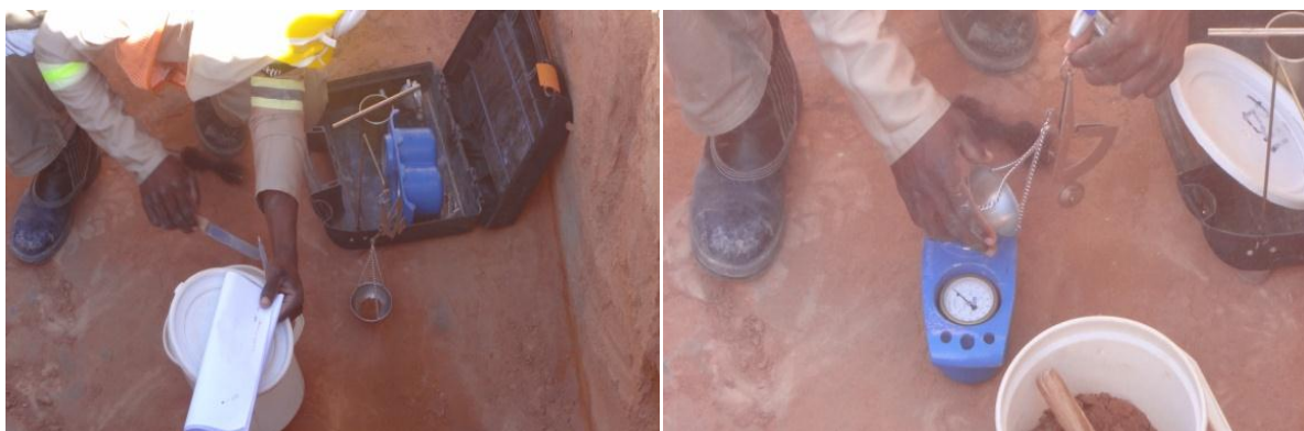
Figura 4.5: Recolha de mostra de solo e colocação no medidor Speedy .
