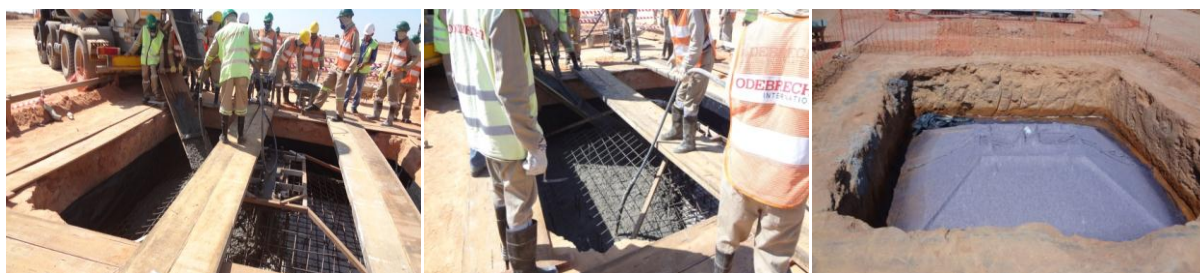
Figura 4.10: Betonagem de sapata de fundação.
