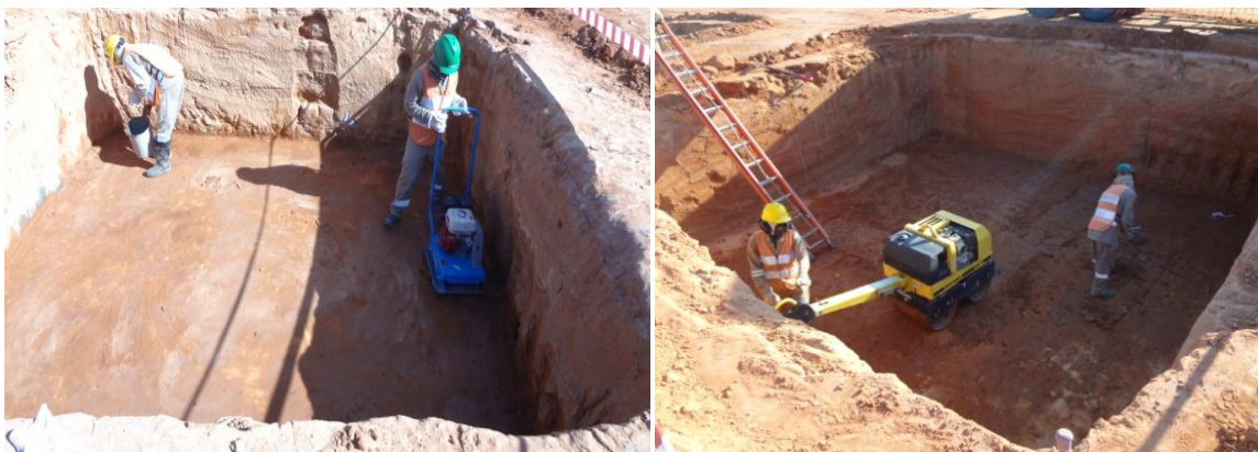
Figura 4.2: Regularização do fundo de escavação com placa e cilindro vibratórios.
