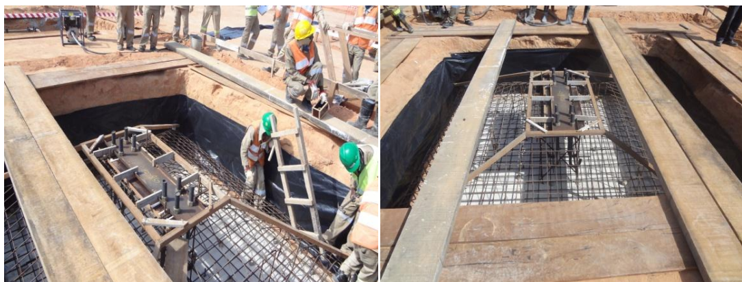
Figura 4.9: Montagem de guias de betão e de passadiços provisórios de madeira.
