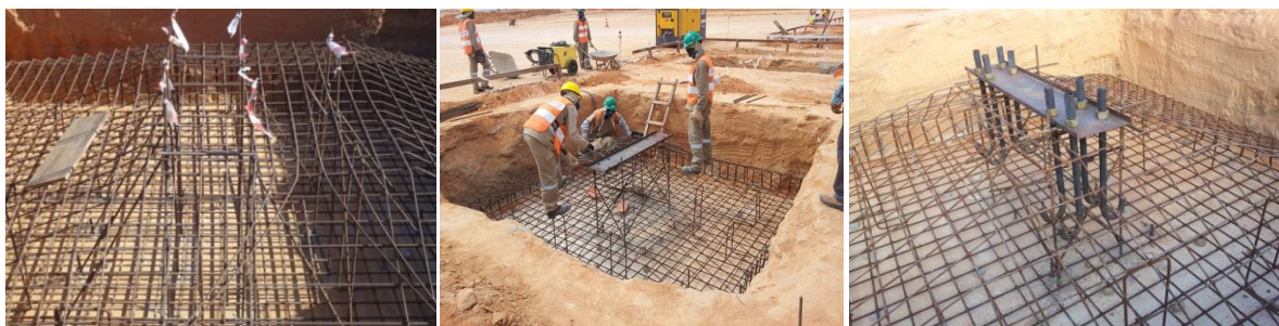
Figura 4.8: Montagem do sistema de fixação do pilar metálico.
