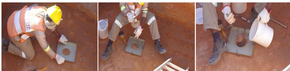
Figura 4.3: Abertura de cavidade de dimensões normalizadas para ensaio de garrafa de areia.
