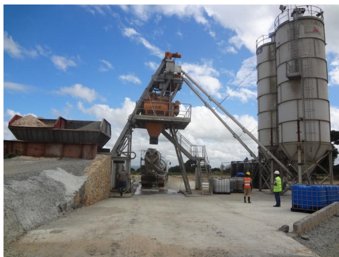
Figura 4.11: Abastecimento de camião betoneira na central de betão contratada.
