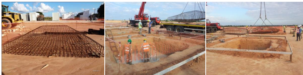
Figura 4.7: Montagem de gaiola de armadura e colocação sobre camada de regularização.
