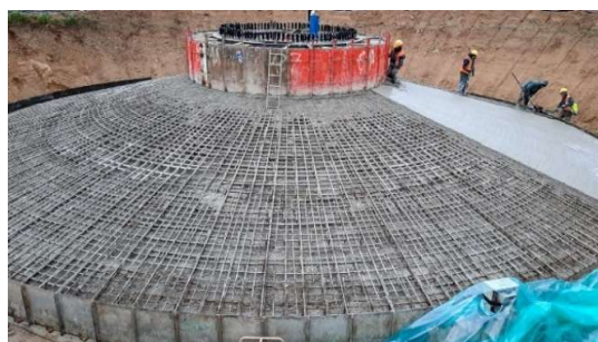
Figura 3.4 - Construção da Fundação de uma Turbina Eólica [19].
