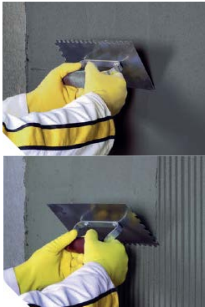
Figura 2.24 Espalhamento do adesivo no suporte com o lado liso e denteado da talocha [78].
