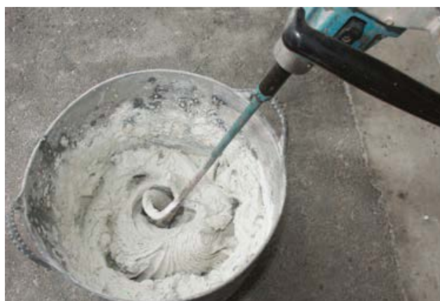
Figura 2.22 Mistura mecânica do material de assentamento [78].
