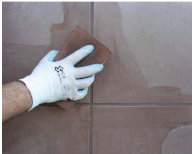
Figura 2.28 Limpeza dos ladrilhos com esponja [78].
