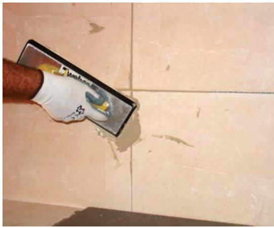
Figura 2.27 Preenchimento das juntas com espátula de borracha [78].
