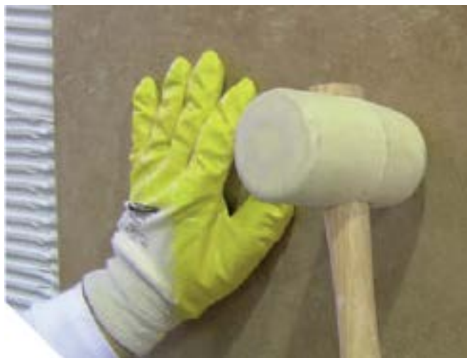
Figura 2.25 Utilização de um maço de borracha para garantir o abatimento dos cordões de cimento-cola [78].
