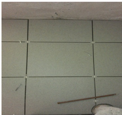
Figura 2.26 Exemplo de cruzetas de PVC aplicadas em pavimento.
