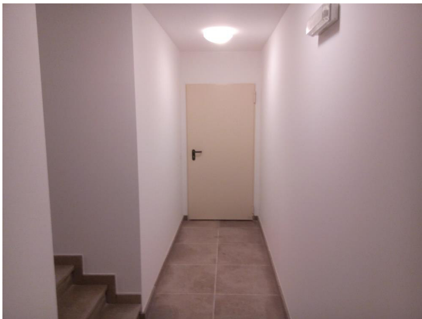
Figura 35 – Conclusão de Trabalhos de Reparação de Cave.
