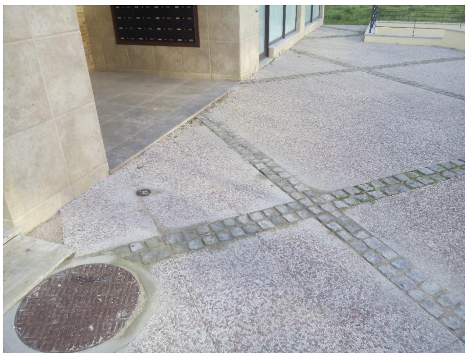
Figura 41 – Fecho de Vala de Zona de Intersecção.
