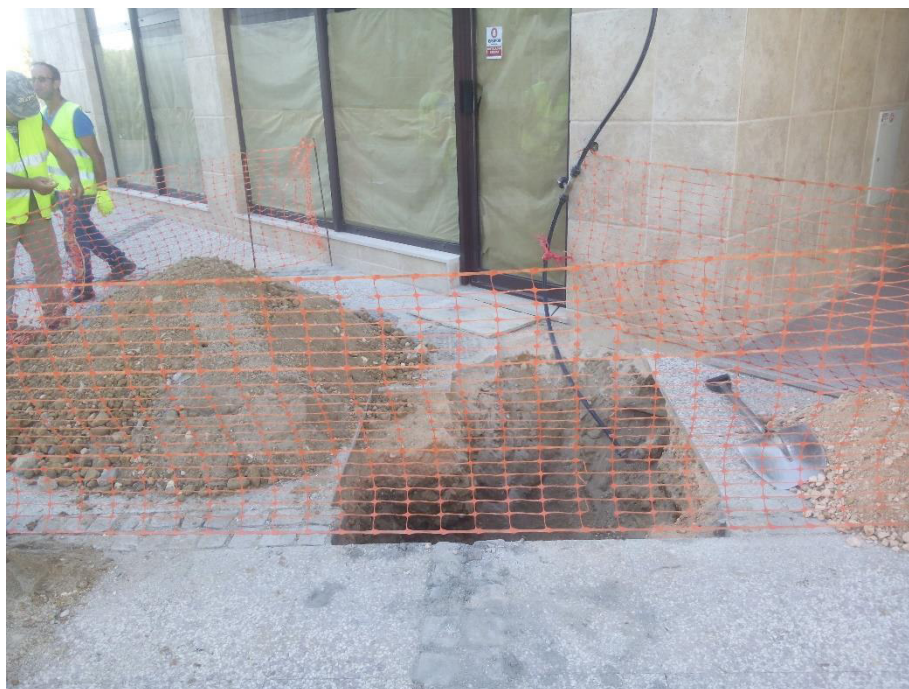
Figura 39 – A) Abertura de Vala em Zona de Intersecção.
