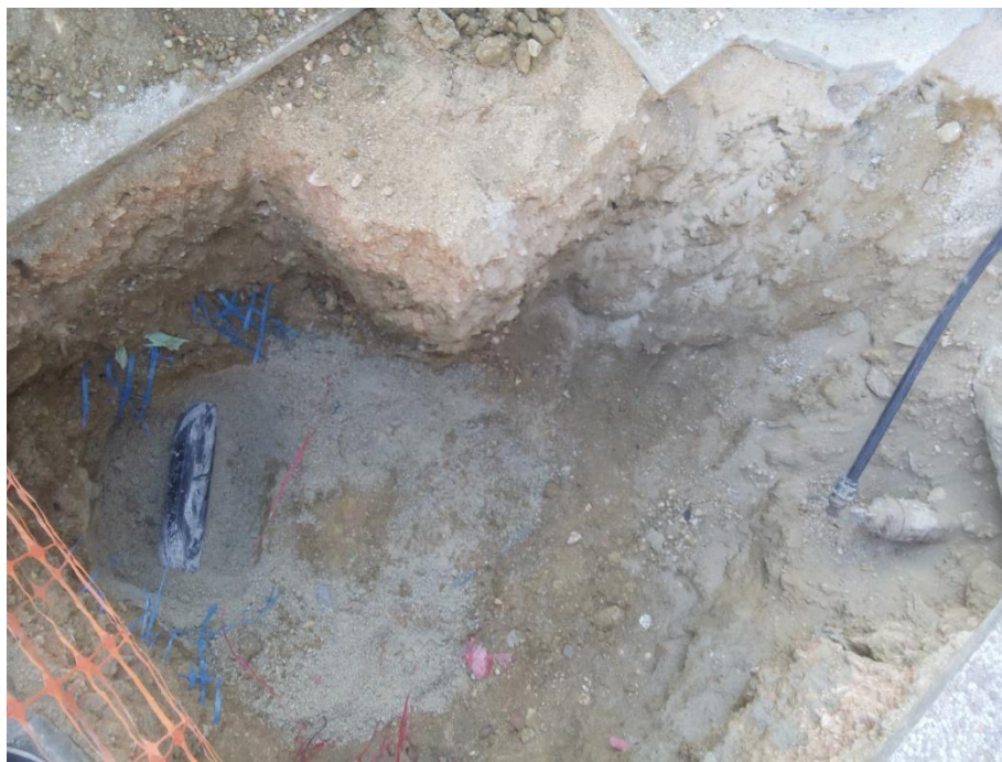
Figura 40 - B) Abertura de Vala em Zona de Intersecção.
