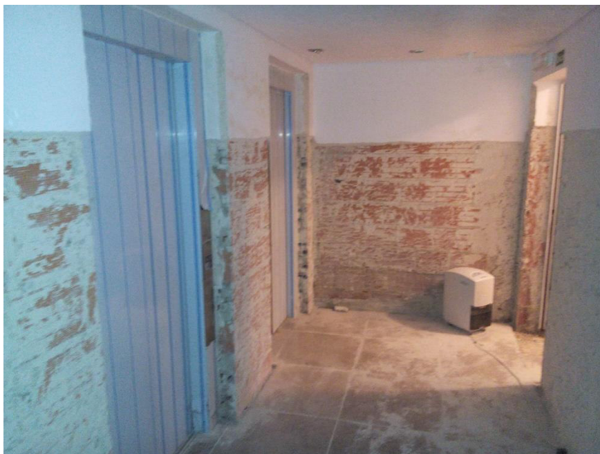
Figura 34 - C) Trabalhos de Reparação de Cave.
