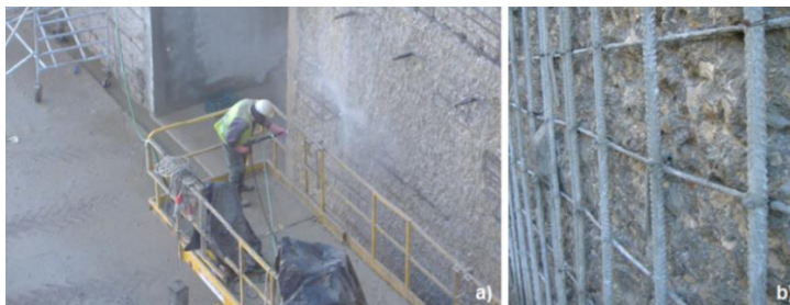
Figura 6.13 - Preparação do substrato – jato de água para decapagem e limpeza das armaduras a), Aspetto da superfície após tratamento b) (adaptado de Correia, 2011).
