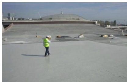
Figura 6.3 - Pintura com tinta de poliuretano na pala do Pavilhão de Portugal em Lisboa (adaptado de Correia, 2011).
