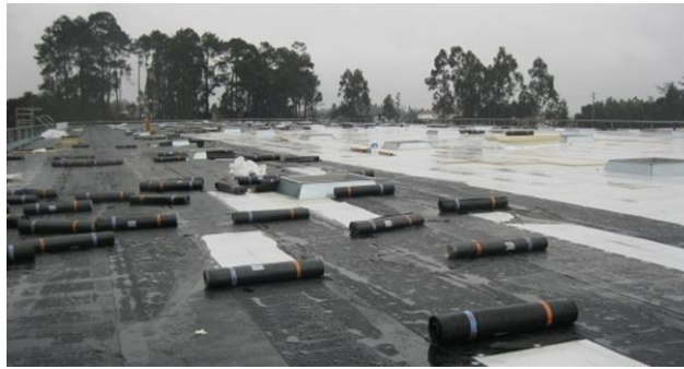
Figura 6.4 - Aplicação de telas betuminosas para proteção do betão (adaptado de Correia, 2011).
