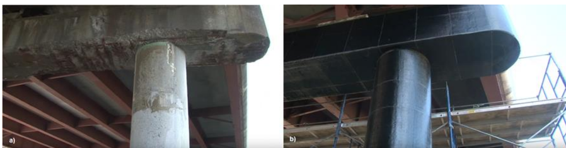
Figura 6.19 - Utilização de mantas de FRP no reforço estrutural de um viaduto. a) antes da intervenção, b) depois da intervenção (adaptado de Correia, 2011).
