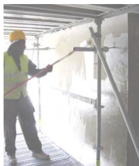
Figura 6.2 - Impregnação com silanos no viaduto Duarte Pacheco em Lisboa (adaptado de Correia, 2011).
