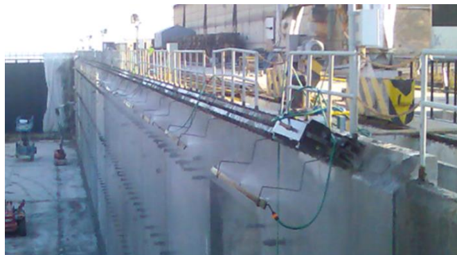
Figura 6.15 - Cura das superfícies reparadas através de um sistema automático de rega (adaptado de Correia, 2011).
