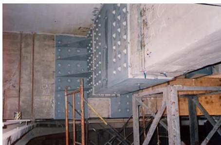
Figura 6.20 - Reforço estrutural com perfis metálicos (adaptado de Correia, 2011).
