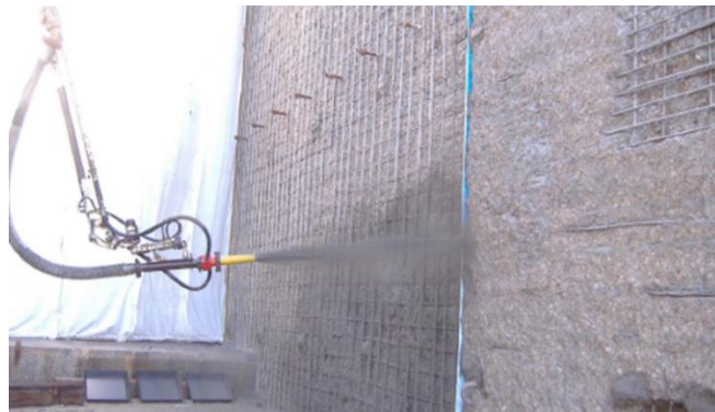
Figura 6.14 - Aplicação do betão projetado (adaptado de Correia, 2011).
