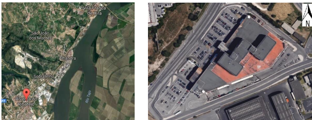
Figura 8.1 - Localização do edifício em estudo [Fonte: Google Maps].
