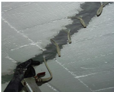
Figura 6.10 - Reparação de fendas por injeção de resina de epóxico (adaptado de Correia, 2011).
