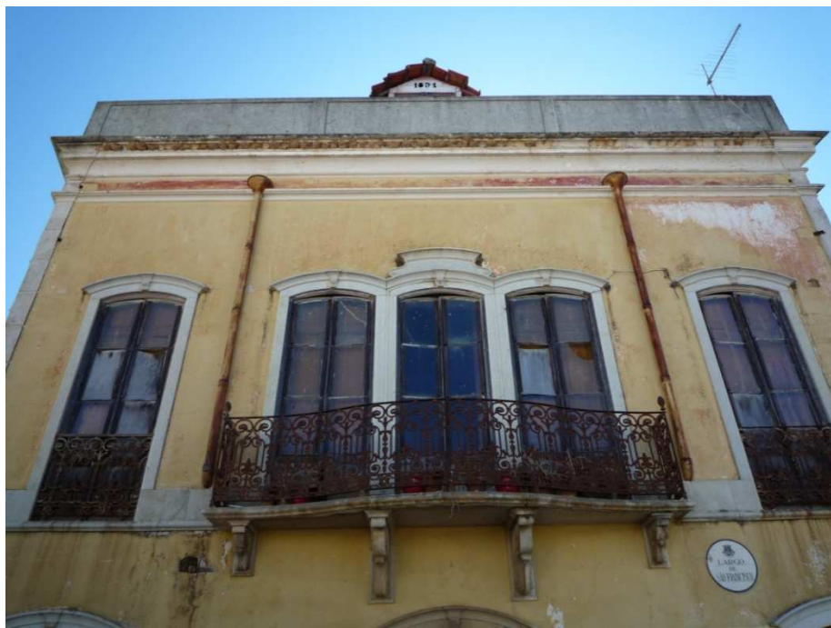
Figura 7 - Vista do 1º piso lado oeste
