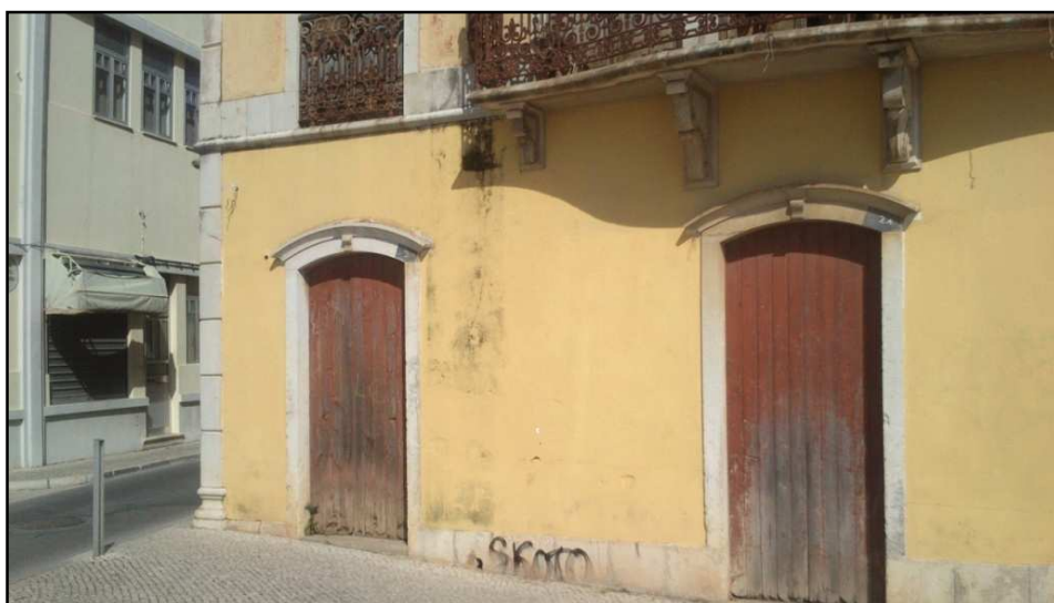
Figura 10 - Rés-do-chão da fachada oeste
