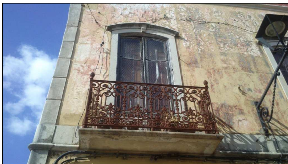
Figura 6 - Janela do 1º piso lado sul
