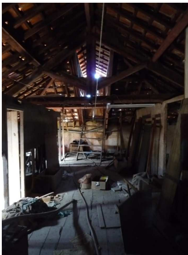
Figura 24- Vista geral do sótão
