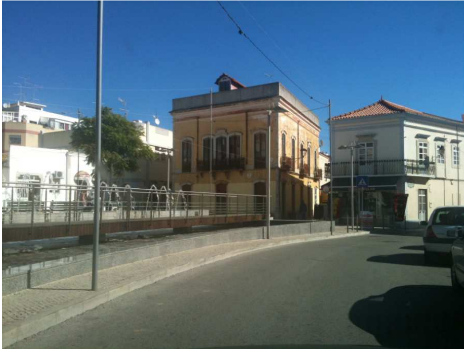
Figura 1 - Enquadramento geral do edifício na sua envolvente
