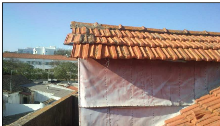
Figura 32- Zona de acesso à cobertura
