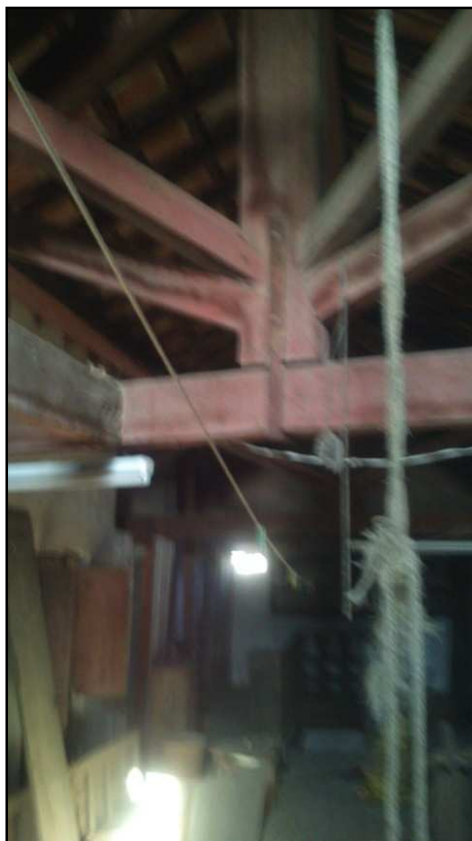
Figura 25- Estrutura de madeira da cobertura
