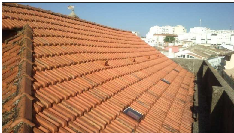
Figura 31- Bom estado de conservação das telhas
