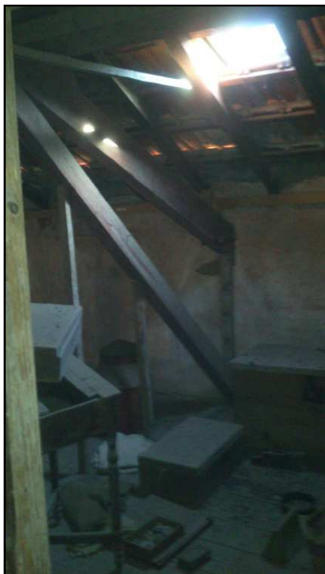
Figura 27- Apoios na parede existente
