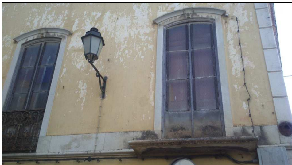
Figura 9 - 1º piso da fachada norte
