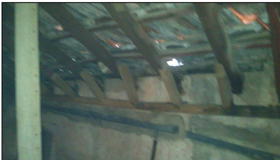
Figura 26- Apoio das asnas na parede
