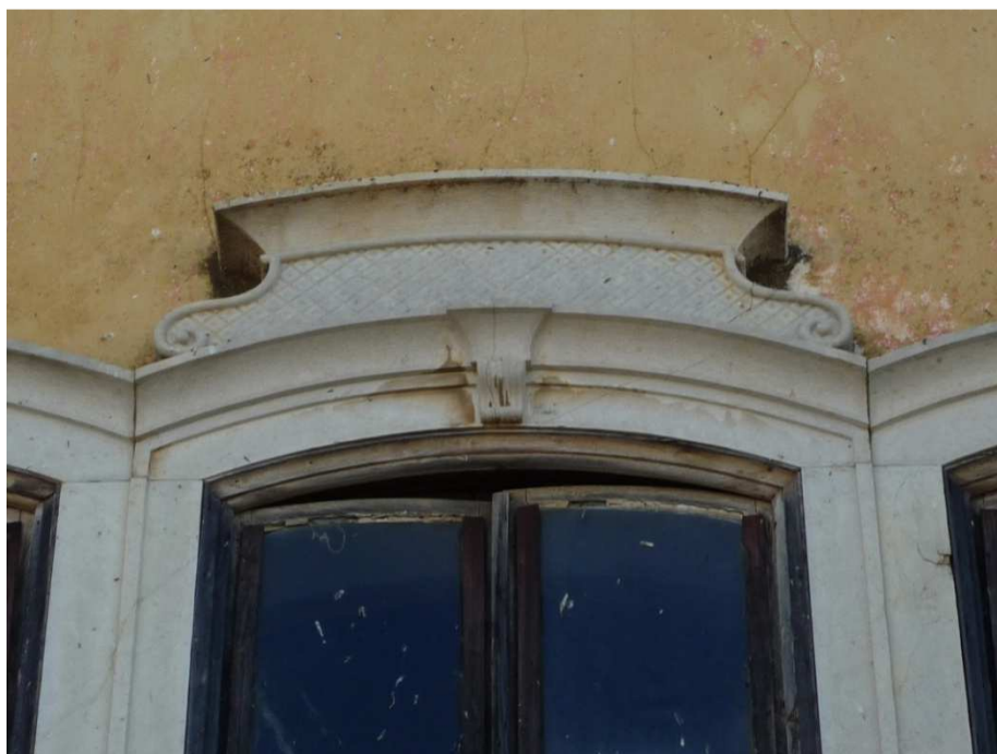
Figura 8 - Detalhe da cantaria e caixilharia de um vão de janela
