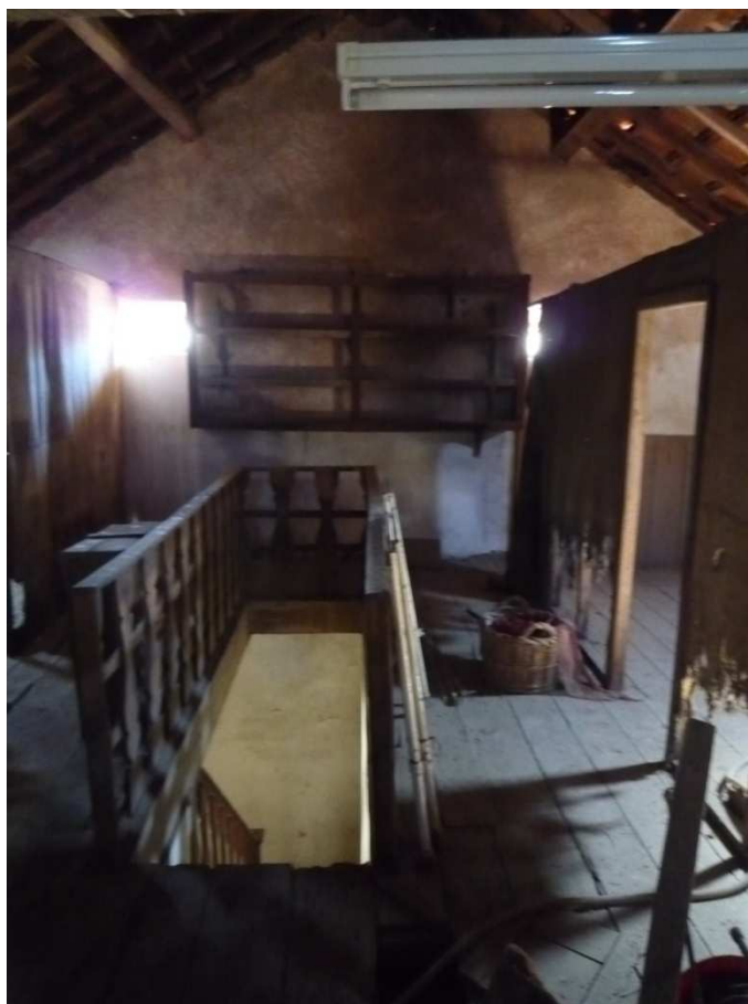
Figura 29- Escada de acesso ao sótão
