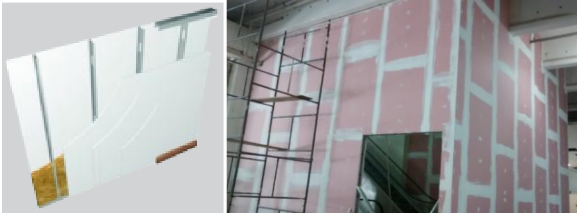
Figura 2.45 – Divisórias resistente ao fogo[64]
