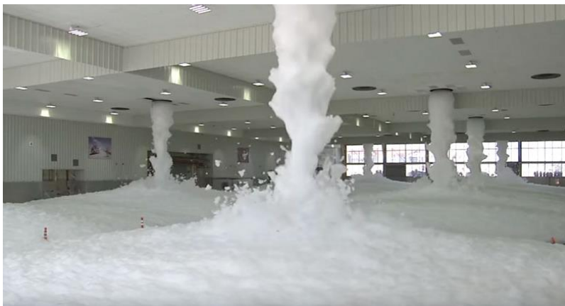
Figura 2.29 – Extinção por sistema de espuma [51]
