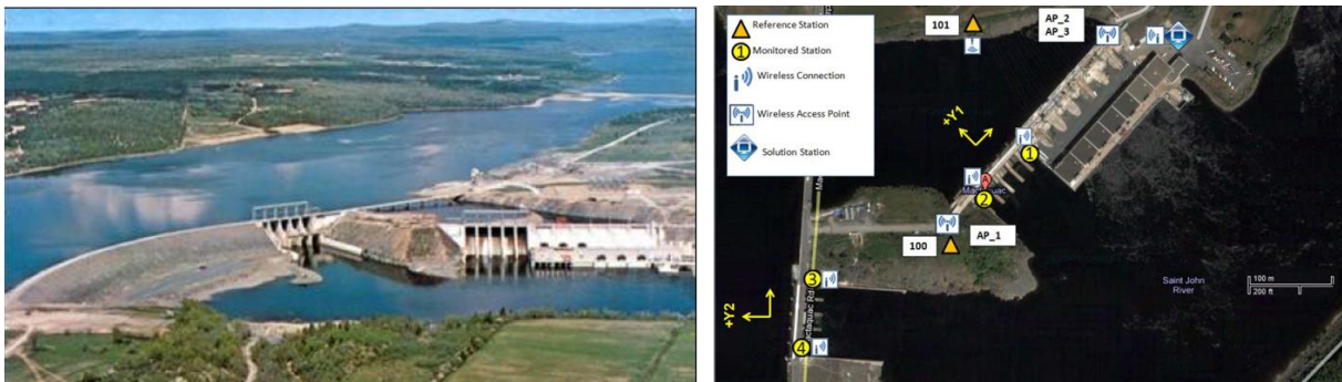
Figura 2.15 - Barragem de Mactaquac, Canada.
