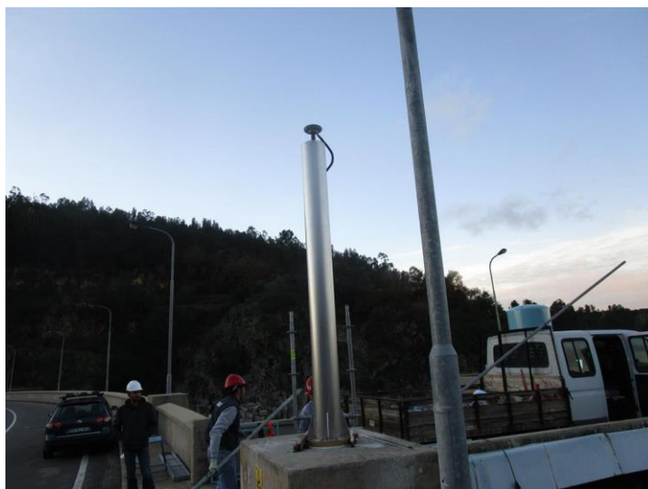
Figura 2.6 - Pilar para antena GNSS no coroamento, fixado no topo do muro que veda a passagem para a torre de tomada de água.
