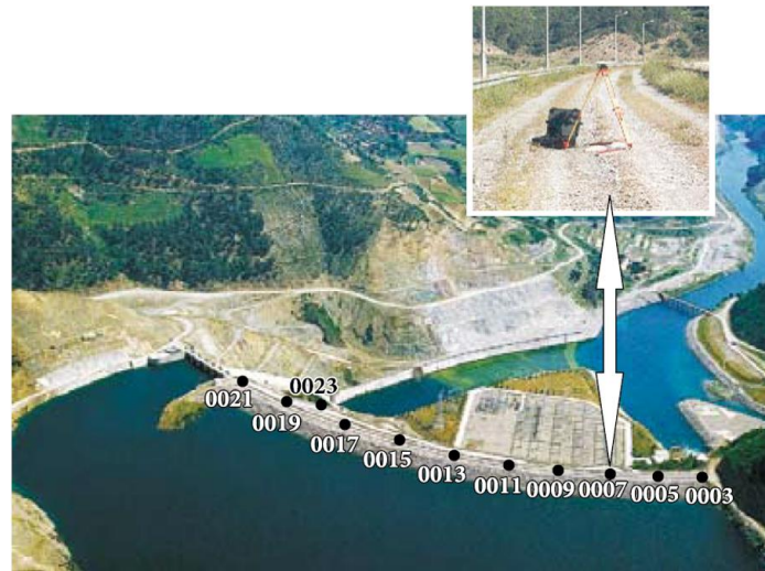
Figura 2.16 - Barragem de Altynkaya, Turquia.
