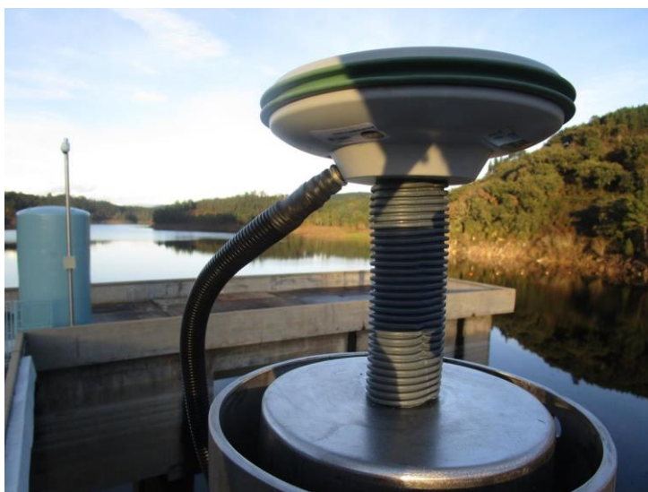
Figura 2.7 - Pormenor do topo do pilar para a antena GNSS do coroamento: os dois cilindros concêntricos.
