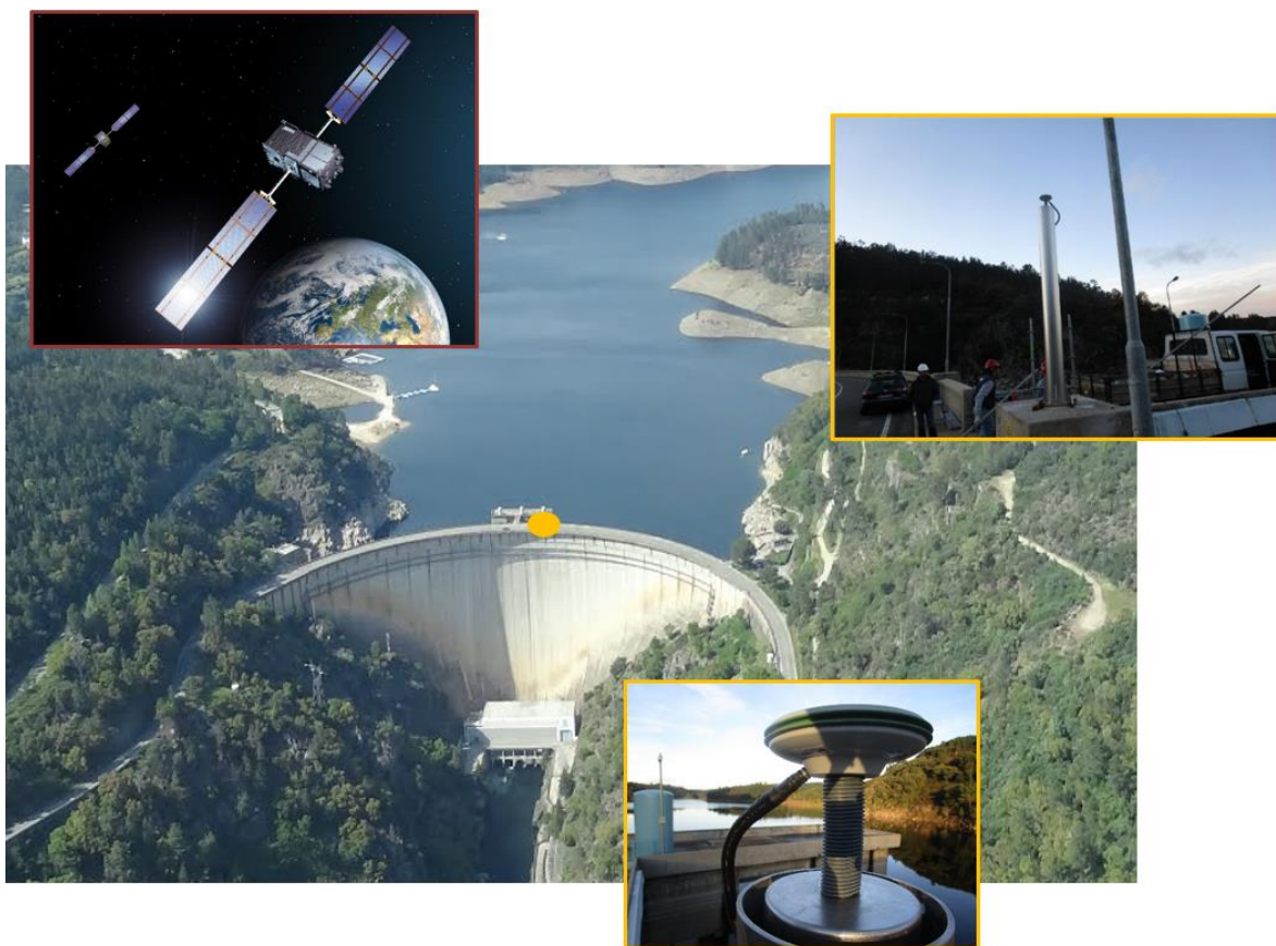
Figura 1.1 - Antena GNSS no ponto objeto da barragem do Cabril, situado no topo da consola central.
