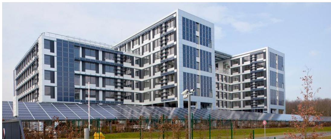
Figura 6 – Edifício Green Office Meudon
