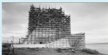
Figura 1 – Início da construção do Padrão dos Descobrimentos em madeira (1940). Consultado em: Biblioteca de arte
