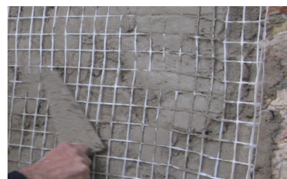
Colocação da rede na camada ainda fresca
