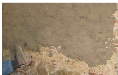
Aplicação manual da argamassa
