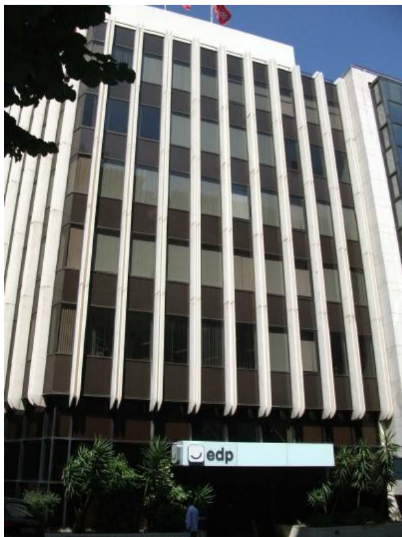
Figura 15 – Fachada principal do edifício de serviços EDP.
