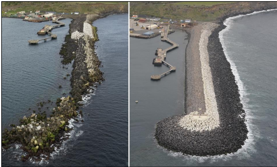
Figura 6 - Quebra-mar Norte após a tempestade à esquerda e após as reparações à direita. (Baird, 2010)
