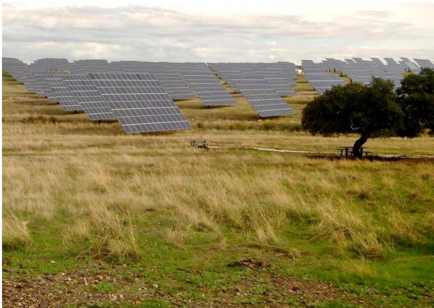
Figura 2.10 - Parque de merendas dentro da Central Solar Fotovoltaica da Amareleja
