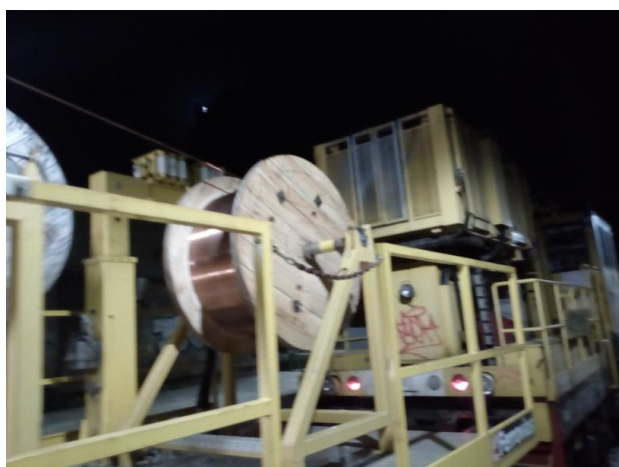
Figura 5-34 Desbobinagem do cabo de feeder
