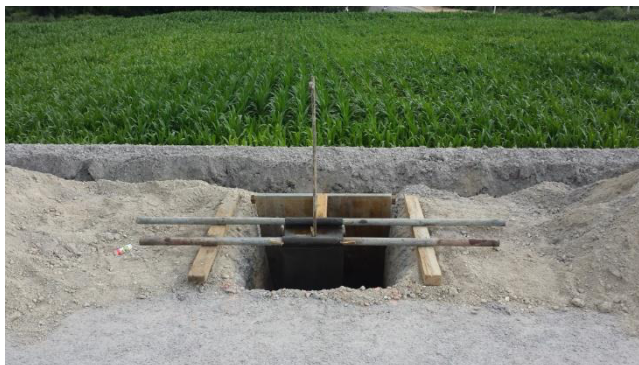
Figura 5-29 Fundação do maciço de catenária
