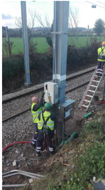
Figura 5-33 Montagem e ligação de aparelhagem elétrica
