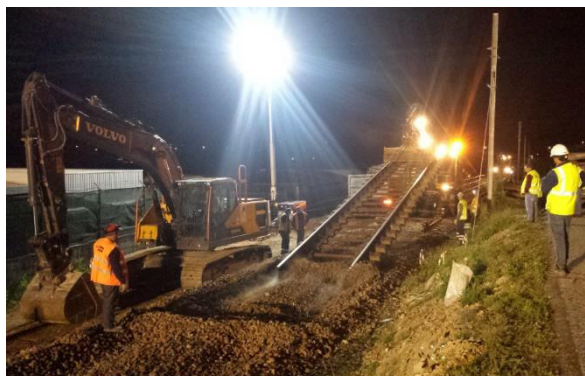
Figura 5-4 Levantamento de tramo de via
