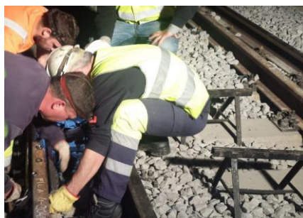
Figura 5-22 Execução de junta isolante
