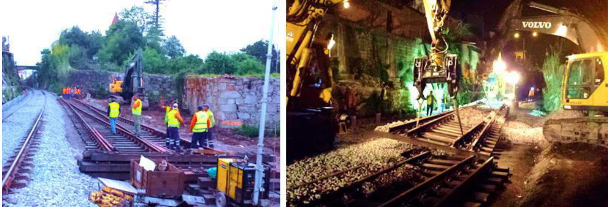
Figura 5-14 Pré-montagem de AMV e respetivo assentamento
