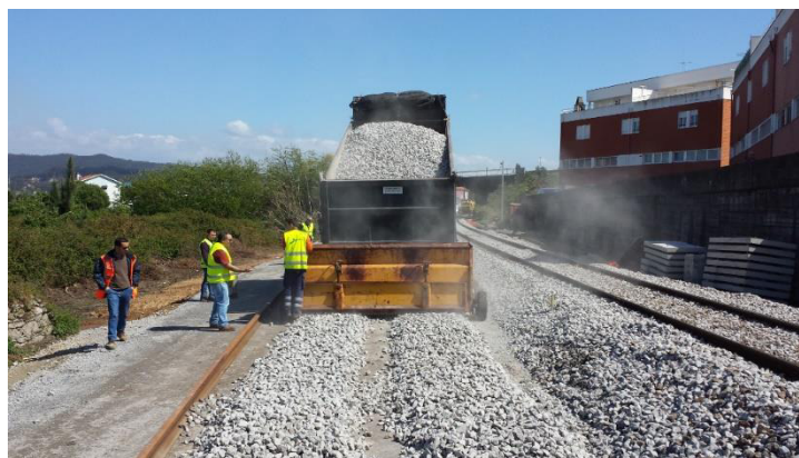
Figura 5-7 Execução de lâmina de balastro
