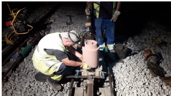
Figura 5-19 Colocação do cadinho sobre o molde refratário
