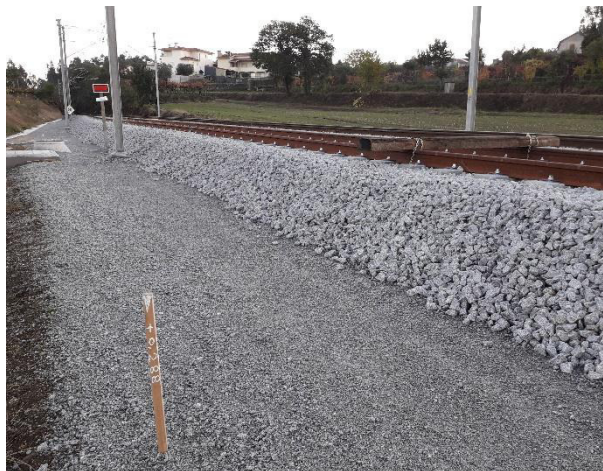
Figura 5-2 Piquetagem inicial para assentamento de via
