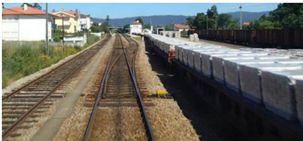
Figura 3-9 Estação técnica de Darque
