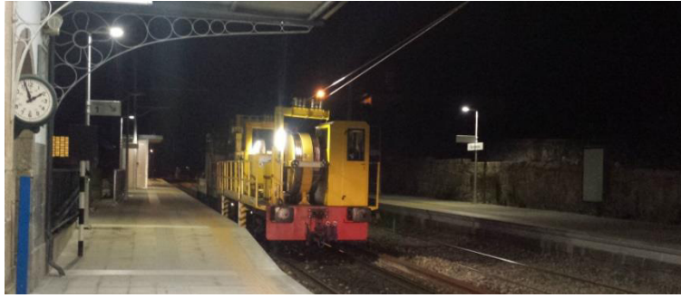
Figura 5-35 Lançamento de cabos condutores
