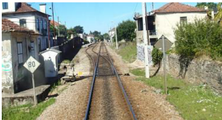
Figura 3-7 Estação técnica Barrocelas
