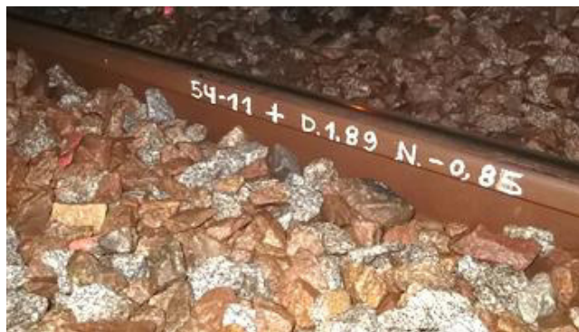
Figura 5-28 Piquetagem de implantação de poste de catenária
