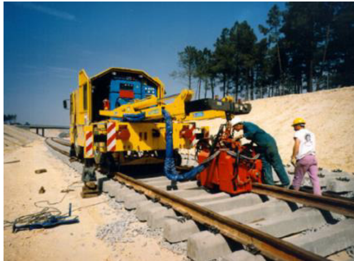
Figura 5-17 Execução de soldadura elétrica [18]
