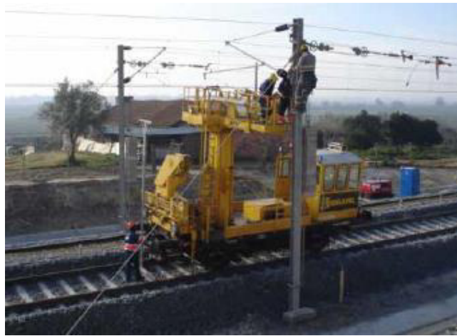
Figura 5-31 Tensionamento dos cabos ligados ao aparelho tensor [18]
