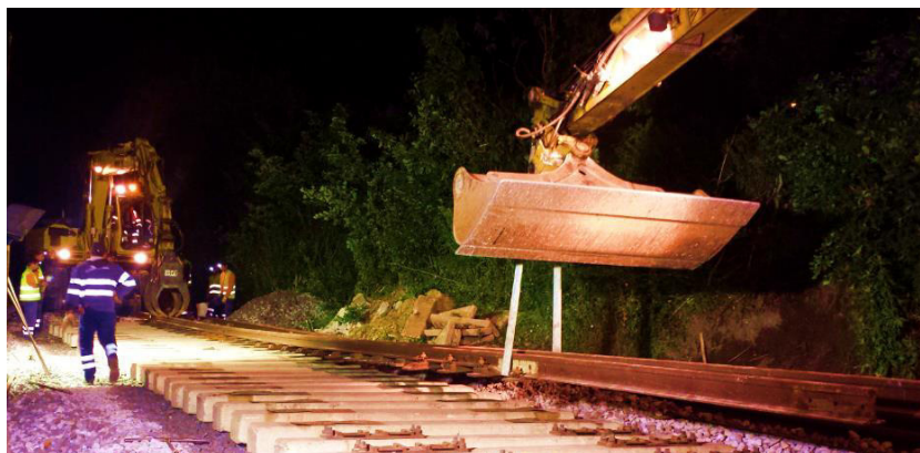
Figura 5-15 Assentamento de AMV travessa a travessa
