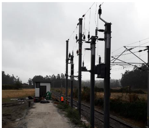
Figura 5-37 Montagem de isolador de secção na ZN
