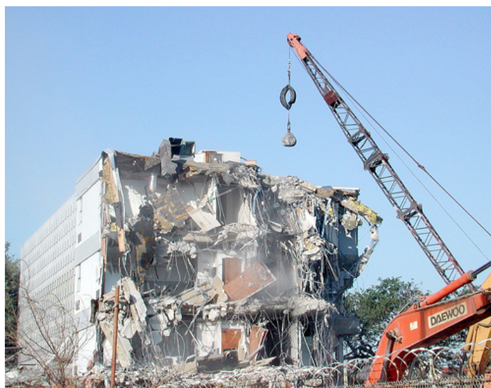
Figura 46 - Demolição com bola de ariete [site: zimbio, 2013]
