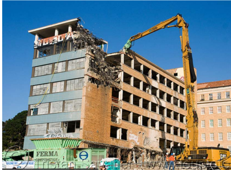
Figura 45 - Demolição com máquina hidráulica de braço longo [site: loupiote, 2013]
