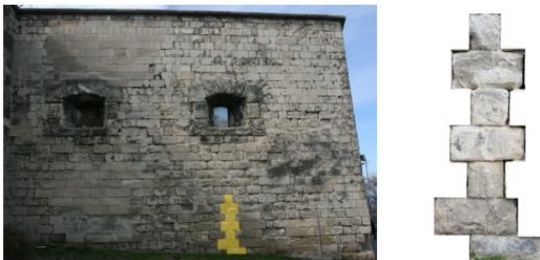
Figura 4.5 - Localização do Perfil vertical 2 na parede P1 e pormenor do mesmo.
