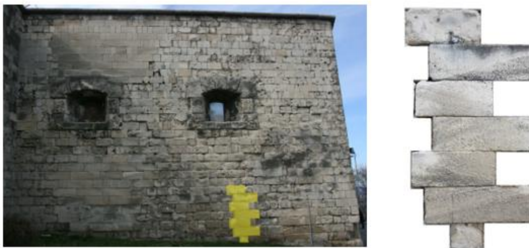
Figura 4.4 - Localização do Perfil vertical 1 na parede P1 e pormenor do mesmo.
