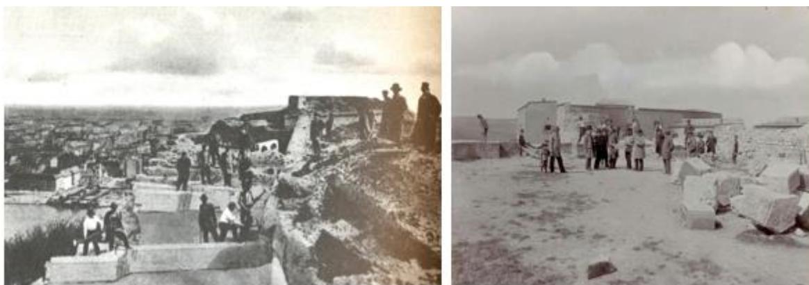
Figura 2.3 - Obras de demolição após a retirada total do exército Austríaco da fortaleza (1899), (MTVA Archivum, 2019).
