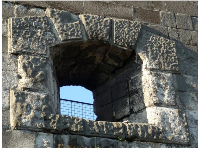
Figura 2.25 - Janela da Citadella, (Mezey, 2016).
