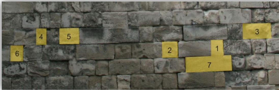
Figura 4.3 - Pormenor da localização das pedras testadas na parede P1 e respetiva numeração.
