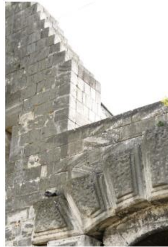
Figura 2.23 - Classificação da secção das paredes de alvenaria de pedra da Cidadella quanto ao número de panos, (GNDT, s.d.); (Mezey, 2016).
