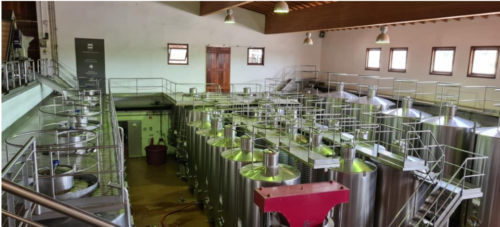
Figura 1 – Armazém da zona de fermentação utilizado como caso de estudo.
