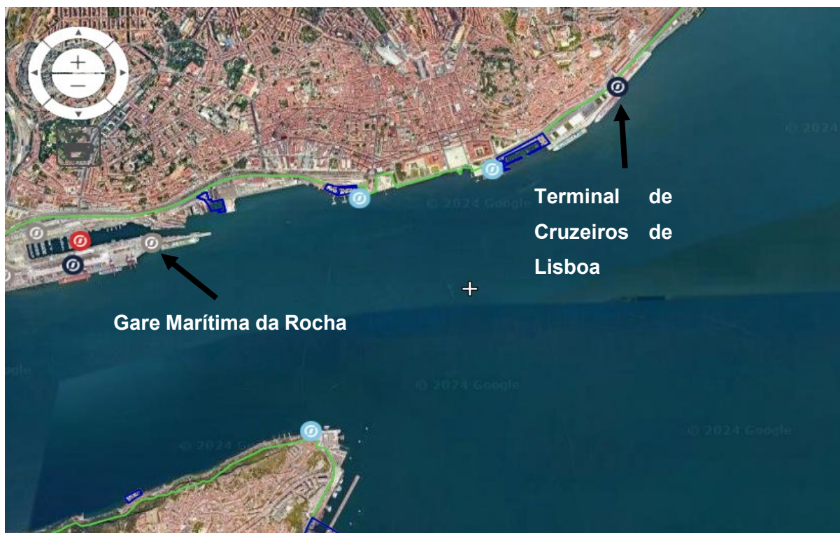
Figura 31 - Localização da Gare Marítima da Rocha e o Terminal de Cruzeiros de Lisboa (Adaptado de APL, 2024a).
