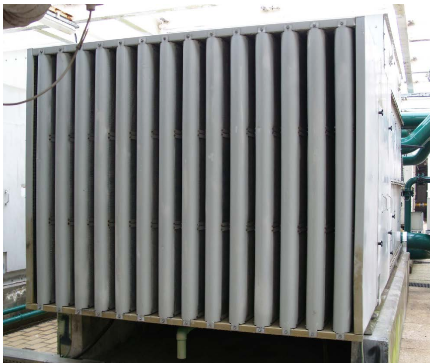
Figura 3.5 – Torre de arrefecimento (Baltimore® VTL-245P)
