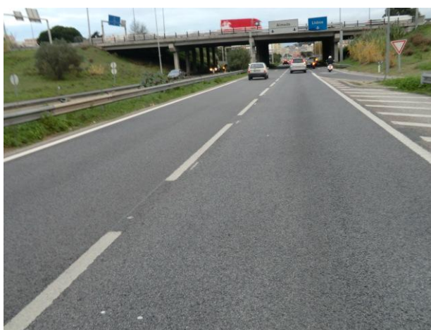
Figura 3.20 – Costa de Caparica - Almada (km 1+160)
