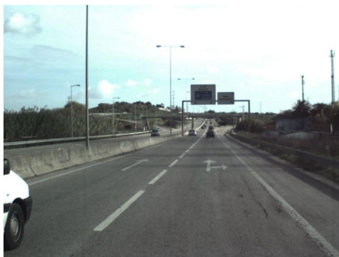
Figura 3.11 – Sentido Costa de Caparica – Almada (km 5+620)
