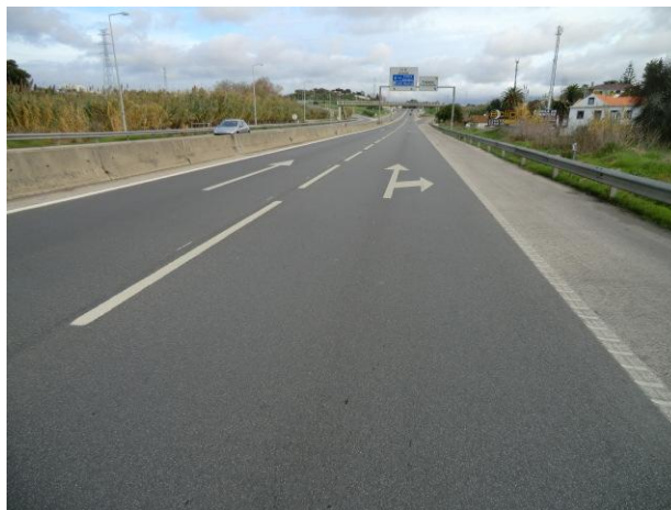
Figura 3.21 – Sentido Costa de Caparica – Almada (km 5+620)
