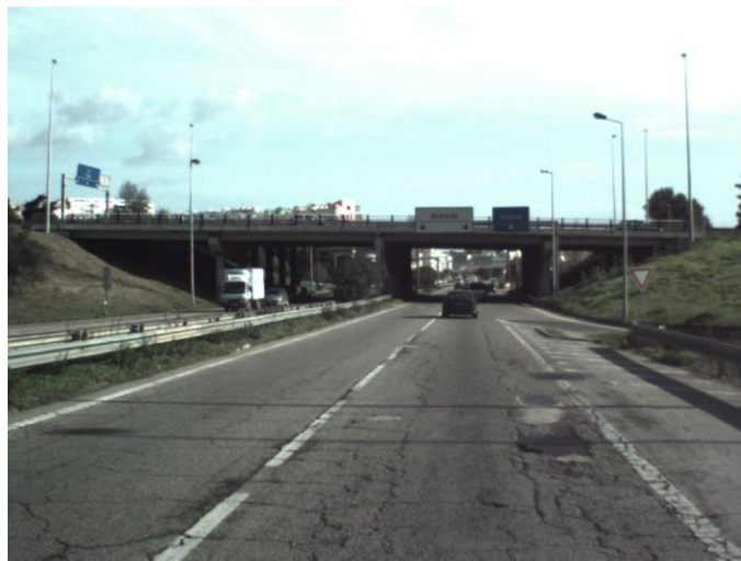
Figura 3.10 – Sentido Costa de Caparica – Almada (km 1+160)
