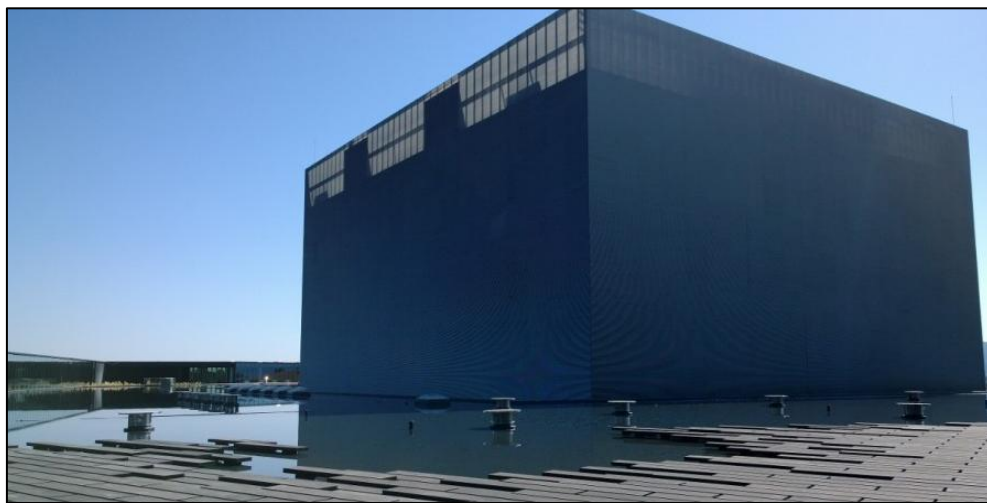
Figura 1.5 - Data Centre da Portugal Telecom [s31]
