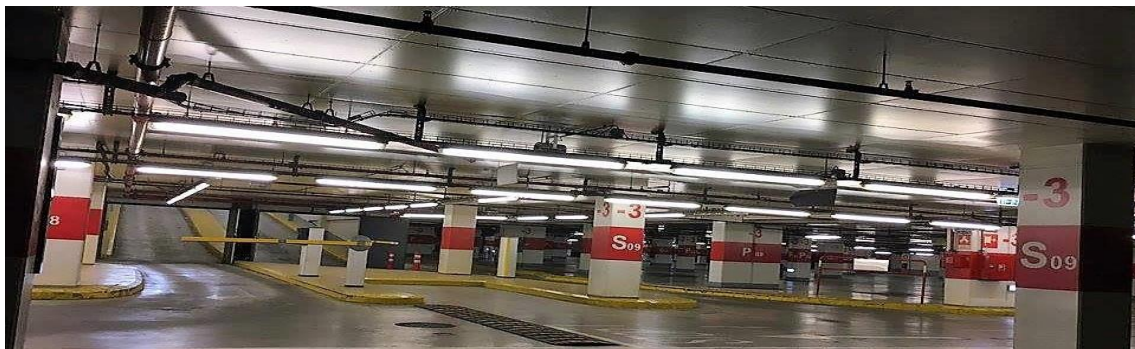
Figura 3.2 - Vista parcial da zona vermelha do parque de estacionamento
