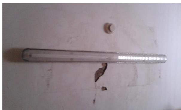
Figura 5.7 - Descasque de tinta no teto, devido a humidade por infiltrações derivadas do terraço - CS Paço De Arcos (Fonte: Autor)
