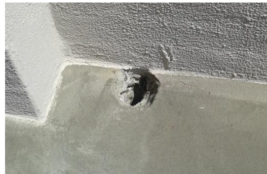
Figura 5.14 - Tubo de queda sem o respetivo ralo de pinha - UCSP St Condestável (Fonte: Autor)
