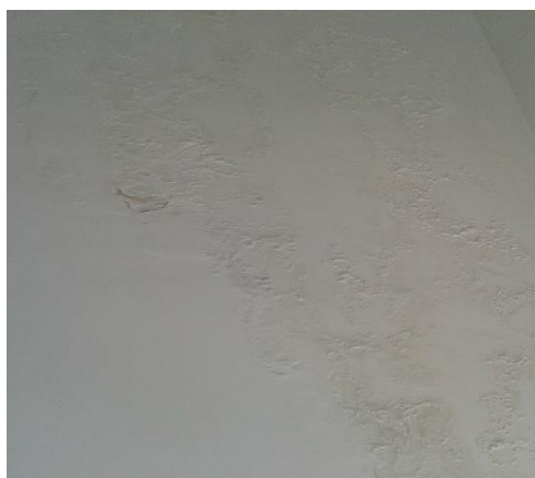
Figura 5.24 - Empolamento em parede interior junto a porta de acesso ao exterior - CS Paço de Arcos (Fonte: Autor)
