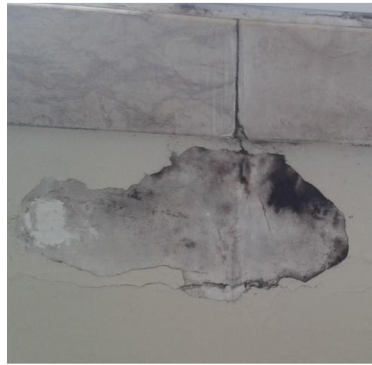
Figura 5.23 - Destacamento em parede interior junto a janela - UCSP St Condestável (Fonte: Autor)
