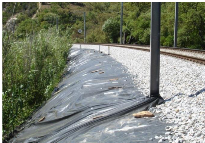
Figura 44 – Lona de plástico [figura cedida pelo departamento de Geotecnia da REFER Engineering]
