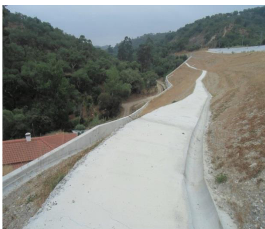
Figura 58 – Pormenor da drenagem longitudinal no aterro
