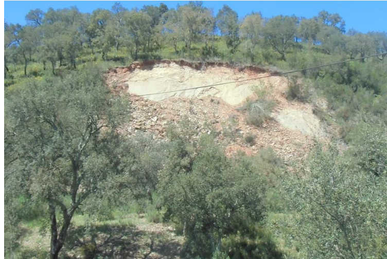
Figura 36 – Rotura em talude de aterro superior ao talude em estudo
