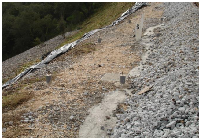
Figura 41 – Marcas de nivelamento [figura cedida pelo departamento de Geotecnia da REFER Engineering]
