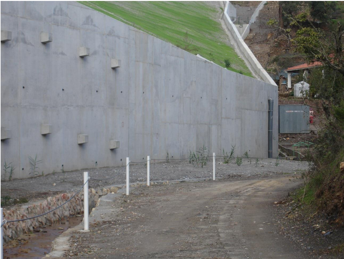
Figura 83 – Pormenor do muro de suporte ancorado e com contrafortes
