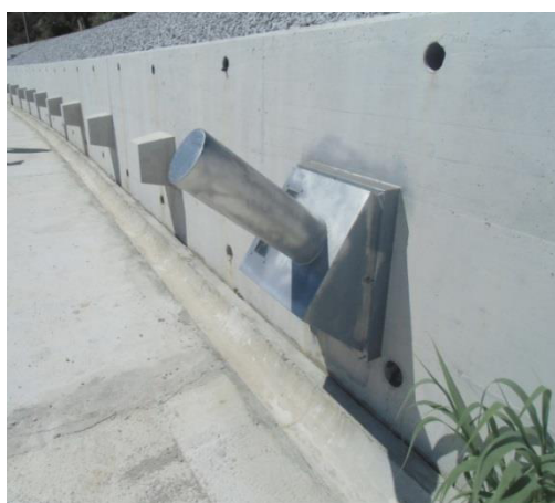
Figura 59 - Pormenor da drenagem longitudinal na base da parede de betão
