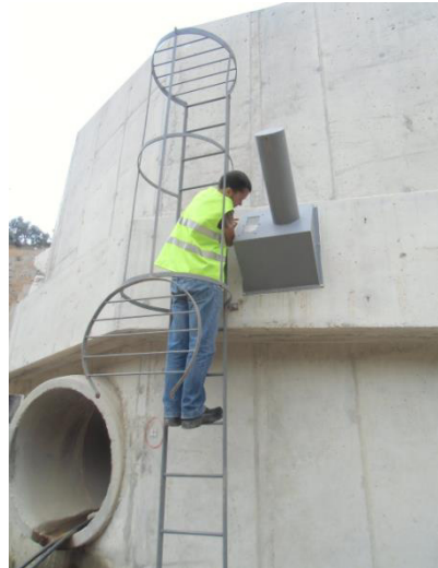
Figura 61 – Célula de carga no muro de suporte
