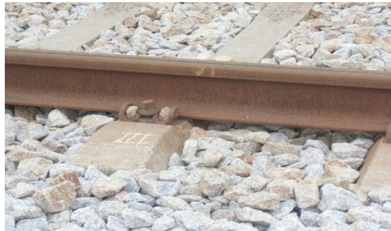
Figura 38 – Marcas topográficas marcadas no carril [figura cedida pelo departamento de Geotecnia da REFER Engineering]
