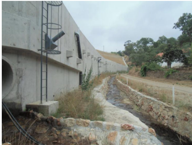
Figura 49 – Muro de suporte na base do talude de aterro
