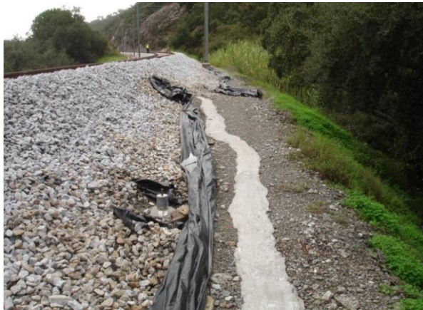
Figura 43 – Refechamento das fendas e colocação de uma lona de plástico [figura cedida pelo departamento de Geotecnia da REFER Engineering]
