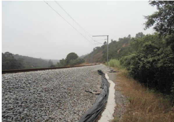
Figura 45 – Refechamento de fendas e colocação de uma lona de plástico [figura cedida pelo departamento de Geotecnia da REFER Engineering]
