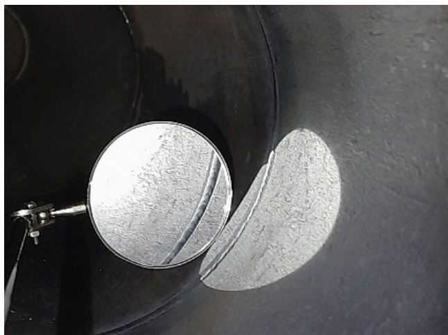
Figura 4.17 - Inspeção Visual indireta via espelho.
