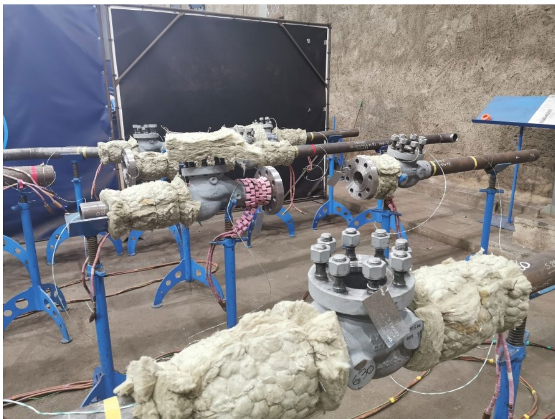
Figura 4.35 - Supervisão de Tratamentos Térmicos às soldaduras.
