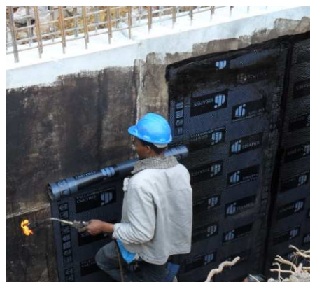
Figura 3.34 - Aplicação da membrana asfáltica
