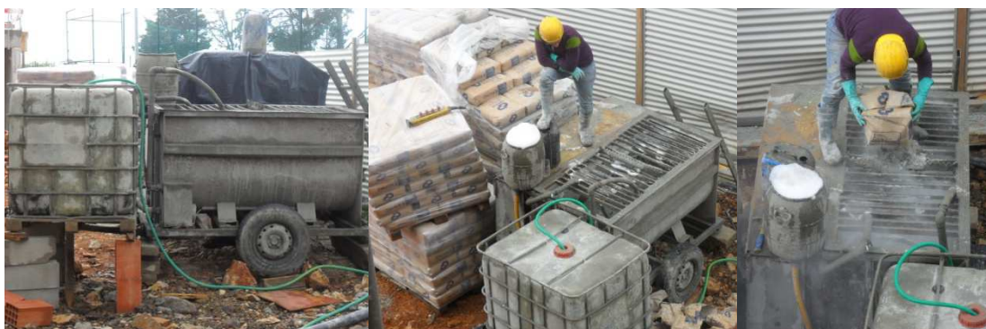
Figura 3.77 - Equipamento de mistura e bombagem do betão celular
