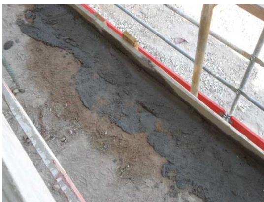
Figura 3.11 - Betonagem das zonas danificadas das vigas de bordadura com microbetão (vista superior)
