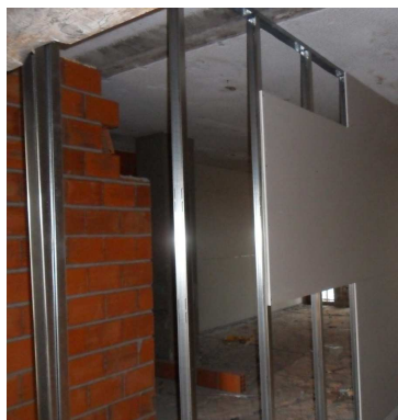
Figura 3.74 - Colocação dos montantes e das placas de gesso cartonado numa das faces da parede
