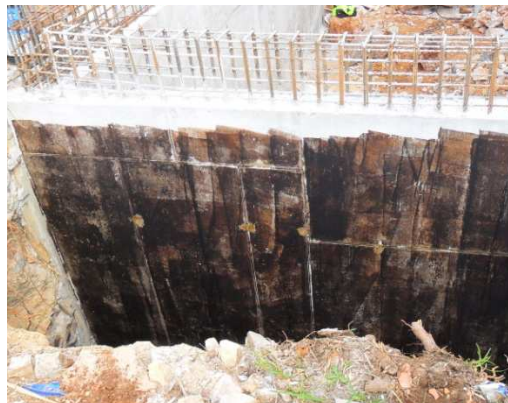
Figura 3.33 - Pintura dos muros de suporte com betume asfáltico
