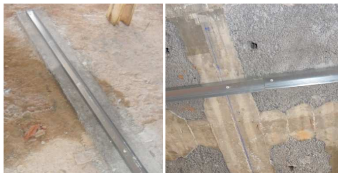
Figura 3.73 - Fixação dos perfis canal
