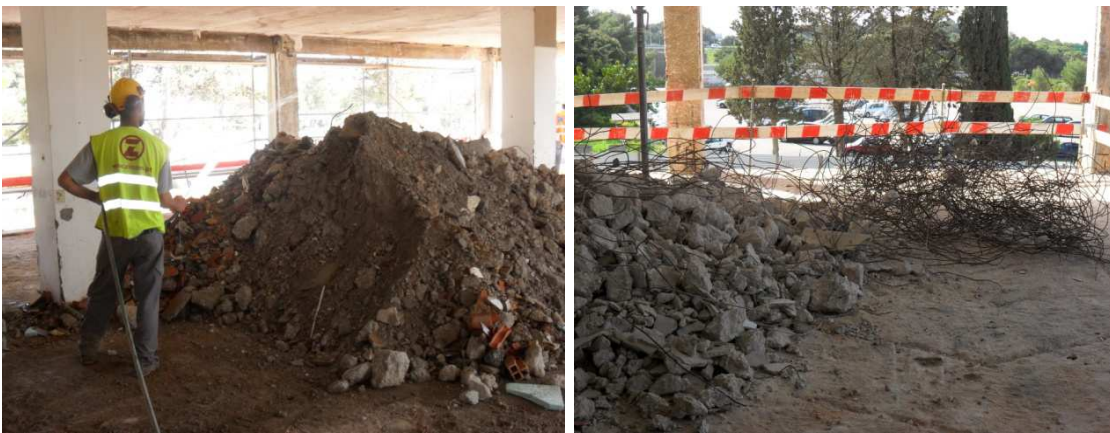
Figura 3.6 - Tratamento e triagem dos resíduos da demolição
