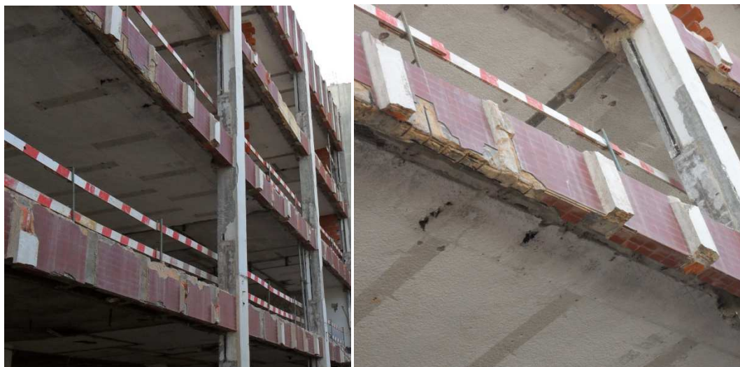
Figura 3.9 - Demolição dos membros em alvenaria da fachada
