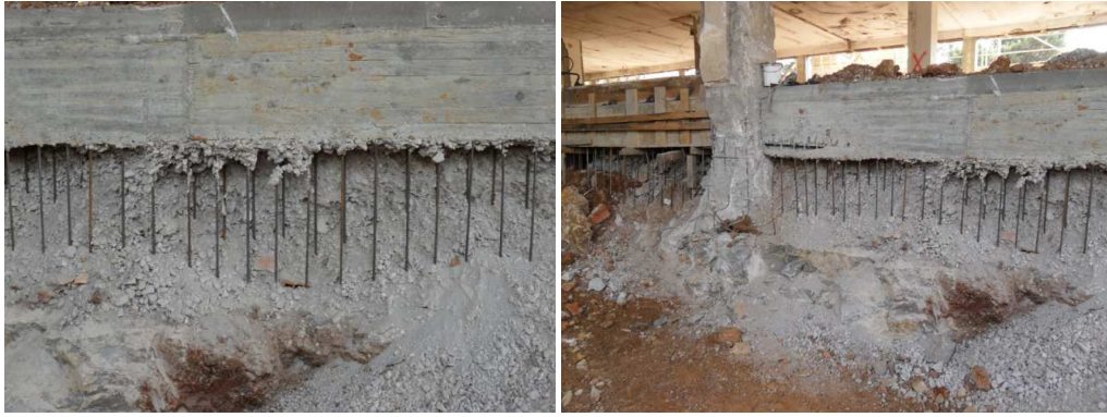
Figura 3.27 - Armaduras de espera do muro de suporte na viga de coroamento
