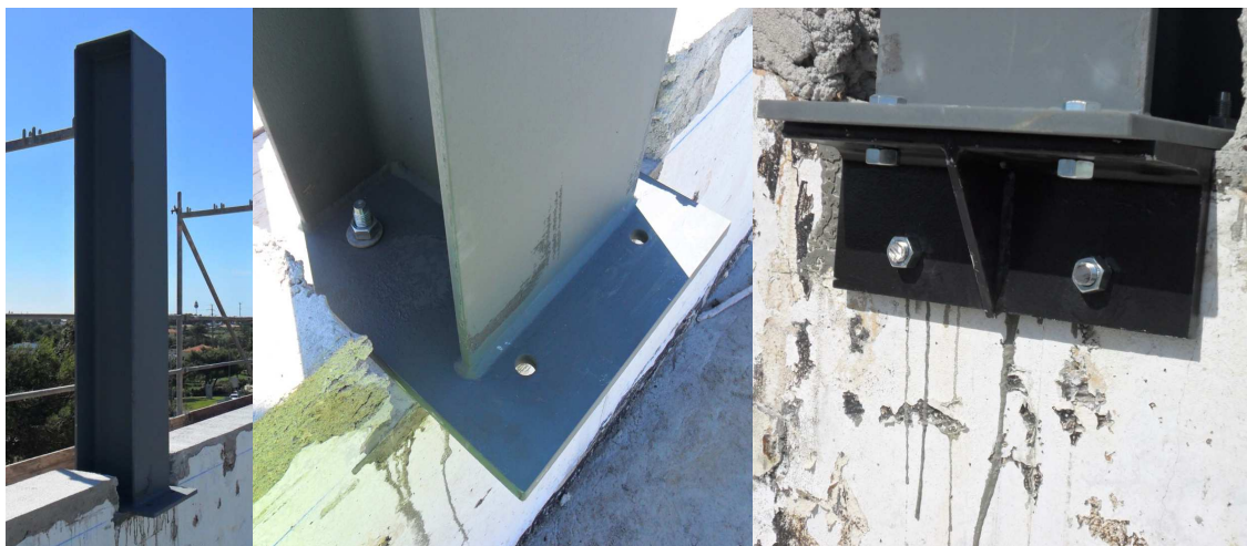
Figura 3.85 - Montagem dos pilares metálicos
