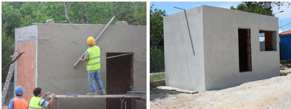
Figura 3.100 - Reboco da portaria
