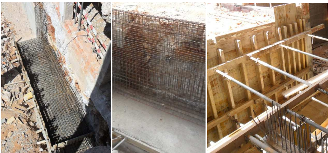
Figura 3.21 - Construção dos muros de suporte
