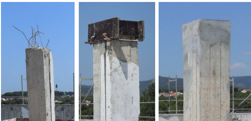
Figura 3.83 - Regularização dos topos dos pilares com “Sika Grout” para apoiar a estrutura metálica
