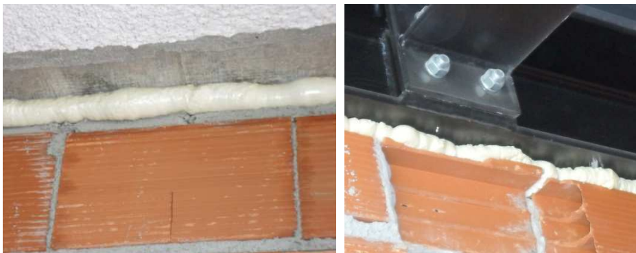
Figura 3.66 - Fixação das alvenarias às lajes e vigas com espuma de poliuretano
