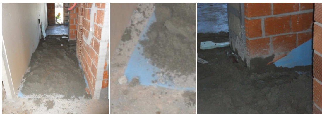
Figura 3.81 - Execução das betonilhas
