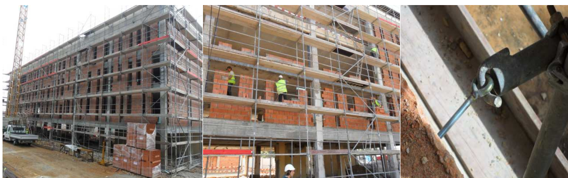
Figura 3.61 - Andaimes montados nas fachadas do edifício
