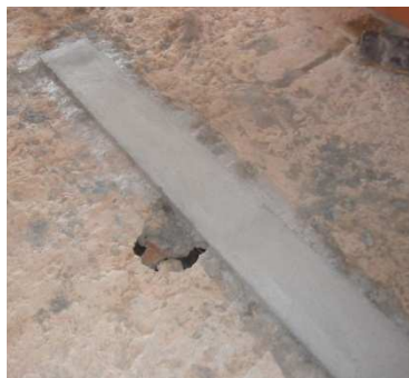
Figura 3.72 - Mestras para apoio das paredes de gesso cartonado
