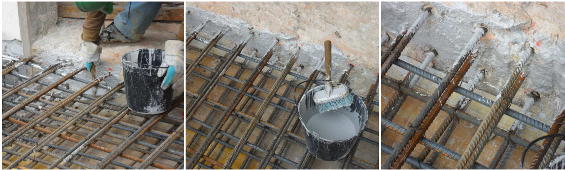
Figura 3.52 - Aplicação de “Sika Icosit K 101 N” na interface entre o betão velho e o betão novo
