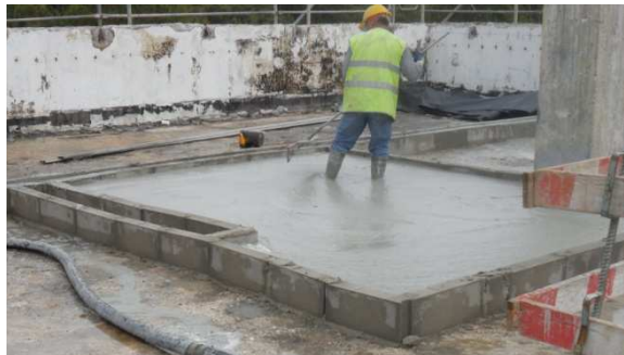
Figura 3.79 - Regularização do betão celular com rodo
