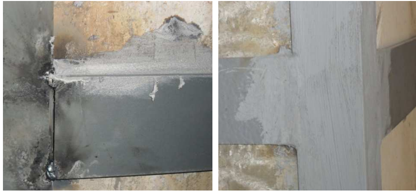
Figura 3.42 - Pormenores - Colagens dos reforços com “Sikadur-30” e pintura de protecção das soldaduras
