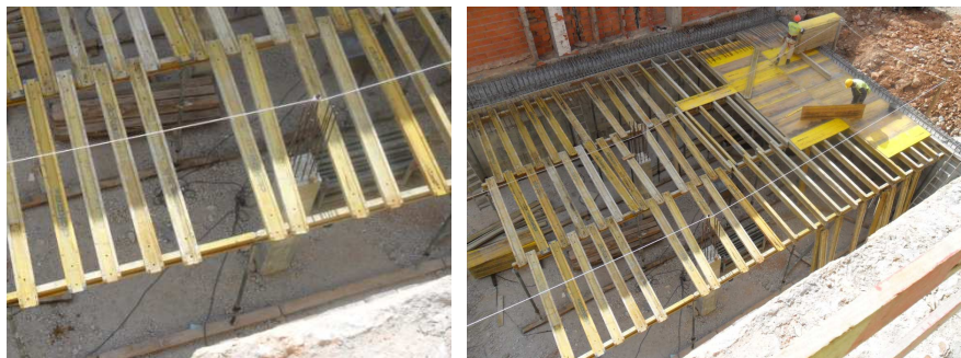
Figura 3.49 - Execução da cofragem da laje do piso 0
