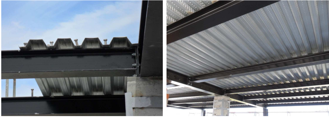
Figura 3.92 - Montagem da chapa colaborante
