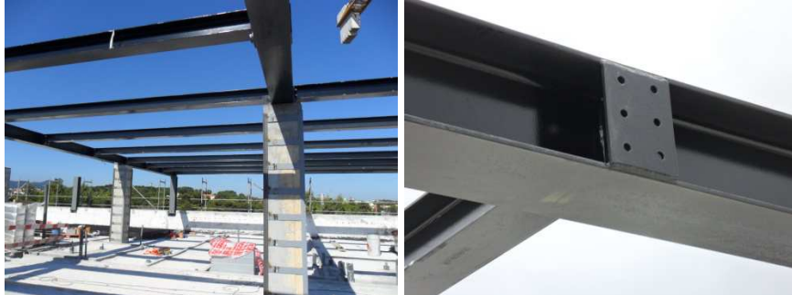
Figura 3.90 - Montagem das vigas metálicas secundárias
