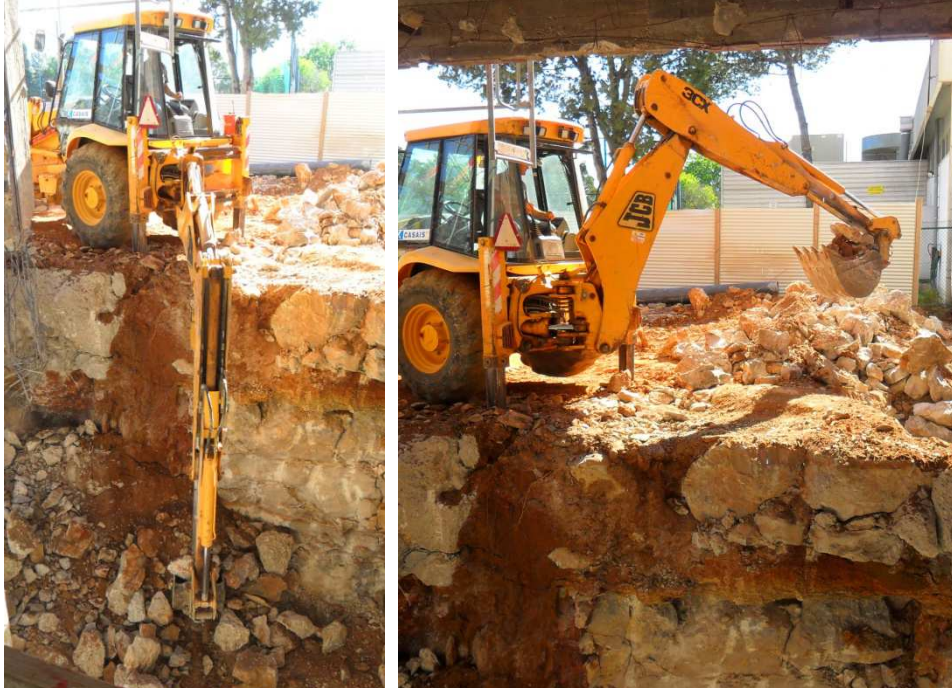
Figura 3.19 - Utilização de retroescavadora para retirar os detritos da escavação da cave
