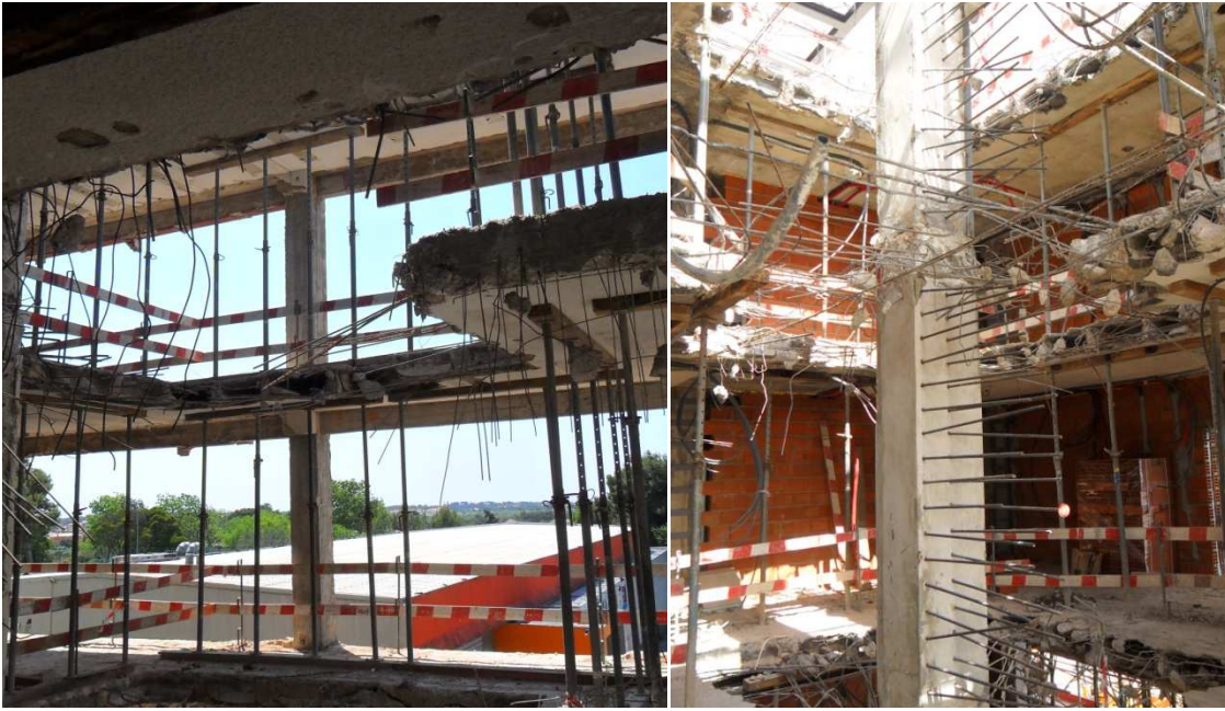
Figura 3.5 - Escoramento na periferia das demolições
