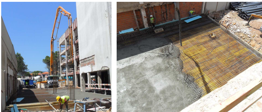
Figura 3.53 - Betonagem da laje com bomba
