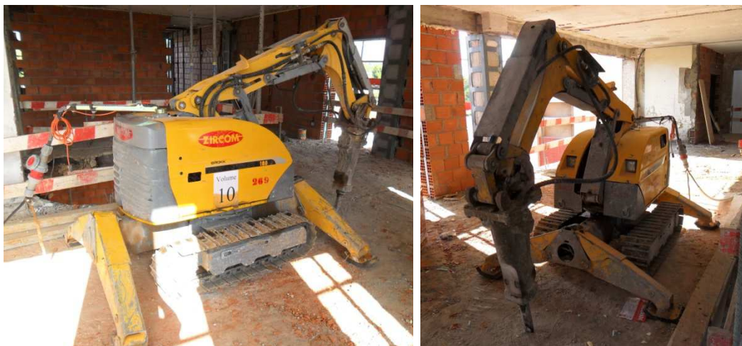
Figura 3.2 - Robot de demolição
