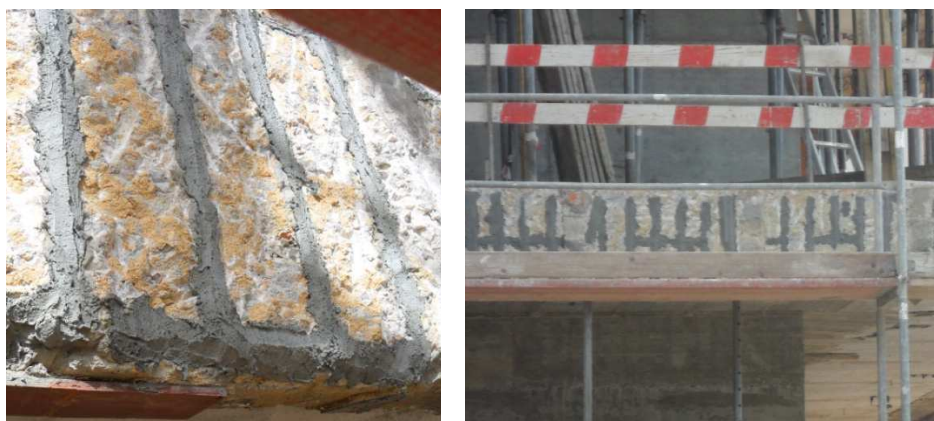
Figura 3.12 - Reparação das vigas de bordadura com “Sika Monotop 612”
