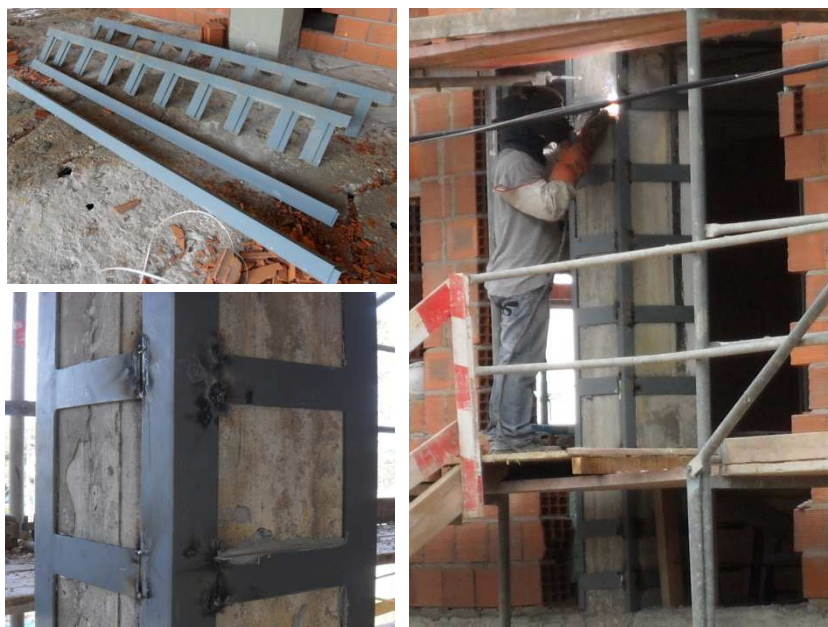
Figura 3.41 - Execução dos reforços dos pilares
