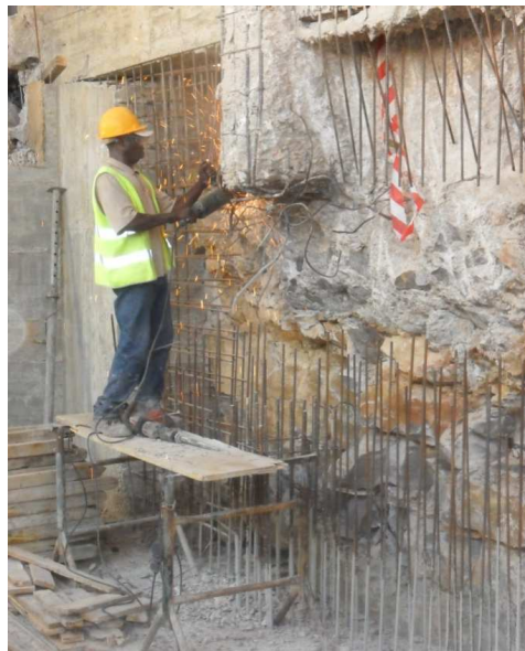
Figura 3.28 - Armaduras de espera na base e no topo do muro de suporte
