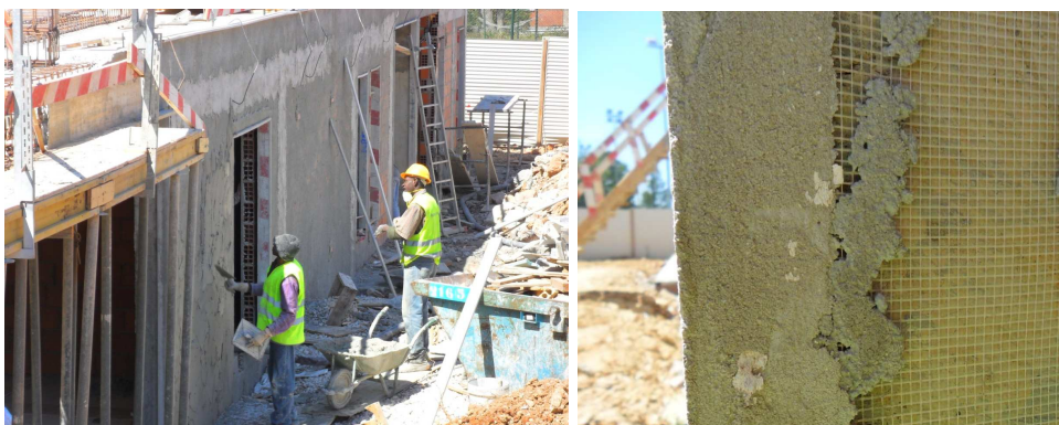
Figura 3.101 - Reboco da zona técnica
