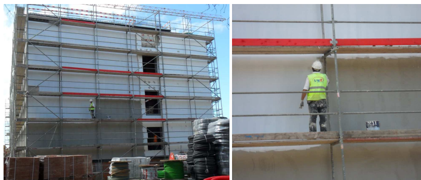
Figura 3.112 – Aplicação da pintura de impermeabilização
