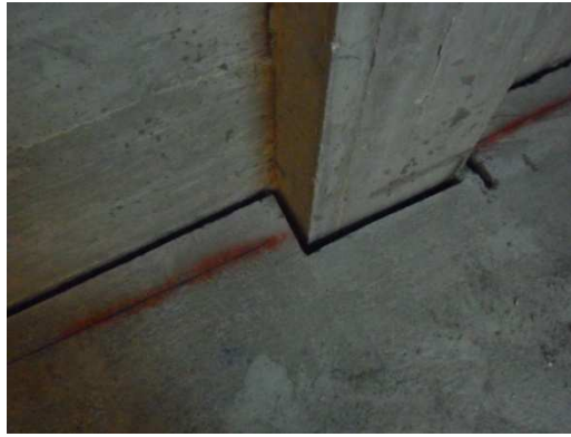
Figura 3.69 - Junta de betonagem do pavimento térreo junto dos muros de contenção
