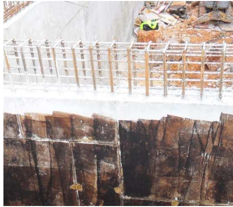
Figura 3.24 - Viga de coroamento por betonar
