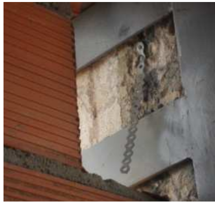
Figura 3.65 Ligação das alvenarias aos pilares
