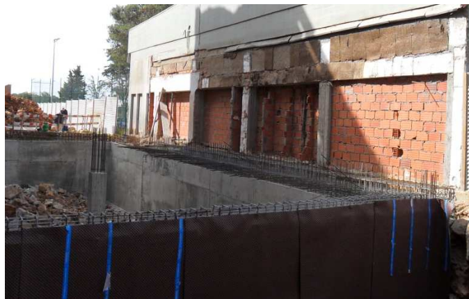
Figura 3.15 - Contenção da cave junto ao edifício vizinho
