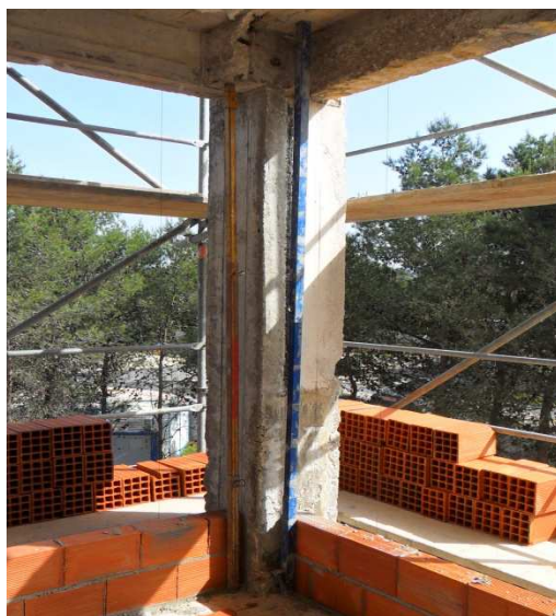
Figura 3.60 - Prumos metálicos para auxiliar a execução das alvenarias
