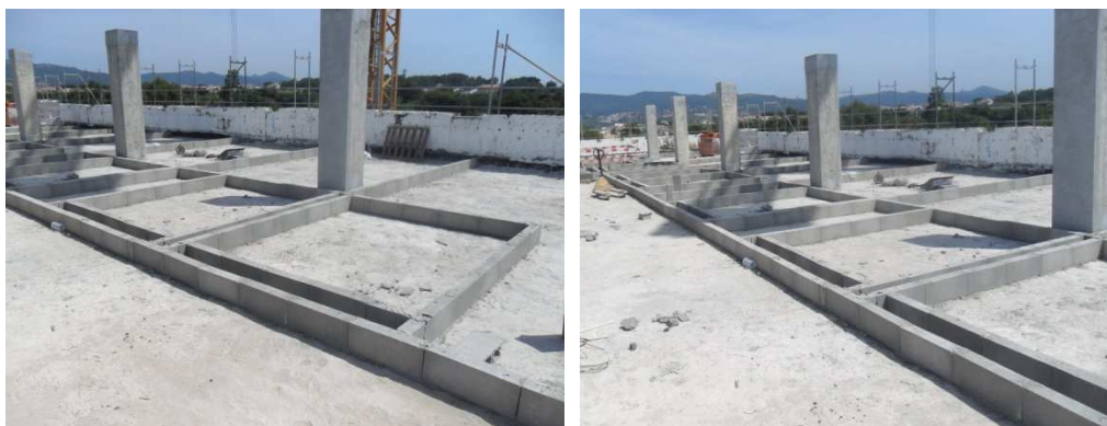
Figura 3.76 - Colocação de blocos de betão para apoio das paredes na zona a aplicar o betão celular
