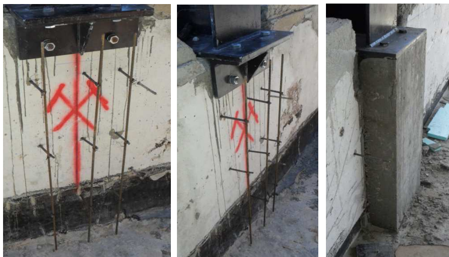
Figura 3.86 - Reforço do apoio dos pilares metálicos com a construção de um " pilar" em betão armado
