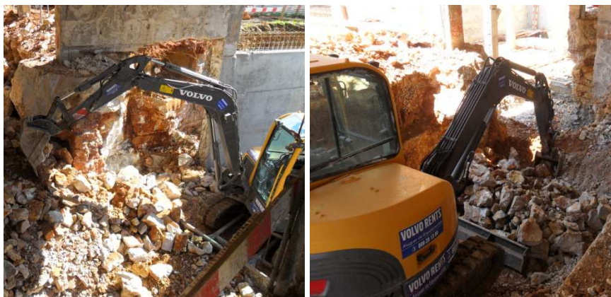
Figura 3.18 - Utilização de escavadora giratória leve na escavação
