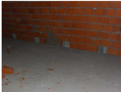
Figura 3.70 - Pano de alvenaria junto dos muros de contenção
