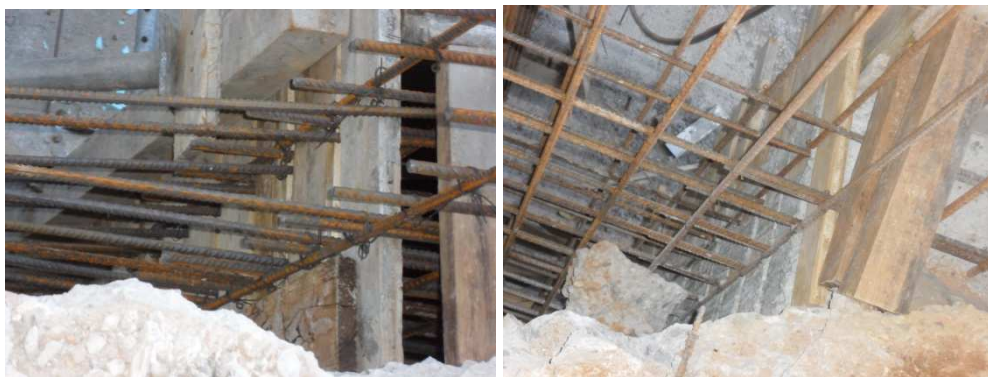
Figura 3.23 - Cofragem lateral dos muros com tábuas de madeiras entre as armaduras
