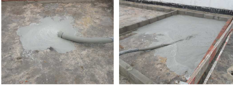
Figura 3.78 - Bombagem do betão celular através de mangueiras
