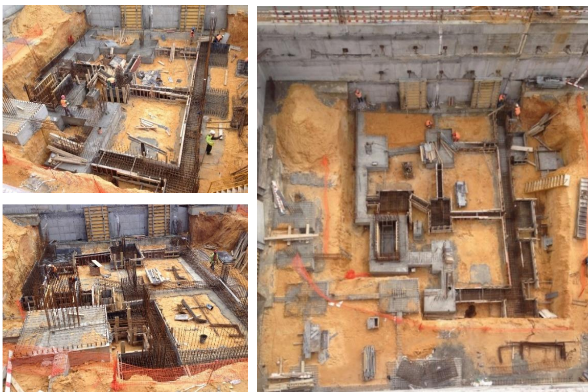
Figura 4.19 - Execução de cofragem das fundações do lote 6.5, piso -3.
