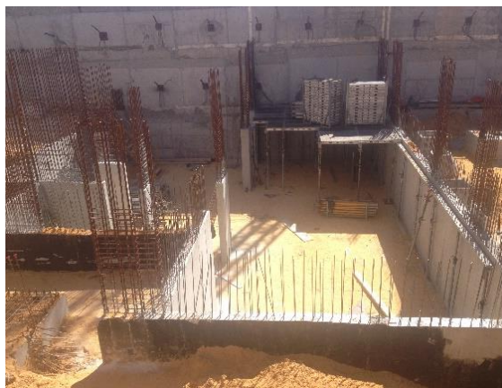
Figura 4.36 - Preparação para execução da cofragem de laje.
