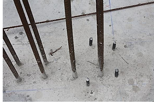
Figura 4.26 - Trabalhos preparatórios para cofragem do pilar.
