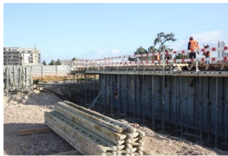
Figura 2.33 - Cofragem laje piso 0, Praia do Sal Wellness Resort .
