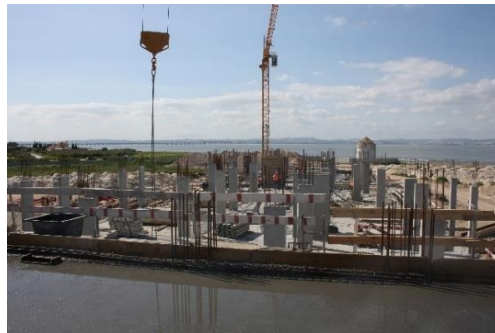
Figura 2.38 - Conclusão dos pilares lote D, Praia do Sal Wellness Resort .
