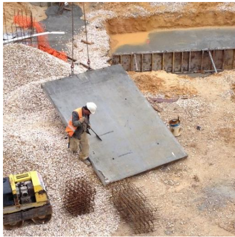
Figura 4.27 - Limpeza do painel de cofragem.
