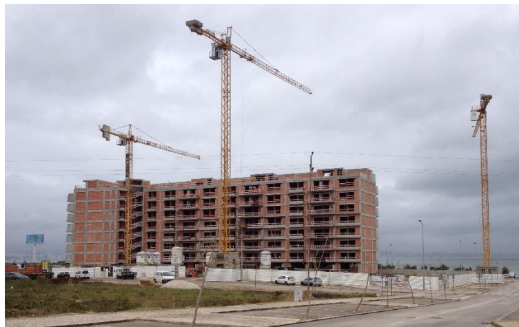
Figura 2.27 - Posicionamento das gruas, Fase 2, River Terraces .
