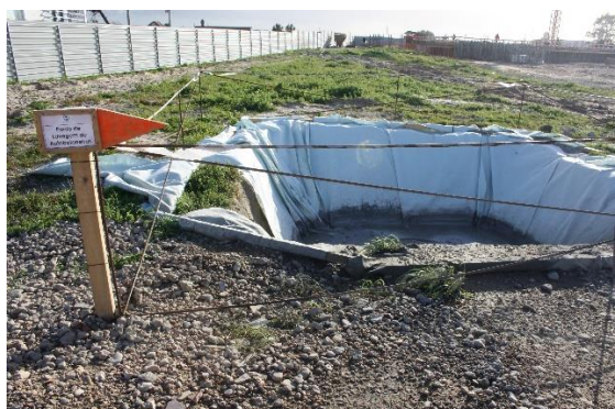
Figura 2.23 - Zona de lavagem de autobetoneiras da obra Praia do Sal Wellness Resort .
