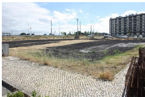
Figura 2.30 - Início dos trabalhos lote adjacente, River Terraces .
