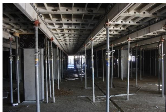
Figura 4.10 - Cofragem ligeira ou desmembrável (lajes).
