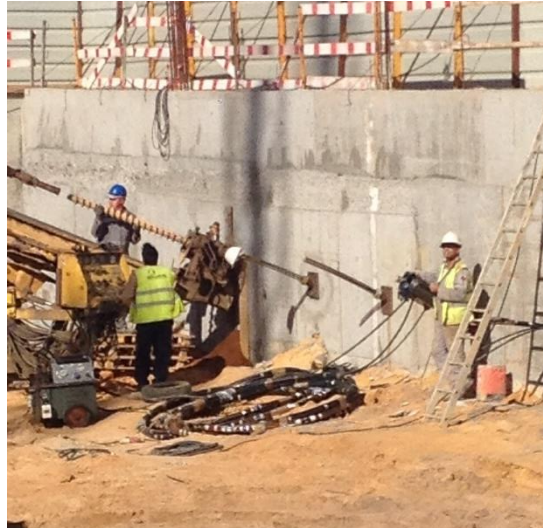
Figura 2.41 - Execução do tensionamento das ancoragens, River Terraces.
