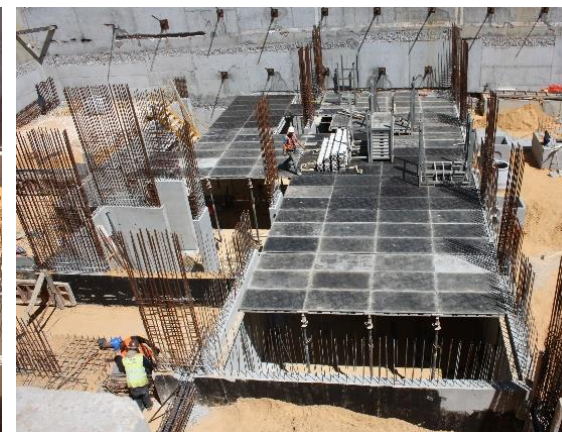
Figura 4.37 - Execução da cofragem de laje.
