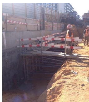
Figura 2.40 - Execução da cofragem dos painéis de contenção, River Terraces .
