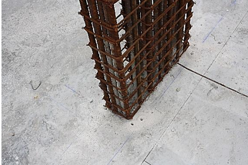
Figura 4.25 - Marcação do pilar pelo topógrafo.
