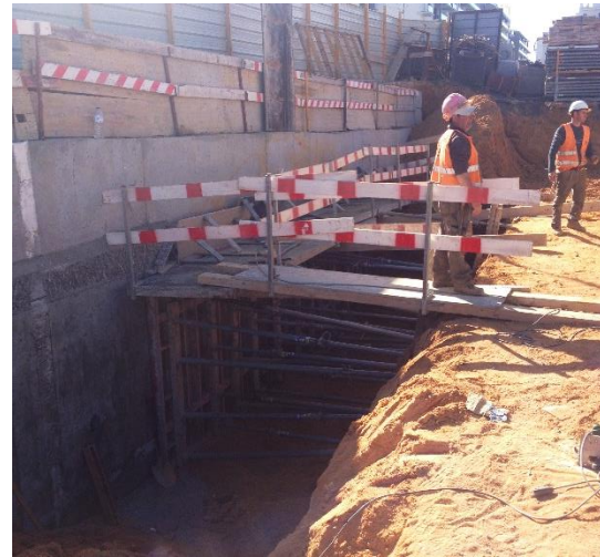
Figura 4.17 - Cofragem dos painéis de contenção.
