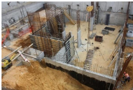
Figura 4.22 - Execução da cofragem dos elementos verticais do lote 6.5, piso -3.
