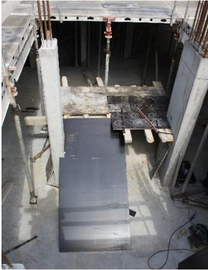
Figura 5.10 - Execução da cofragem do patamar e dos lanços de escadas.
