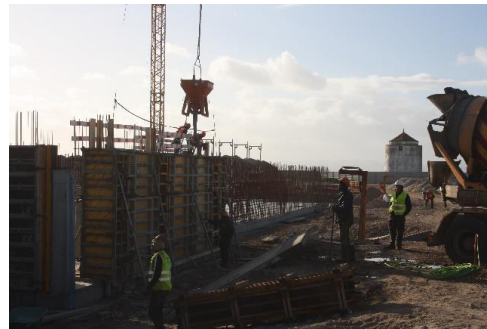
Figura 2.35 - Execução paredes de betão no segundo lote, Praia do Sal Wellness Resort .
