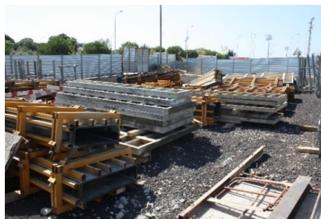
Figura 2.31 - Armazenamento de cofragem lote adjacente, River Terraces .
