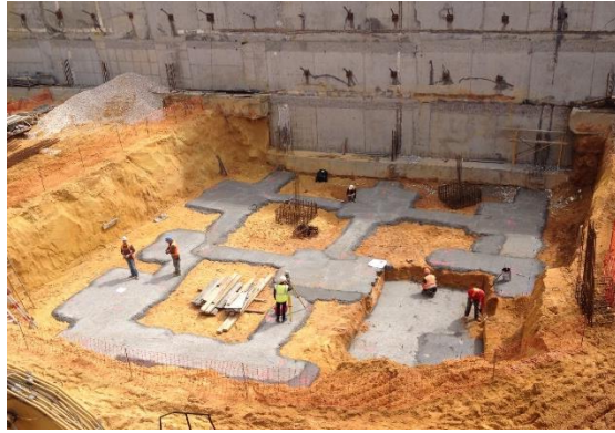
Figura 4.20 - Marcação das fundações do lote 6.7, piso -3 pelo topógrafo.
