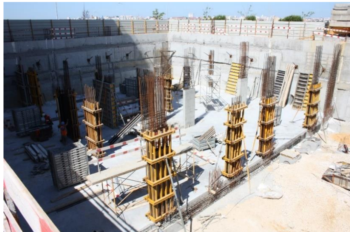
Figura 4.32 - Pilares prontos a betonar, lote 6.5, piso -2.
