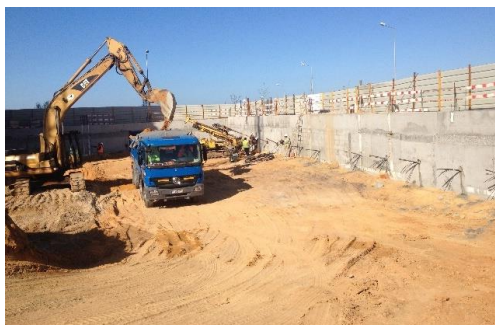
Figura 2.39 - Execução dos trabalhos de escavação, River Terraces .
