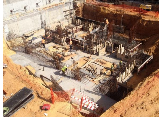
Figura 4.21 - Aplicação das armaduras e execução da cofragem do lote 6.7, piso -3.
