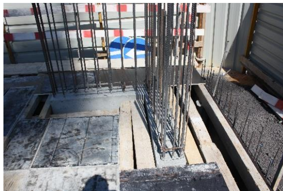
Figura 4.39 - Execução do acabamento de laje em cofragem híbrida.
