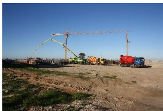
Figura 2.24 - Zona de autobetoneiras da obra Praia do Sal Wellness Resort .
