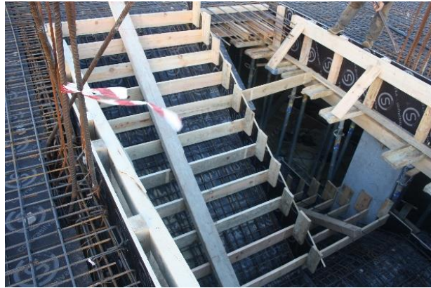
Figura 5.11 - Elaboração da cofragem dos degraus.
