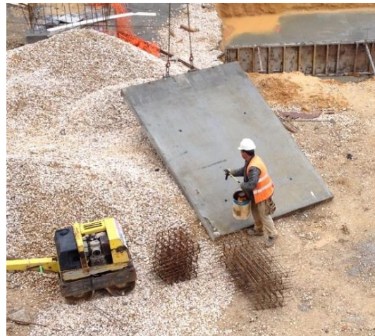
Figura 4.28 - Aplicação do óleo descofrante no painel de cofragem.
