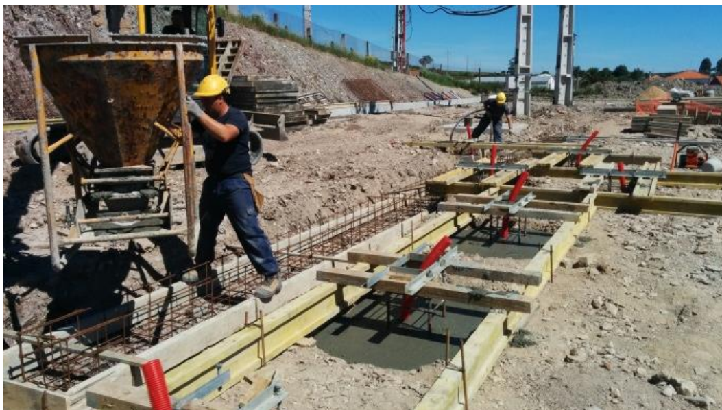
Imagem 45 - Betonagem de maciços MI e soleira de canal tipo I
