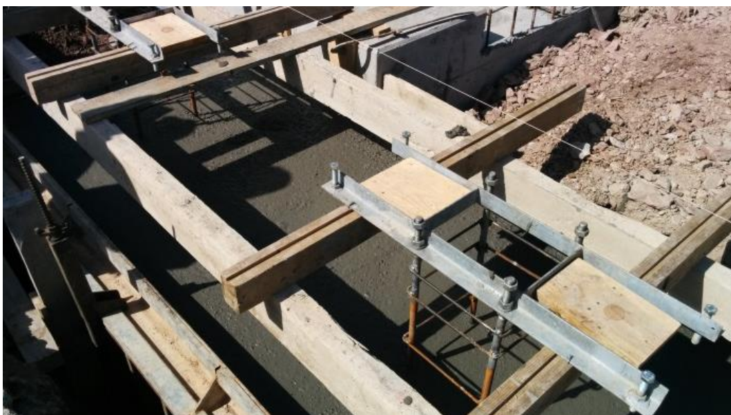
Imagem 38 - Maciço MIII após betonagem
