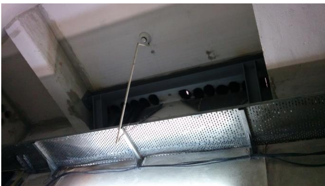
Imagem 73 - Estrutura metálica de apoio à laje intermédia
