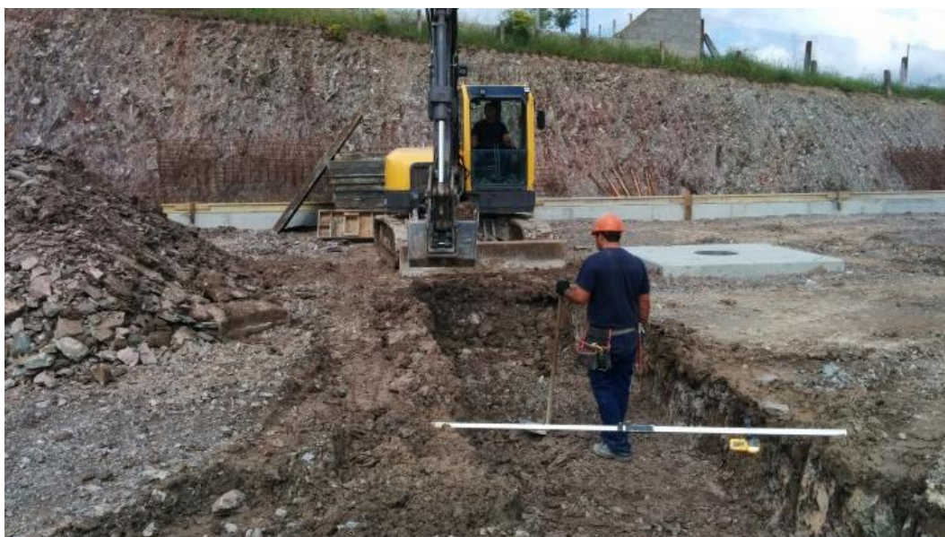
Imagem 41 - Escavação para execução de canal tipo II
