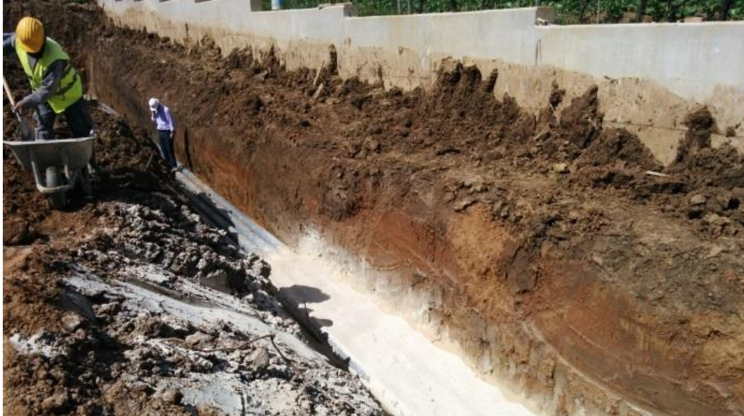
Imagem 62 - Execução de valas para travessias de cabos
