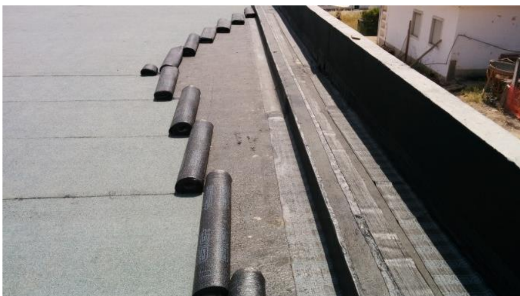
Imagem 51 - Aplicação de tela de impermeabilização na cobertura do EC
