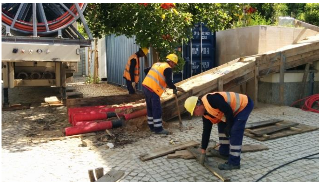
Imagem 68 - Desmontagem de passagens provisórias de cabos
