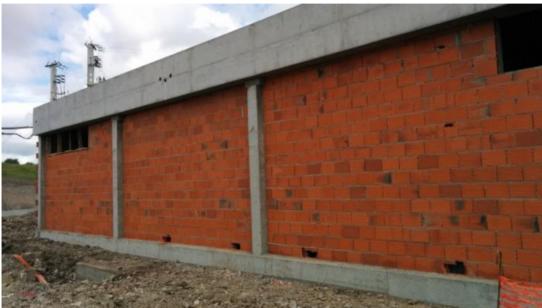
Imagem 44 - Execução de alvenarias em parede dupla no edifício de comando
