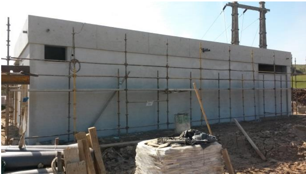
Imagem 59 - Reboco exterior no EC
