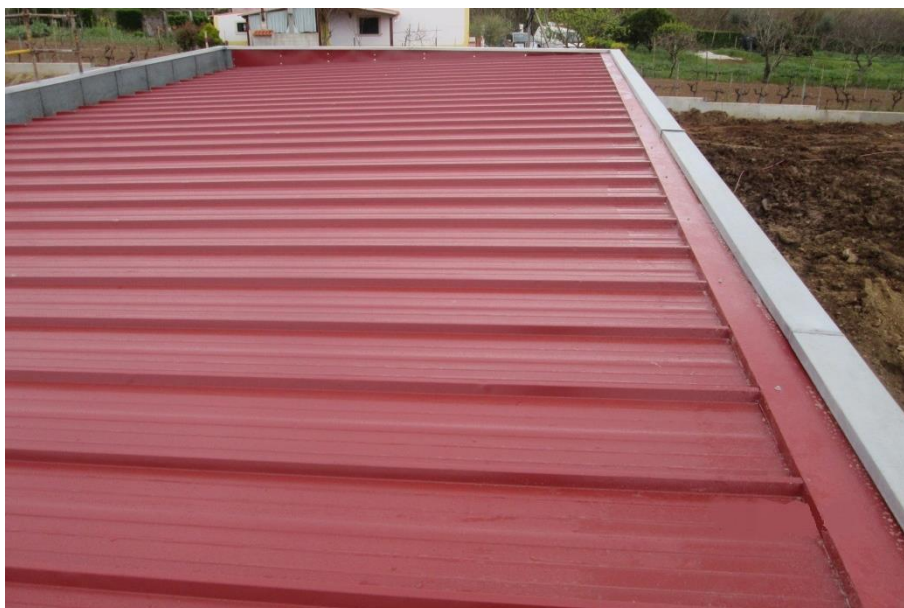
Imagem 12 - Cobertura EC terminada (1ª fase)
