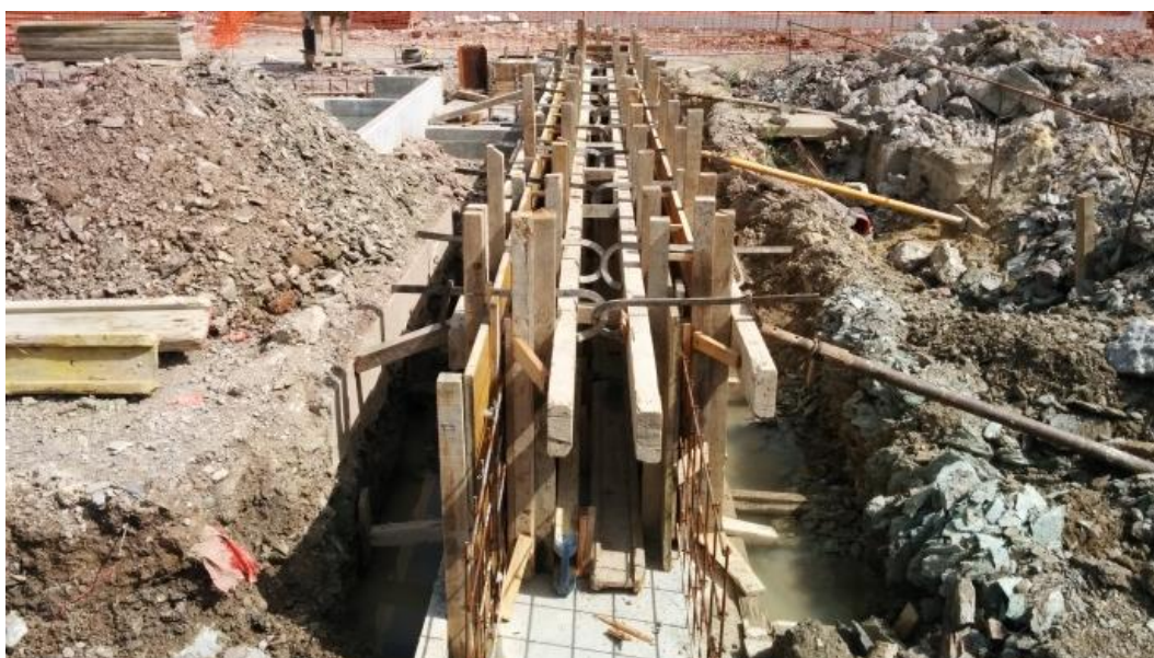
Imagem 42 - Execução de canal tipo III
