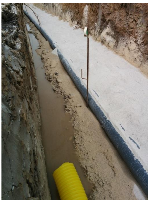
Imagem 61 - Execução de dreno
