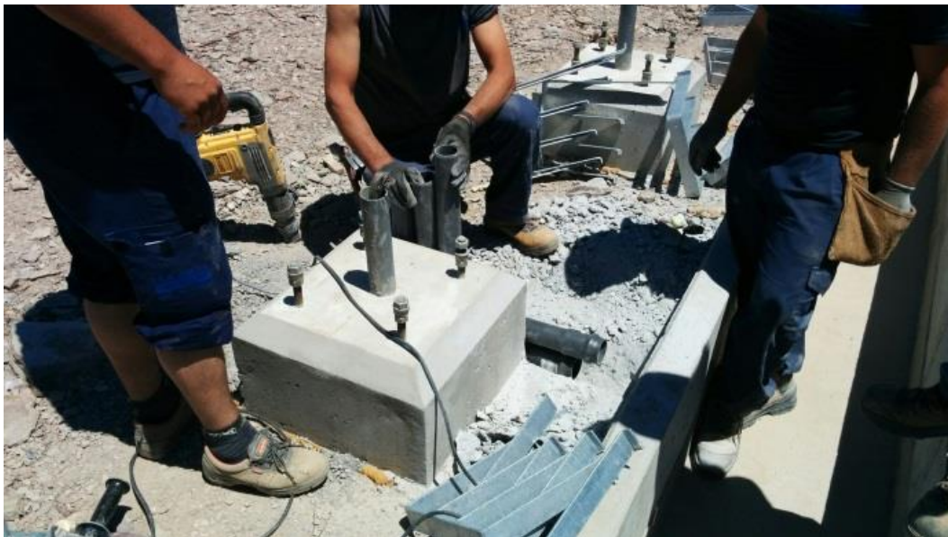
Imagem 57 - Colocação de tubagem junto de maciços para passagem de cabos
