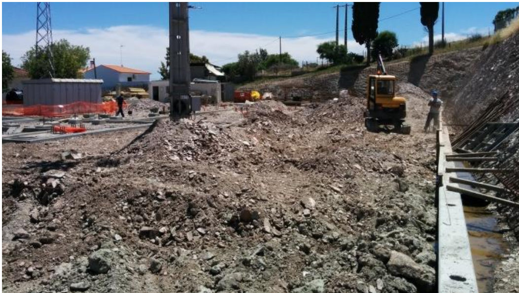
Imagem 52 - Escavação para execução de rede de terras
