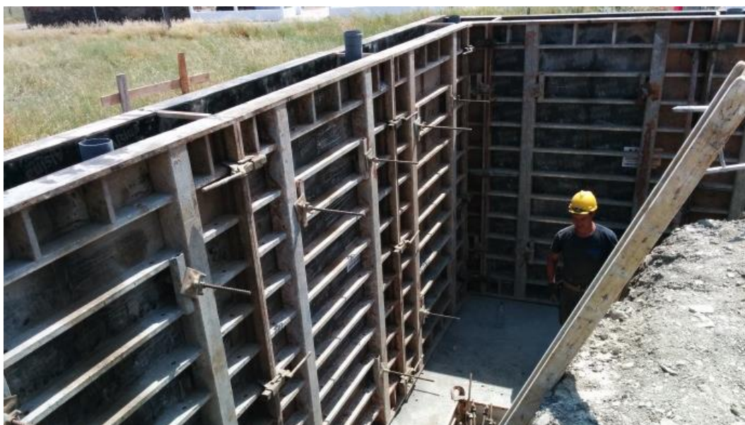
Imagem 50 - Execução de cofragem de muro de suporte
