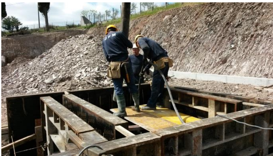
Imagem 33 - Betonagem de caixa recetora de óleos
