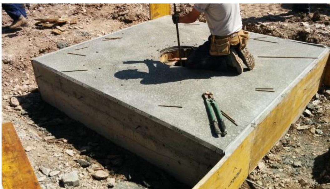
Imagem 40 - Remoção de cofragem de caixa recetora de óleos
