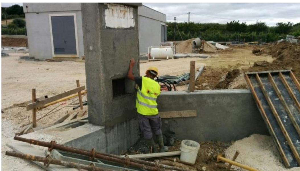
Imagem 64 - Retoques na ombreira do portão de entrada
