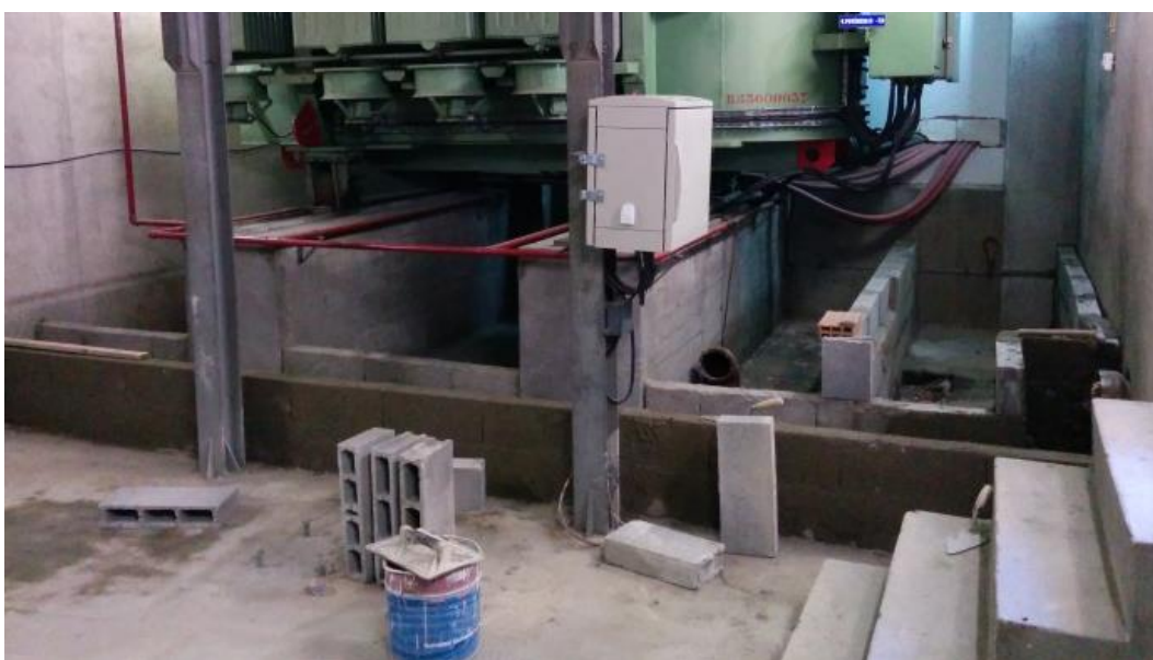
Imagem 67 - Execução de bacia de contenção de transformador de potência
