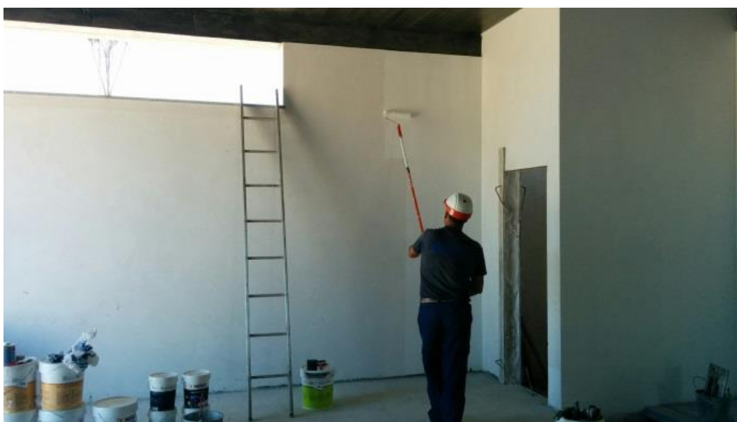
Imagem 56 - Pinturas interiores no edifício de comando
