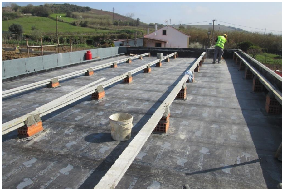
Imagem 11 - Cobertura do EC em construção (1ª fase)
