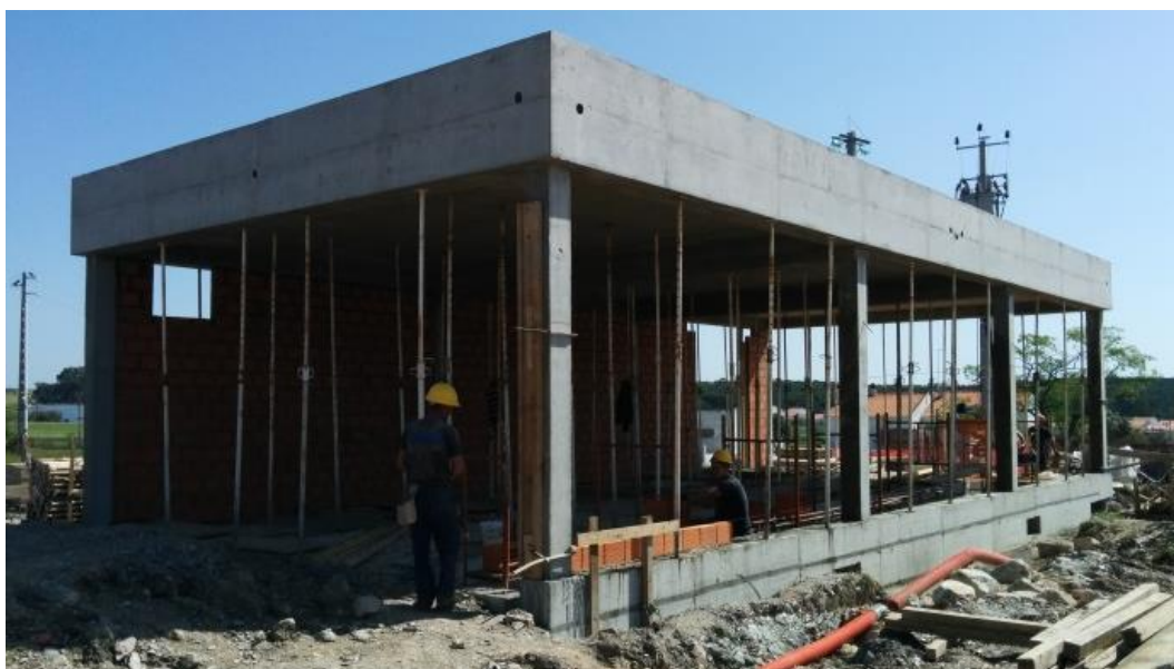
Imagem 39 - Execução de alvenarias no EC
