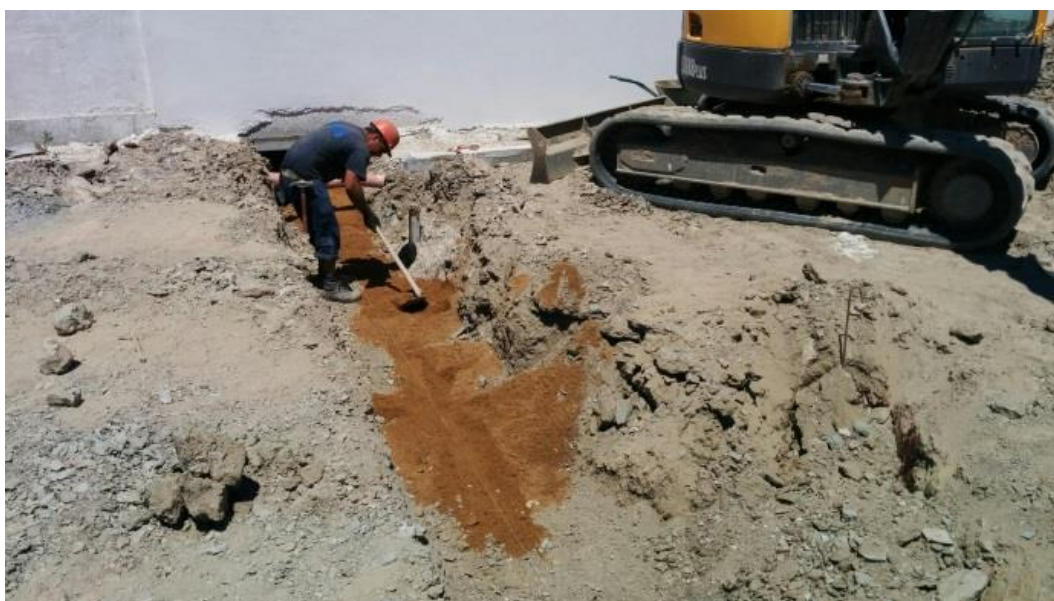
Imagem 55 - Execução de travessias para passagem de cabos
