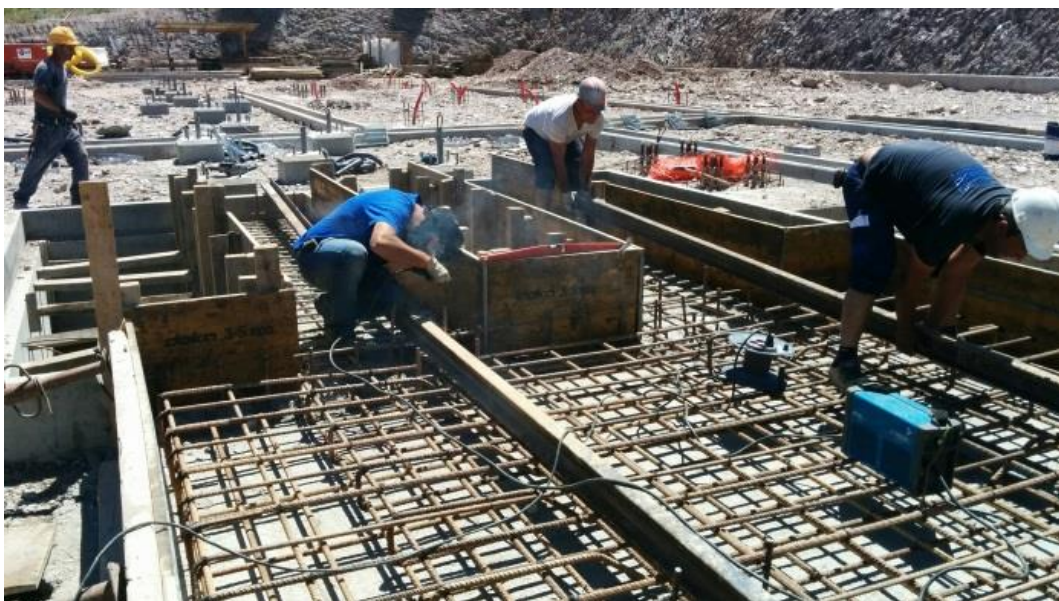
Imagem 54 - Alinhamento de carris no maciço do transformador de potência
