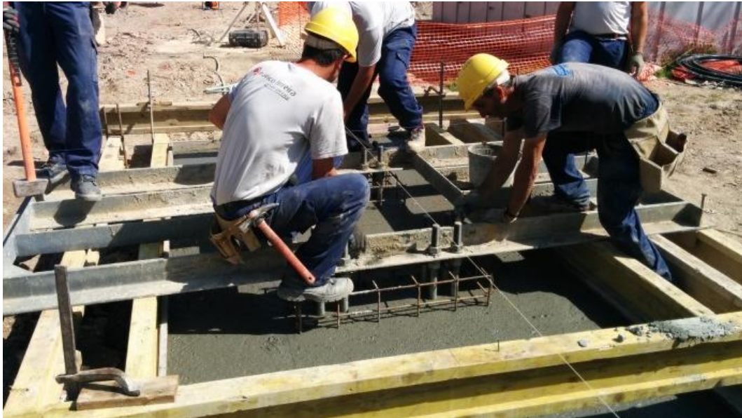
Imagem 37 - Acertos finais após betonagem de maciço MP
