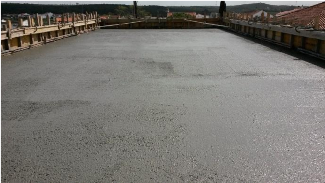
Imagem 31 - Laje de cobertura e platibanda após betonagem
