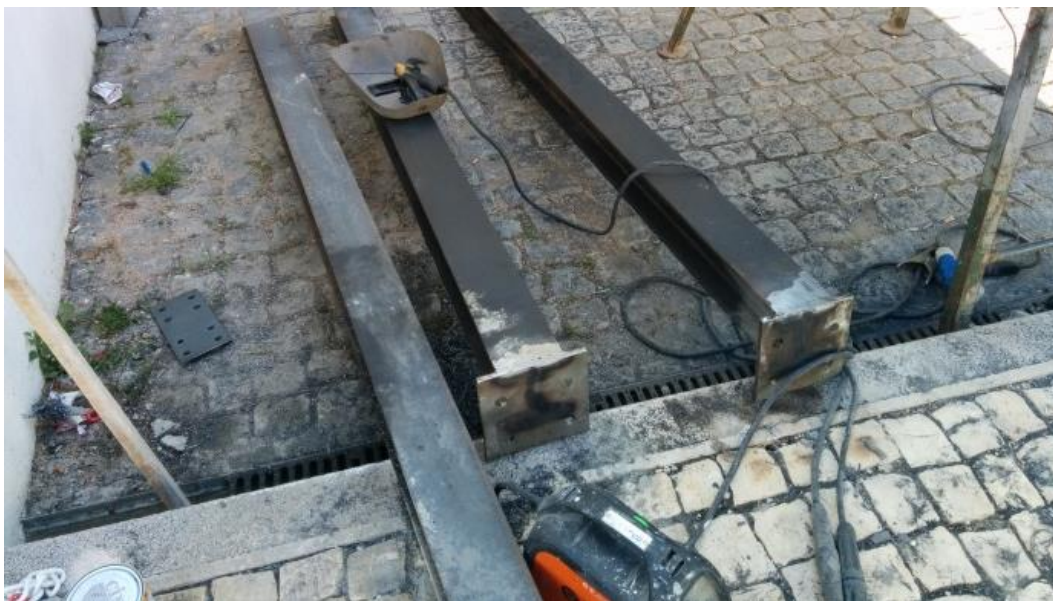
Imagem 66 - Execução de estrutura metálica para apoio à laje intermédia
