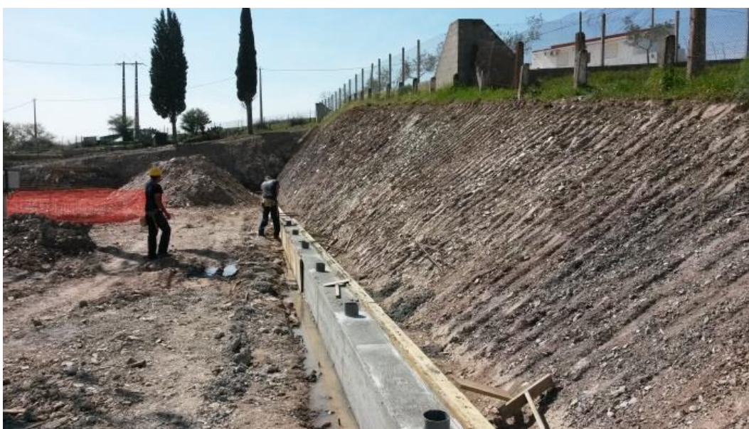
Imagem 30 - Desmontagem de cofragem em muros de vedação
