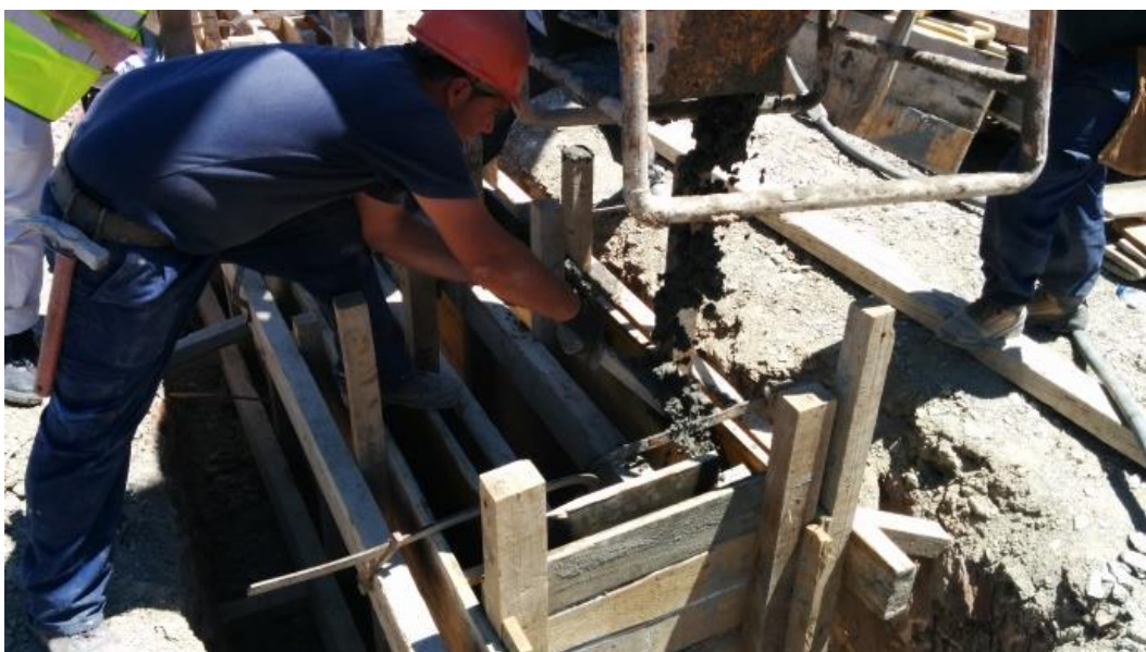
Imagem 53 - Betonagem de canal tipo I
