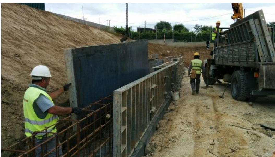
Imagem 65 - Execução cofragem e colocação de armaduras em muros de suporte
