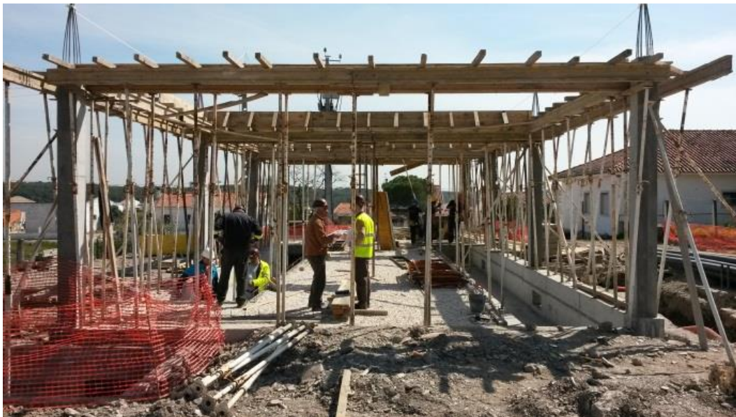
Imagem 29 - Montagem de cofragem de vigas em EC
