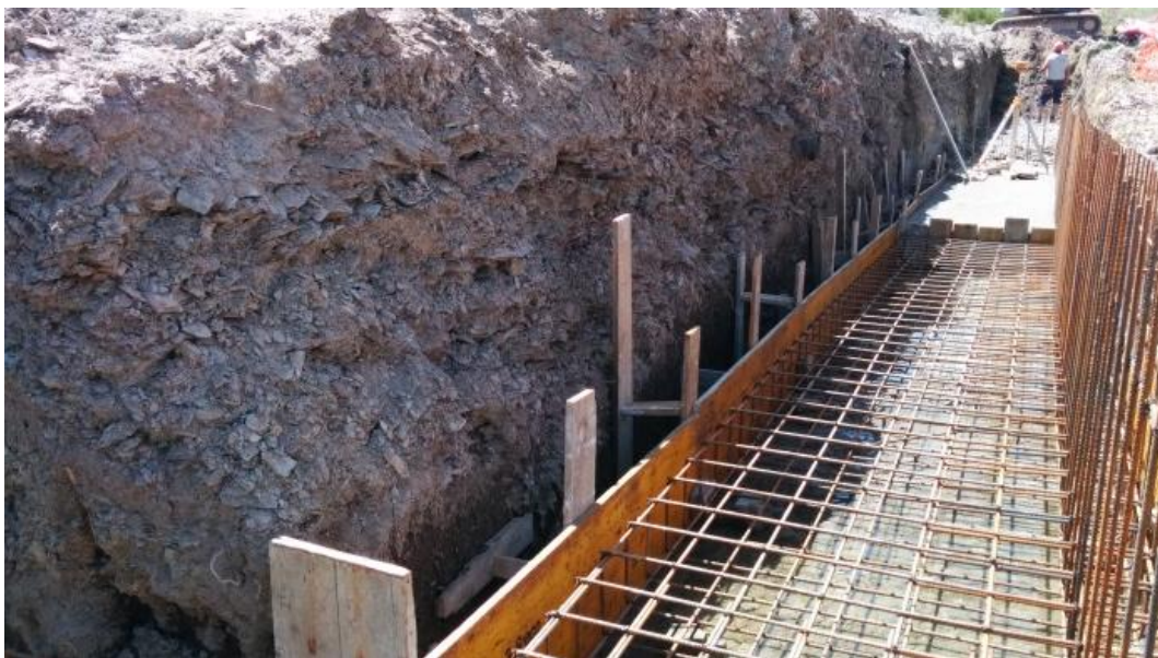
Imagem 47 - Execução de muros de suporte
