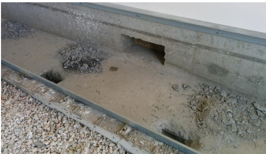
Imagem 49 - Colocação de serralharias no edifício de comando
