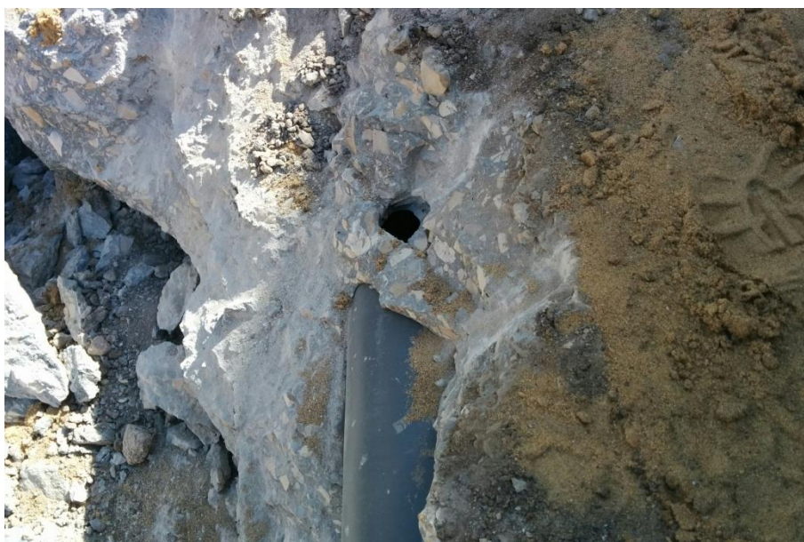
Imagem 84 - Perfuração de travessia com cabos em tensão
