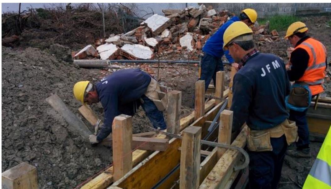
Imagem 35 - Execução de muros de vedação
