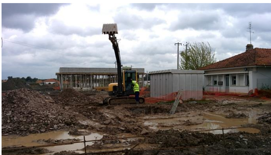
Imagem 36 - Escavação para execução de maciço MP
