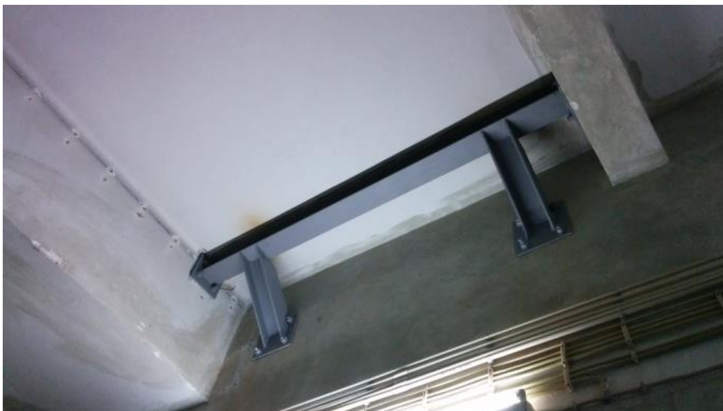
Imagem 72 - Estrutura metálica de apoio à laje intermédia
