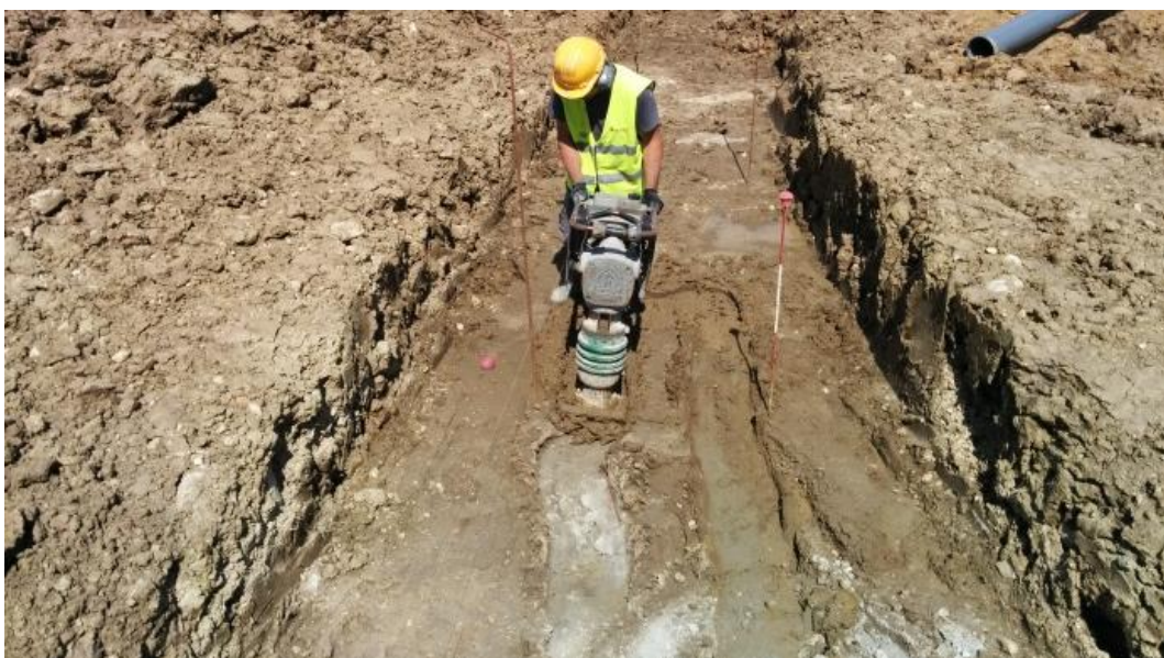
Imagem 63 - Execução de vala para canal tipo I
