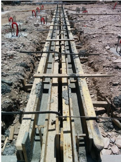
Imagem 48 - Betonagem de canal tipo I
