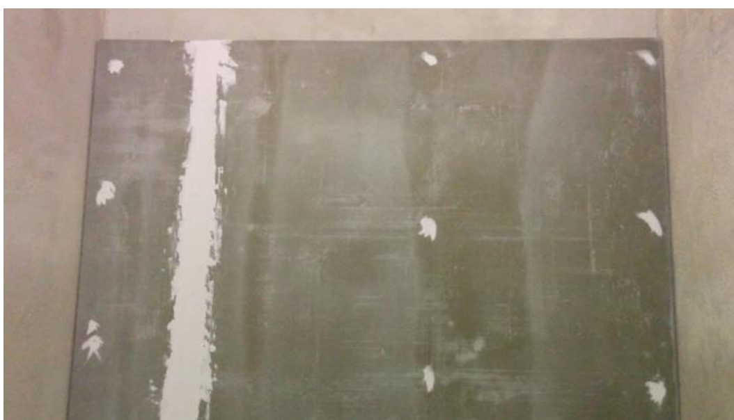
Imagem 69 - Aplicação de placas do tipo “Viroc”
