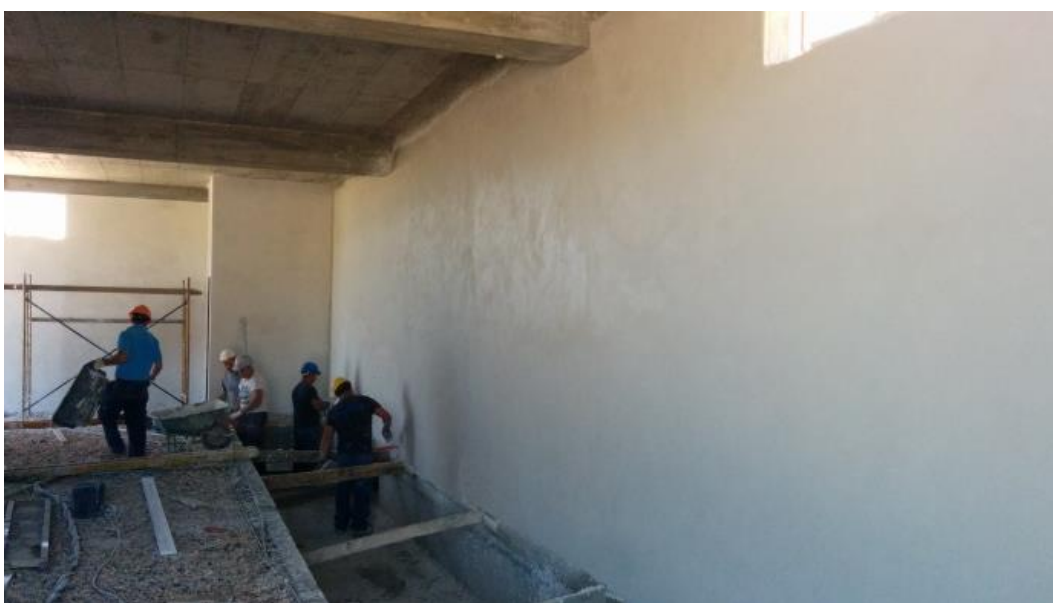
Imagem 46 - Execução de reboco interior no edifício de comando
