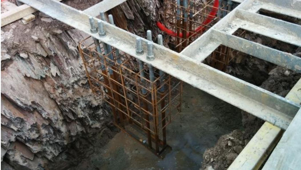
Imagem 43 - Colocação de armaduras para execução de maciço MP
