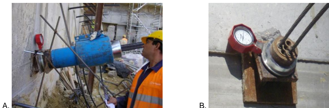
Figura 4.18. A. Macacos hidráulicos para tensionamento dos cordões das ancoragens, na Rua Ivens, n.º 21 a 33; B. Célula de carga de leitura manométrica
