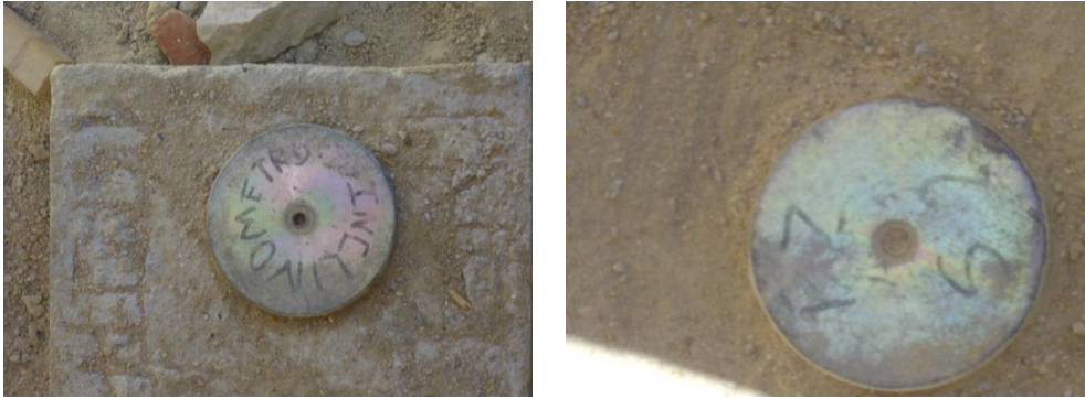
Figura 4.2. Bases do inclinómetro e do piezómetro, na Rua Ivens, n.º 21 a 33
