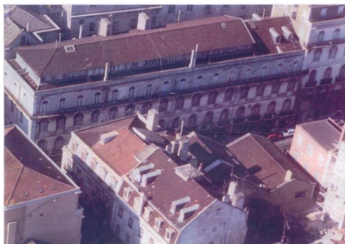
Figura 3.15. Estrutura das coberturas dos edifícios pombalinos da Rua dos Duques de Bragança, n.º 5-A a 5-M
