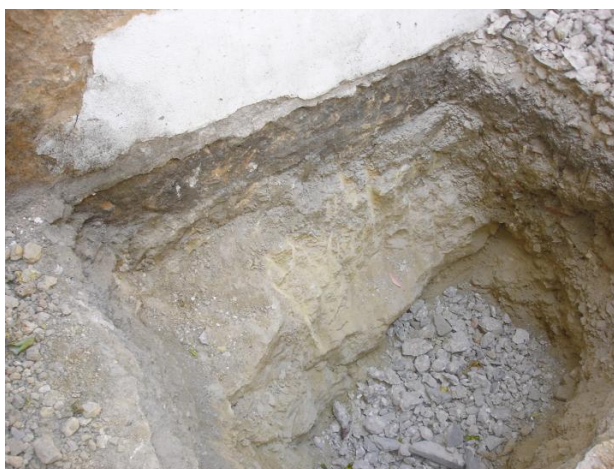
Figura 2.10. Poço de escavação, de pequena profundidade, na Rua Ivens, n.º 52 a 64
