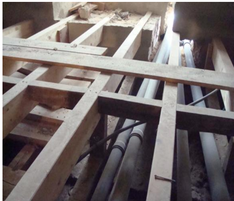
Figura 3.6. Pavimento com aproveitamento da passagem da rede de esgotos, na Rua dos Duques de Bragança, n.º 5-A a 5-M
