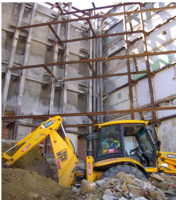
Figura 4.4. Pá carregadora, na Rua Ivens, n.º 21 a 33
