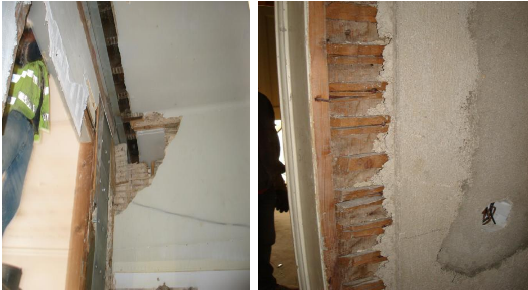
Figura 3.12. Paredes de compartimentação, em tabique, na Rua Ivens, n.º 52 a 64
