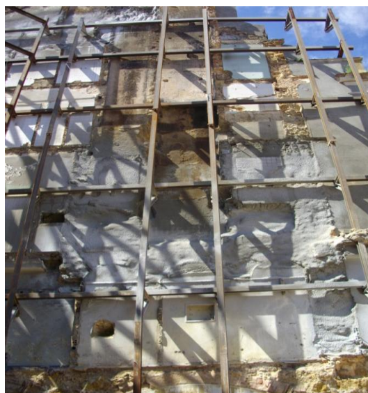
Figura 4.6. Travamento interior, na Rua Ivens, n.º 21 a 33
