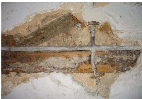
Figura 3.2. Tubagem em chumbo da rede de águas na parede de frontal, com cruz de S. to André, na Rua Ivens, n.º 52 a 64
