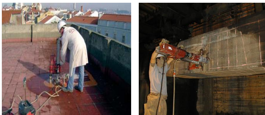
Figura 2.13. Extracção de carotes numa laje e numa viga [19]
