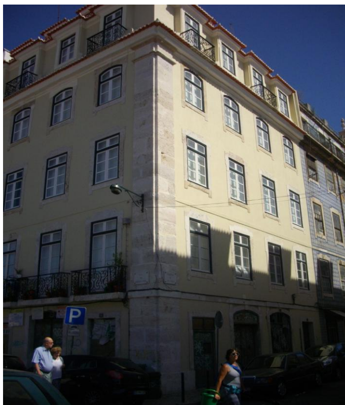
Figura 3.20. Revestimento da fachada exterior, na Travessa de S. Paulo, n.º 1 a 7
