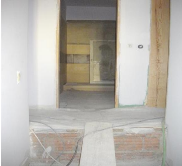
Figura 3.5. Instalações sanitárias, que subiram dois degraus, na Rua dos Duques de Bragança, n.º 5-A a 5-M
