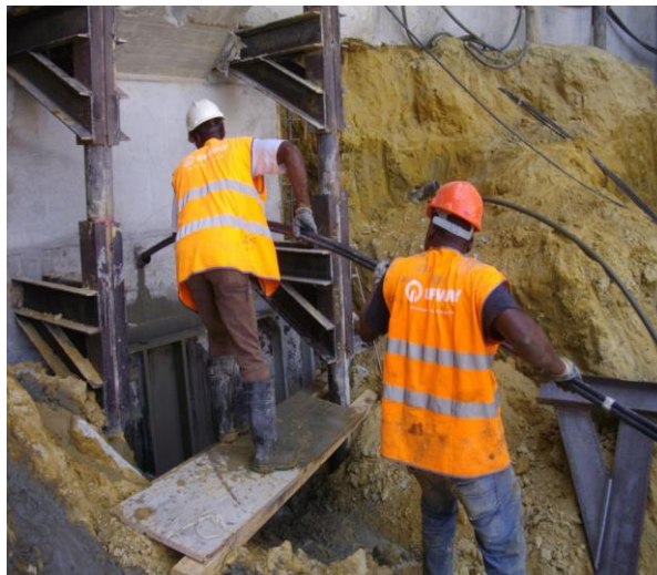
Figura 4.17. Colocação de cordões de ancoragem protegidos por bainha lisa, na Rua Ivens, n.º 21 a 33
