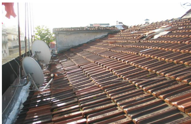
Figura 2.3. Cobertura em telha, remendada com tela de alumínio e antenas, na Rua dos Fanqueiros, n.º 265
