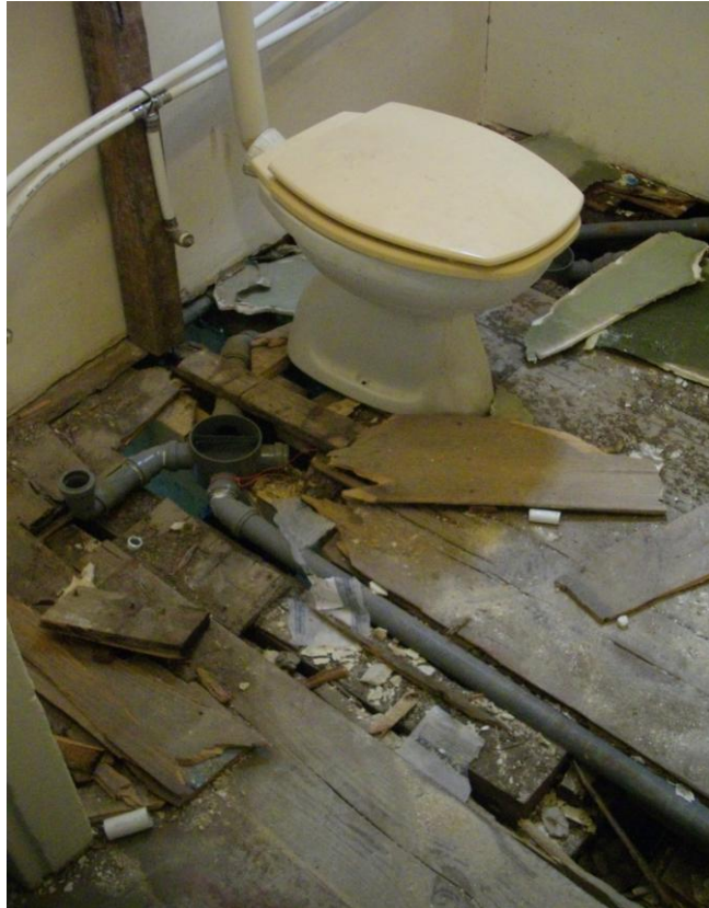
Figura 3.3. Rede de esgotos em edifício pré-pombalino, na Rua Oliveira ao Carmo
