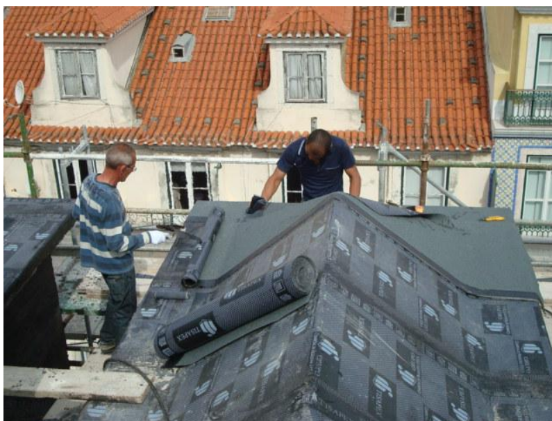
Figura 3.19. Impermeabilização na Rua Ivens, n.º 63 a 75, que torneja para a Rua Garrett, n.º 25 a 35
