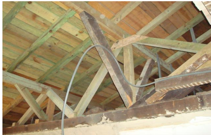
Figura 3.16. Asnas de cobertura, na Rua dos Duques de Bragança, n.º 5-A a 5-M
