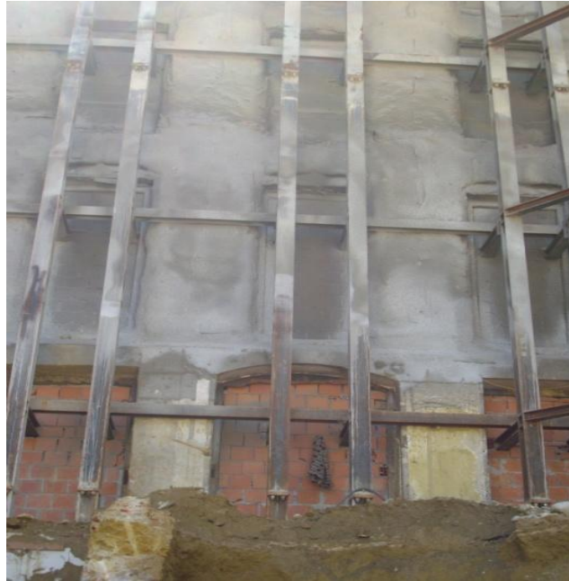
Figura 4.3. Projecção de argamassa no paramento interior da fachada, na Rua Ivens, n.º 21 a 33
