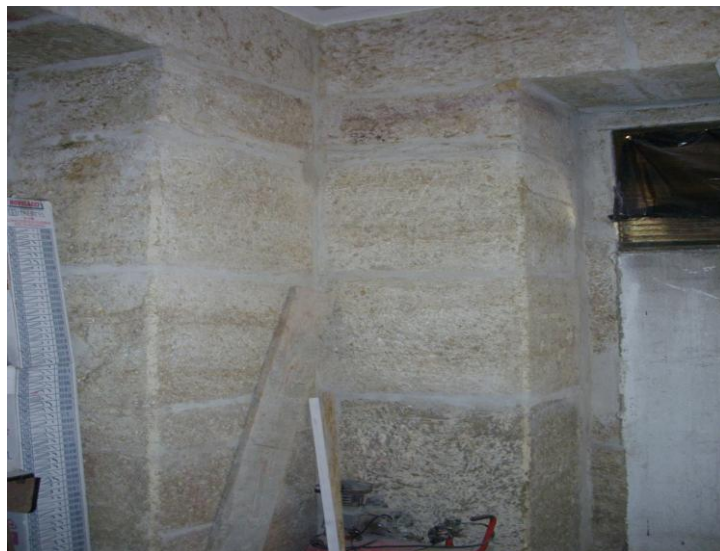
Figura 3.22. Limpeza de pedra da engra da fachada, na Travessa de S. Paulo, n.º 1 a 7
