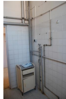
Figura 2.3.38. Revestimento da Parede Interior da Instalação Sanitária, no Piso 0 [Fonte: Autora, Data: 19-05-2016]
