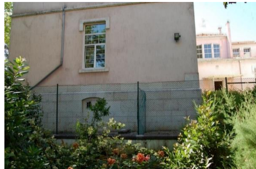
Figura 2.3.3. Rede de proteção que delimita o logradouro, localizado no tardoz [Fonte: Autora, Data: 31-05-2016]
