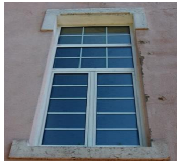
Figura 2.3.24. Caixilharia em PVC, Fachada Posterior [Fonte: Autora, Data: 01-09-2016]
