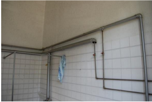
Figura 2.3.44. Tubagem na Instalação sanitária, no Piso 1 [Fonte: Autora, Data: 19-05-2016]
