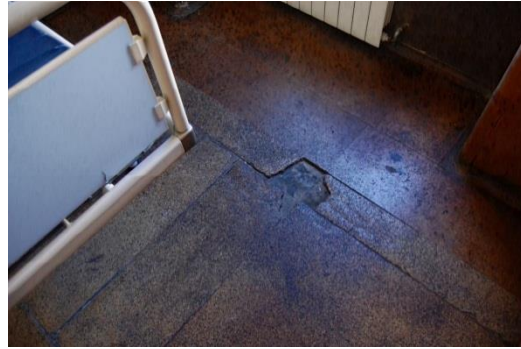
Figura 2.3.40. Revestimento em cortiça do pavimento do quarto nº30, no Piso 1 [Fonte: Autora, Data: 20-05-2016]
