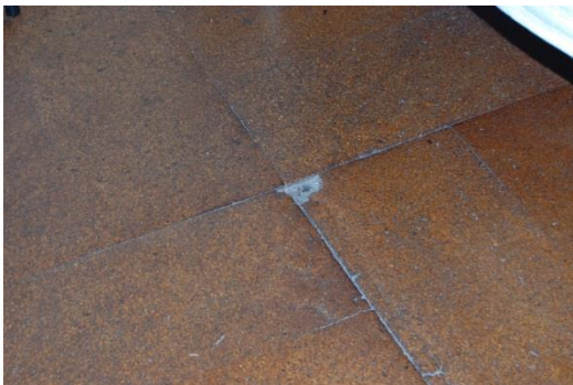
Figura 3.6.1. Quarto nº33, 1ºAndar [Fonte: Autora, Data: 30-05-2016]
