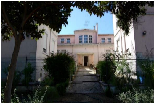
Figura 2.3.4. Acesso ao Edifício, pelo tardoz [Fonte: Autora, Data: 18-05-2016]
