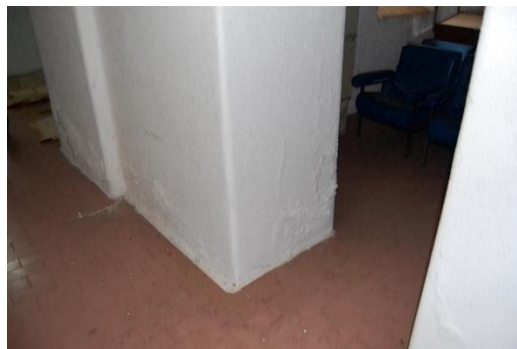
Figura 2.3.43. Revestimento em tijoleira no pavimento, em todo o Piso -1 [Fonte: Autora, Data: 23-06-2016]
