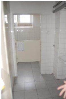
Figura 2.3.37. Revestimento da Parede Interior da Instalação Sanitária, no Piso 1 [Fonte: Autora, Data: 25-05-2016]
