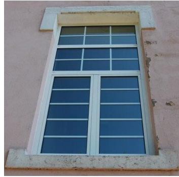
Figura 2.4.2. Caixilharias novas em PVC, localizada na Fachada Posterior (orientada a Sudoeste) [Fonte: Autora, Data: 01-09-2016]
