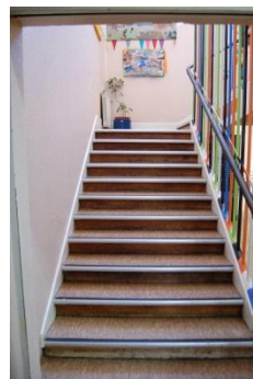
Figura 2.3.47. Segundo lanço de escadas [Fonte: Autora, Data: 20-05-2016]
