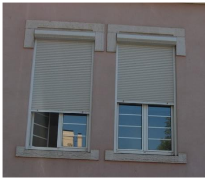
Figura 2.3.14. Guarnecimento dos vãos da janela [Fonte: Autora, Data: 31-05-2016]
