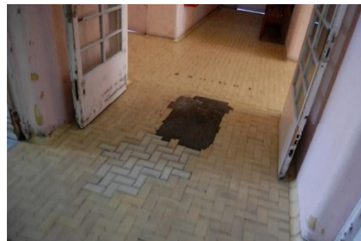
Figura 2.4.4. Substituição do ladrilho cerâmico, por outro com uma tonalidade semelhante, e reparação com betonilha, no núcleo central, corredor nº 25, do Piso 0 [Fonte: Autora, Data: 19-05-2016]
