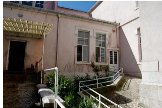
Figura 2.3.5. Rampa de acesso para mobilidade condicionada [Fonte: Autora, Data: 31-05-2106]
