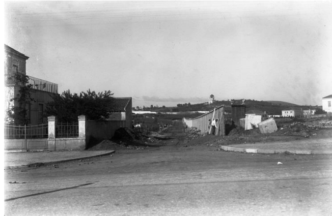
Figura 2.1.4. Início das Obras do “Novo Manicómio de Lisboa” [Fonte: Arquivo do C.H.P.L]
