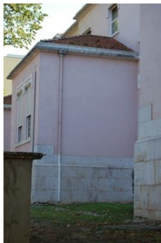
Figura 2.3.29. Tubo de queda na Fachada lateral Nascente [Fonte: Autora, Data: 01-09-2016]
