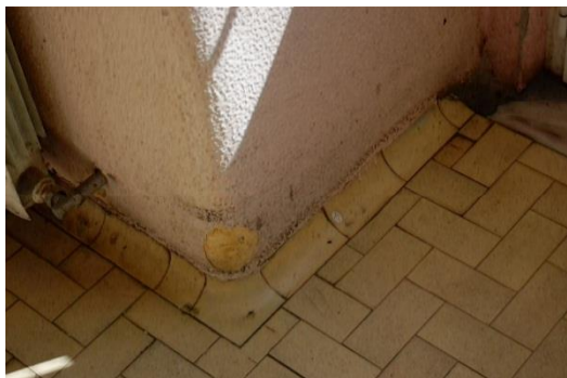
Figura 2.3.41. Revestimento em ladrilho cerâmico do pavimento no corredor da ala poente, Piso 0 [Fonte: Autora, Data: 19-05-2016]
