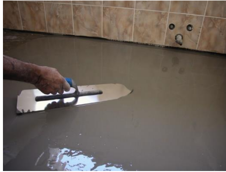
Figura 5.7.1. Regularização da planeza da betonilha com talocha [Fonte: Catálogo TOPECA]
