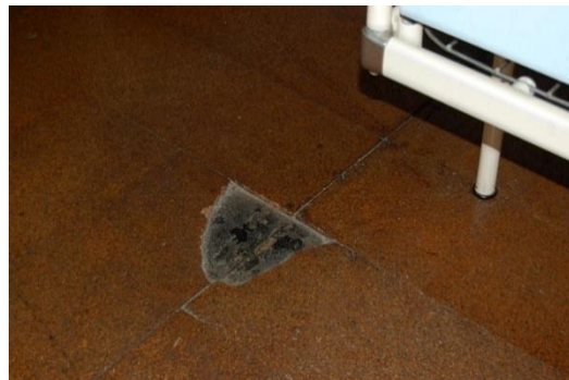
Figura 3.6.2. Quarto nº33, 1ºAndar [Fonte: Autora, Data: 30-05-2015]
