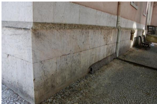
Figura 2.3.22. Forro de cantaria assente na base da frente das fachadas [Fonte: Autora, Data: 01-09-2016]
