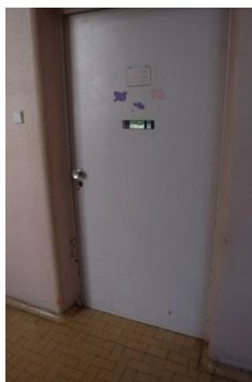
Figura 2.3.51. Porta de uma folha, do Quarto nº 49, localizada na ala nascente do Piso 0 [Fonte: Autora, Data: 19-05-2016]
