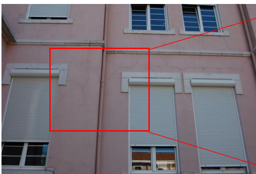
Figura 3.1.3. Fachada lateral poente (zona central) [Fonte: Autora, Data: 18-05-2016]
