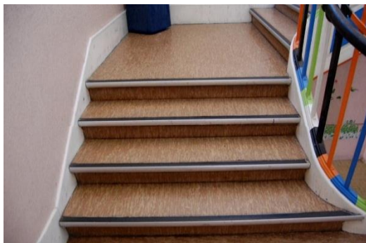
Figura 2.3.46. Primeiro Lanço de escadas [Fonte: Autora, Data: 20-05-2016]
