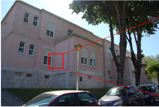
Figura 3.1.1. Fachada lateral poente (ala superior) [Fonte: Autora, Data: 18-05-2016]
