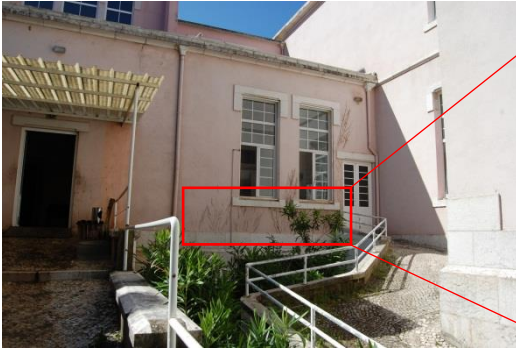
Figura 3.1.7. Fachada Posterior, acesso ao refeitório, pela rampa (à direita), e à sala de fumadores pelas escadas (à esquerda) [Fonte: Autora, Data:31-05-2016]
