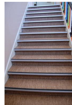
Figura 2.3.48. Terceiro lanço de escadas [Fonte: Autora, Data: 20-05-2016]
