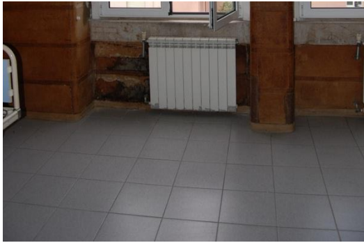
Figura 2.3.39. Revestimento em mosaico cerâmico do pavimento do quarto nº13, no Piso 1 [Fonte: Autora, Data: 25-05-2016]
