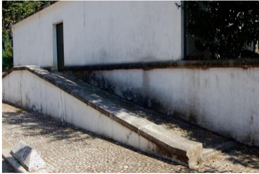
Figura 2.3.18. Acesso ao tardoz do Edifício, capeamento num muro junto à rampa [Fonte: Autora, Data: 01-09-2016]
