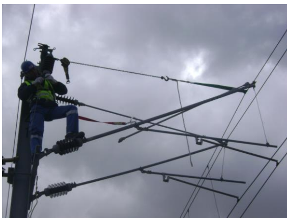
Figura 3.5 – Substituição de isoladores
