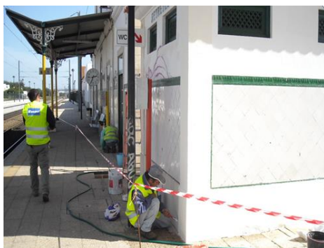
Figura 3.8 – Remoção de Graffitis
